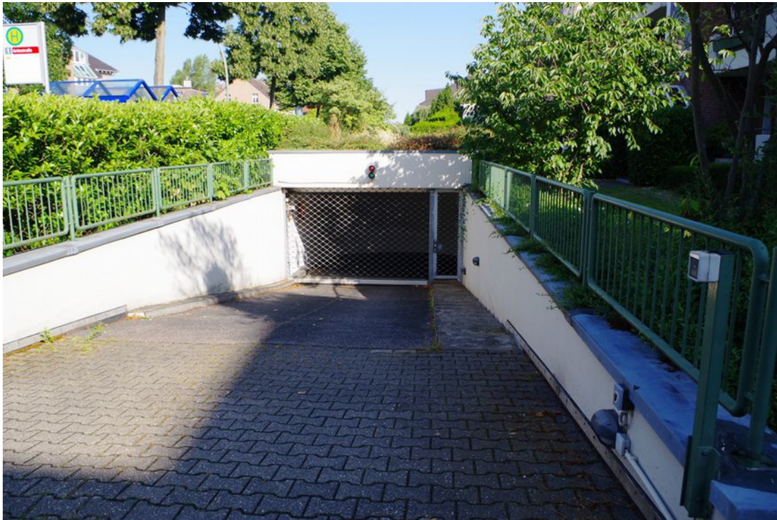
Bild 3: Detailansicht der Tiefgaragenzufahrt
