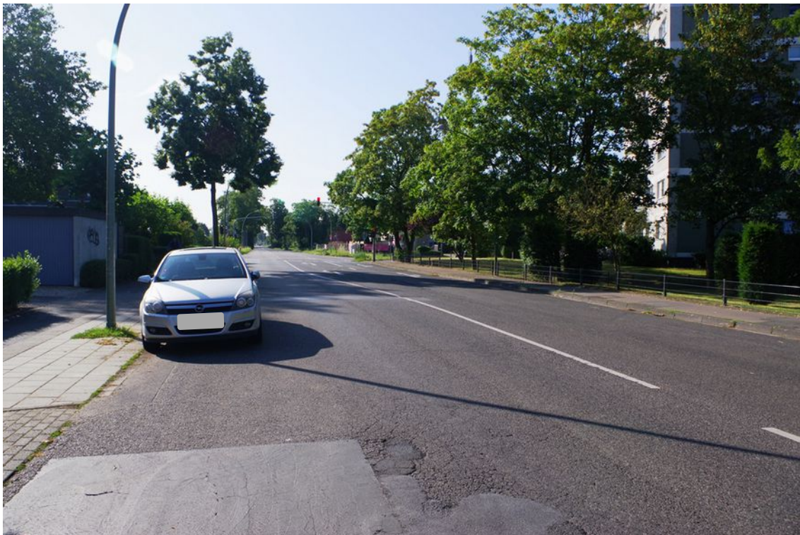
Bild 6: Blick in die Düsseldorfer Straße Richtung Südost
