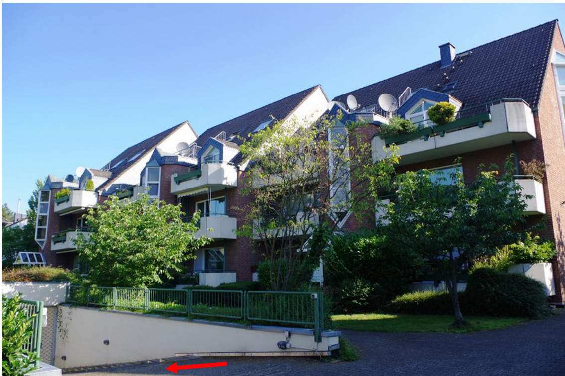
Bild 2: Übersichtsaufnahme der aufstehenden Bebauung auf dem Grundstück mit Ansicht der Tiefgaragenzufahrt
