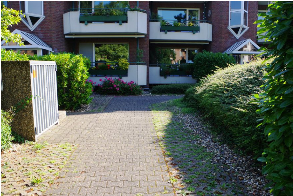
Bild 4: Ansicht der Zuwegung zu den Wohnhäusern Düsseldorfer Straße 146-150
