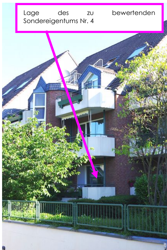
Bild 2: Ansicht des Gebäudes Düsseldorfer Straße 148 aus Südost mit Lagekennzeichnung der Bewertungswohnung
