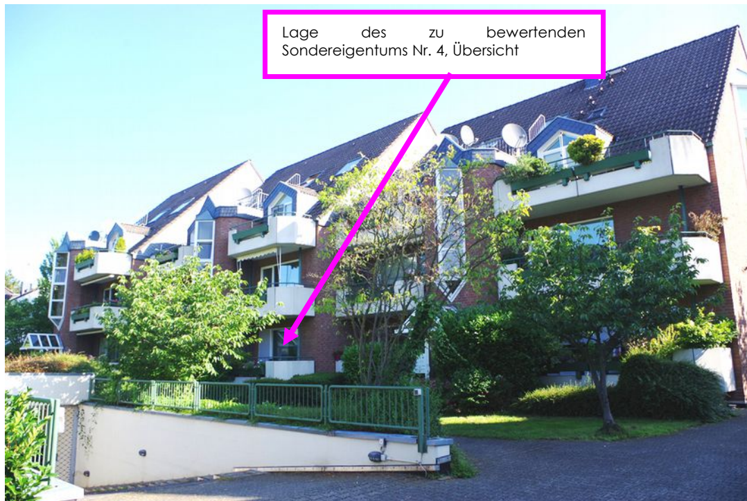
Bild 1: Übersichtsaufnahme der Gebäude Düsseldorfer Straße 146-150 mit Lagekennzeichnung der Bewertungswohnung
