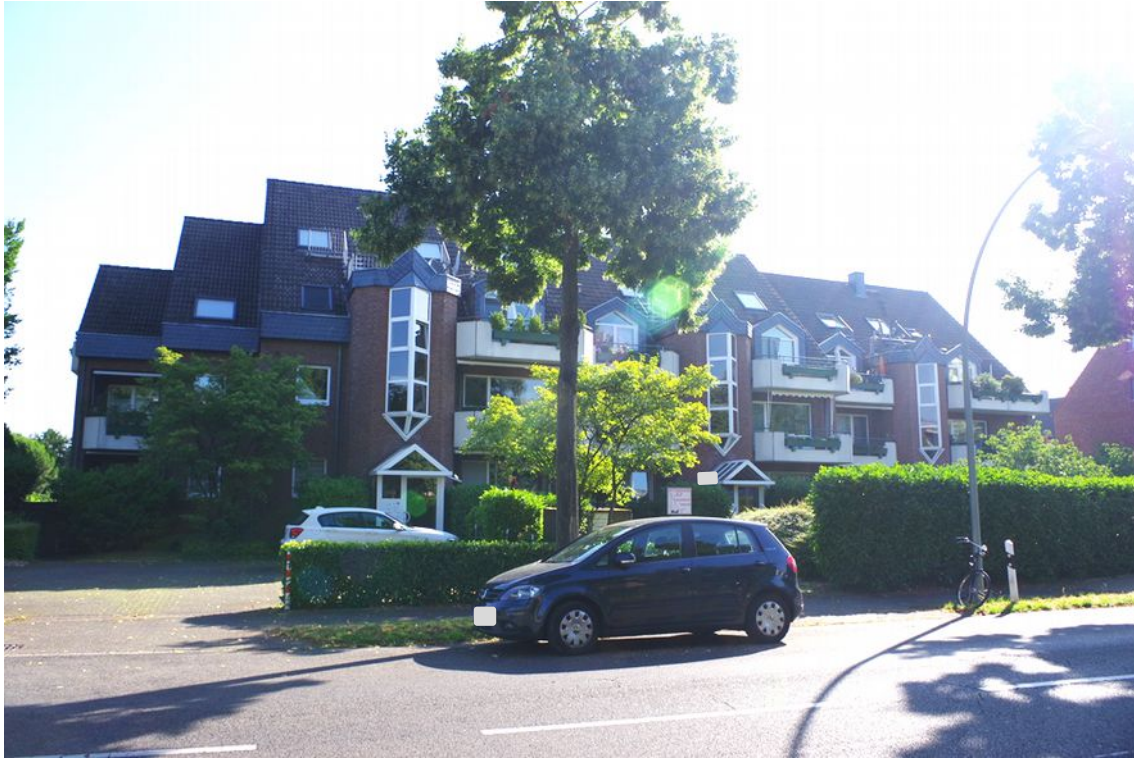
Bild 1: Straßenansicht der aufstehenden Bebauung auf dem Grundstück, Düsseldorfer Straße 146-150
