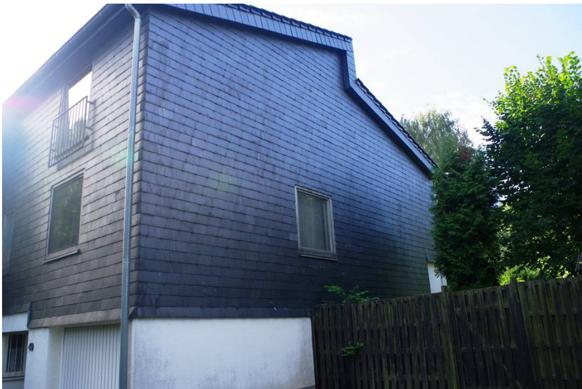
Bild 2: Seitenansicht des Einfamilienhauses aus West
