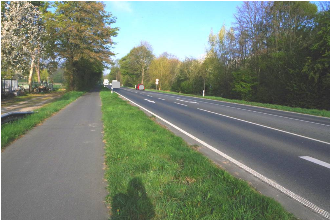
Bild 6: Blick in die nördlich des Grundstücks verlaufende L381 in Richtung West
