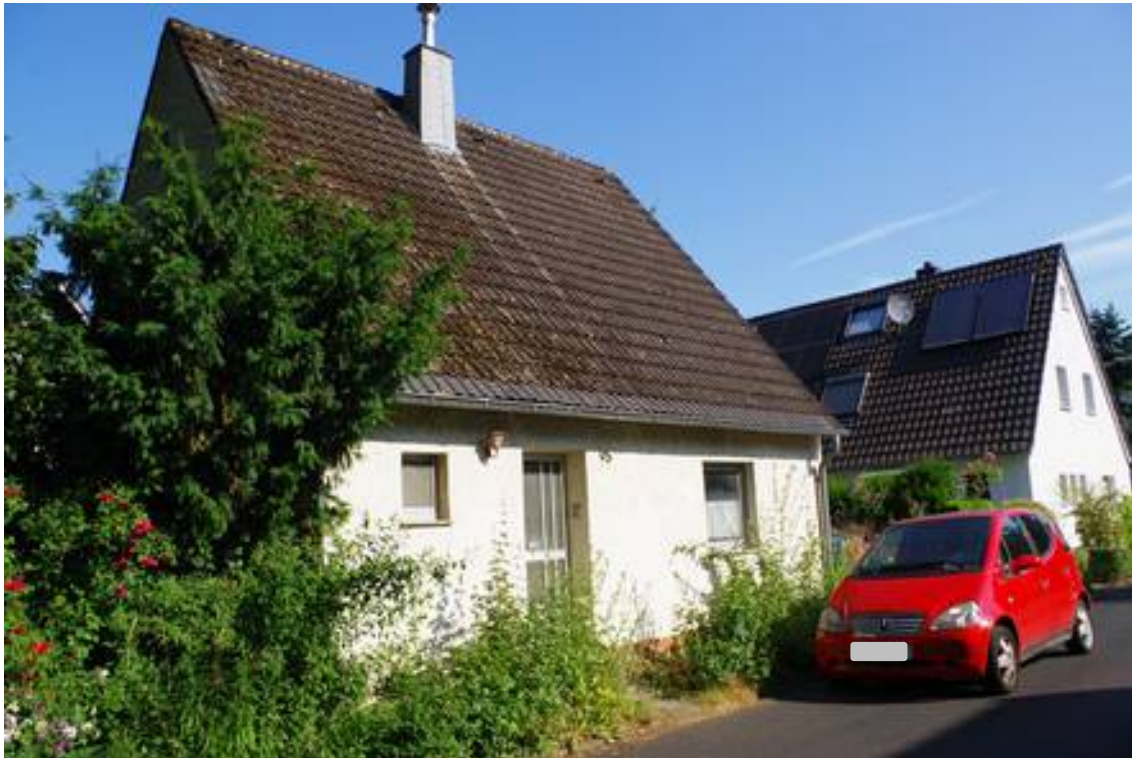
Bild 1: Straßenansicht des Bewertungsgrundstücks aus Südost
