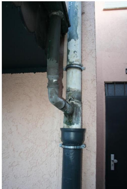
Bild 12: schadhaftes Regenfallrohr
