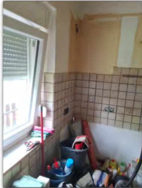
Foto 18: EG - ehemalige Küche
