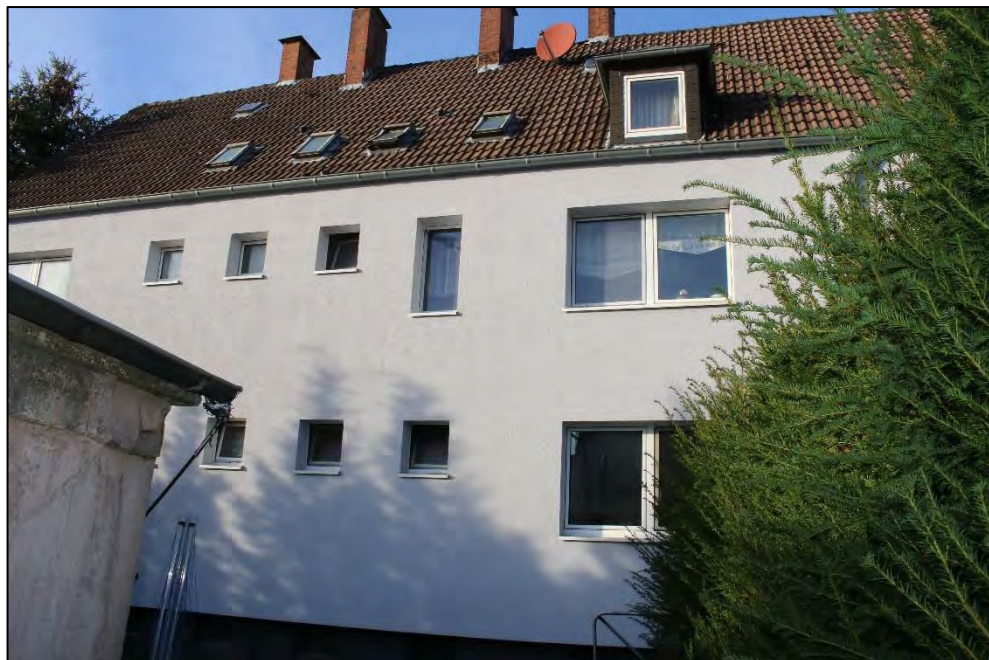
Foto Nr. 4: Gartenfassade
