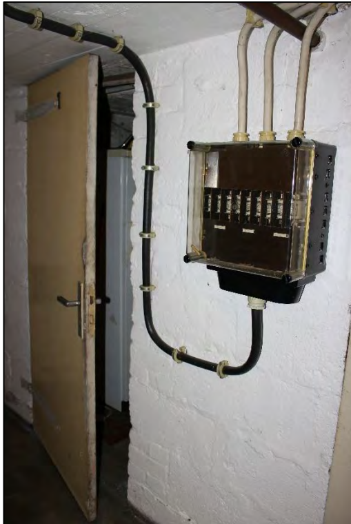
Foto Nr. 15: Kellergeschoss, Flur
