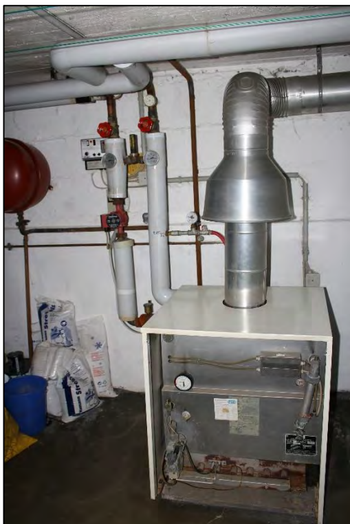
Foto Nr. 16: Kellergeschoss, Heizungsraum / Waschküche
