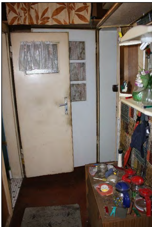
Foto Nr. 30: Erdgeschoss links, WE Nr. 1, Diele
