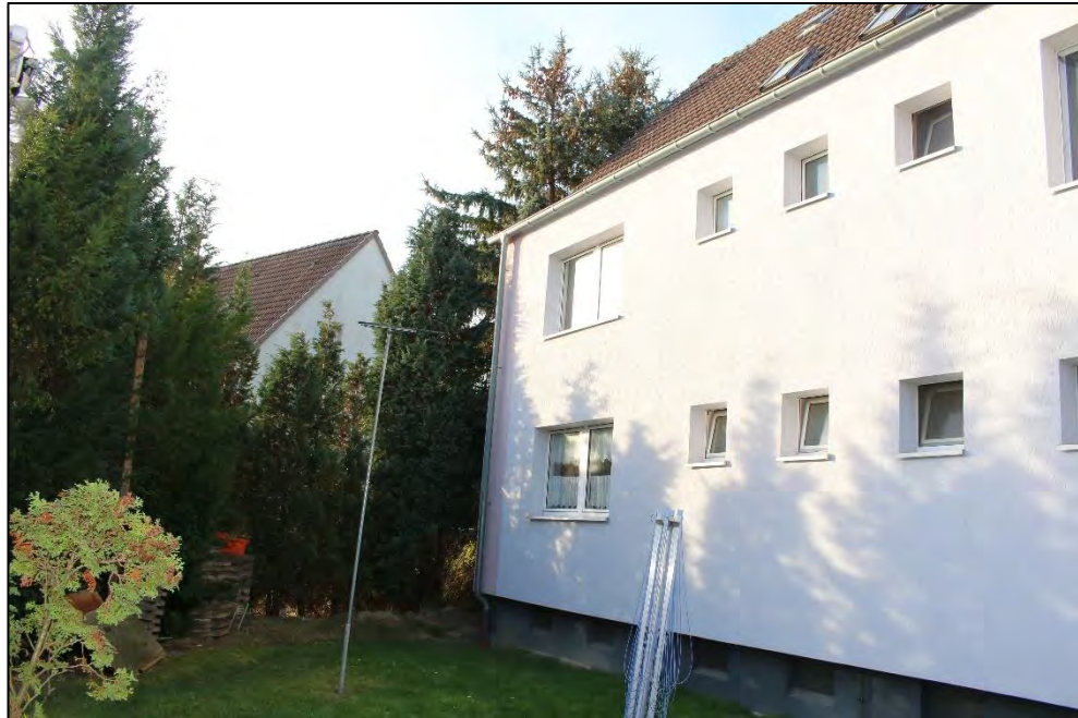
Foto Nr. 5: Gartenfassade
