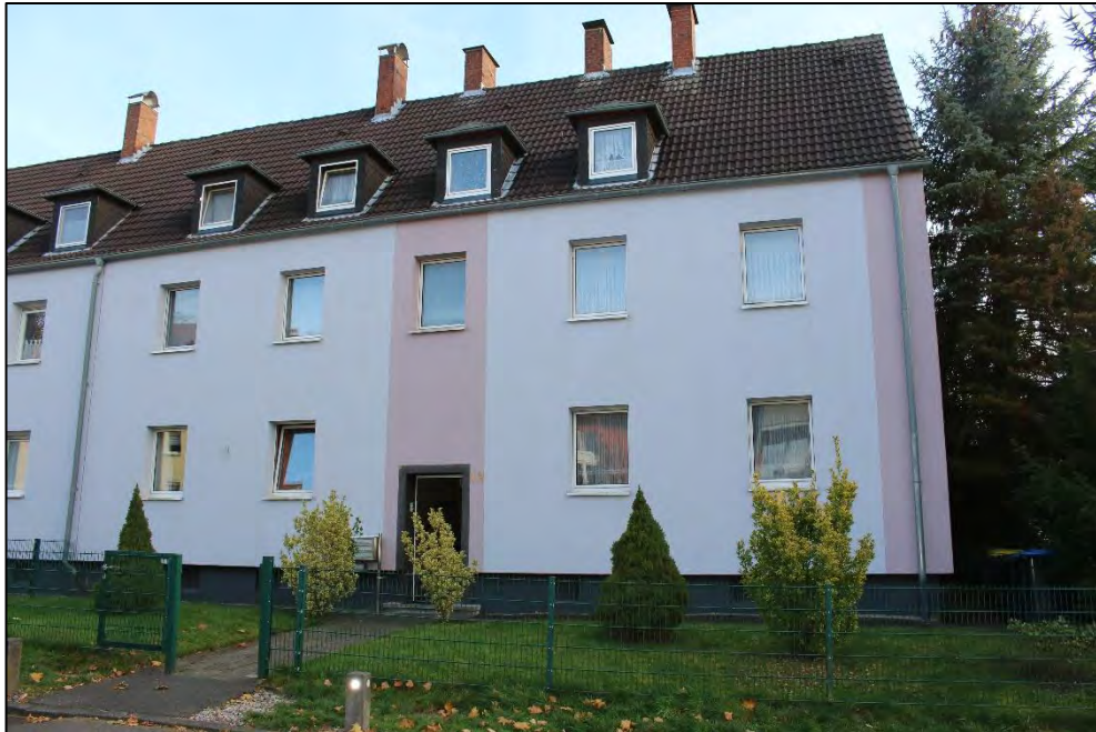
Foto Nr. 1: Straßenfassade
