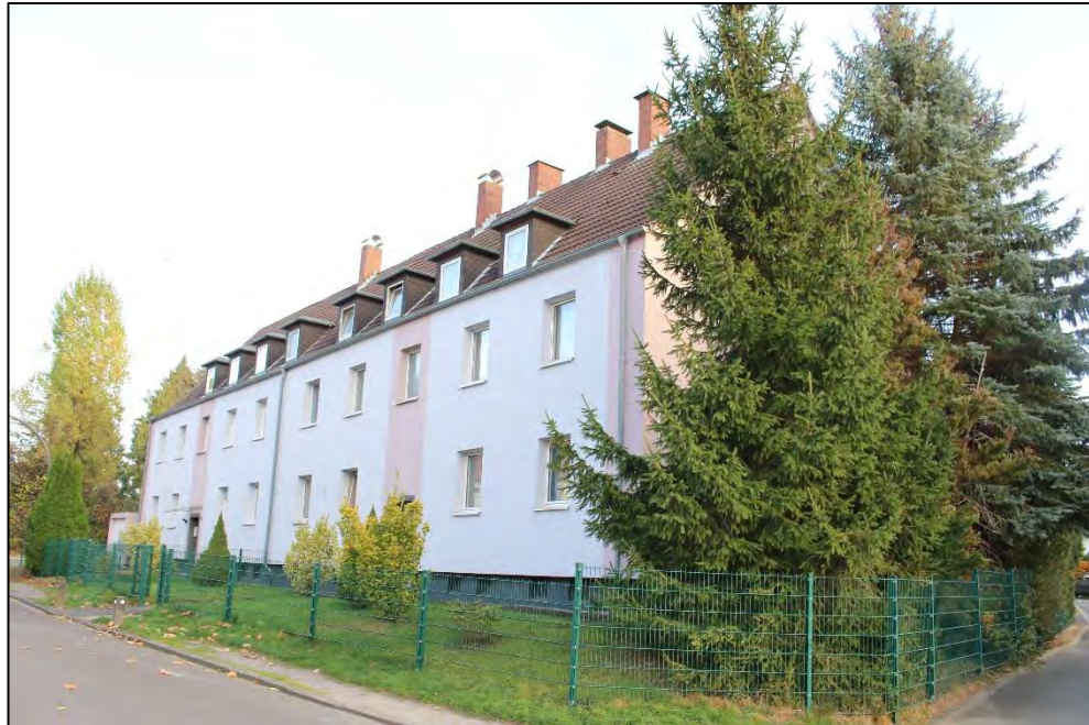
Foto Nr. 3: Straßenfassade
