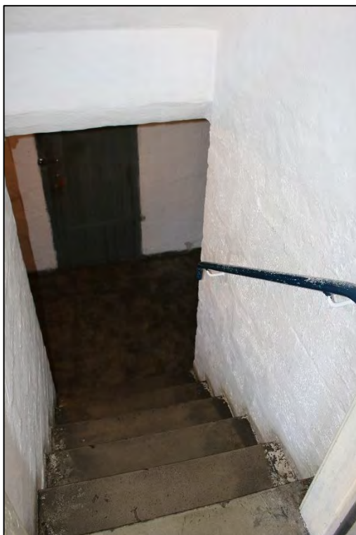
Foto Nr. 14: Treppe zum Kellergeschoss
