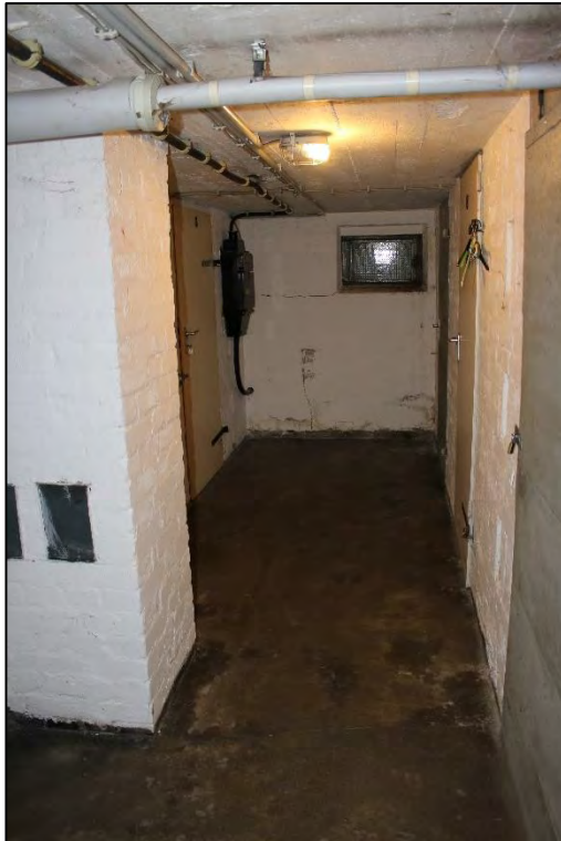
Foto Nr. 21: Kellergeschoss, Flur
