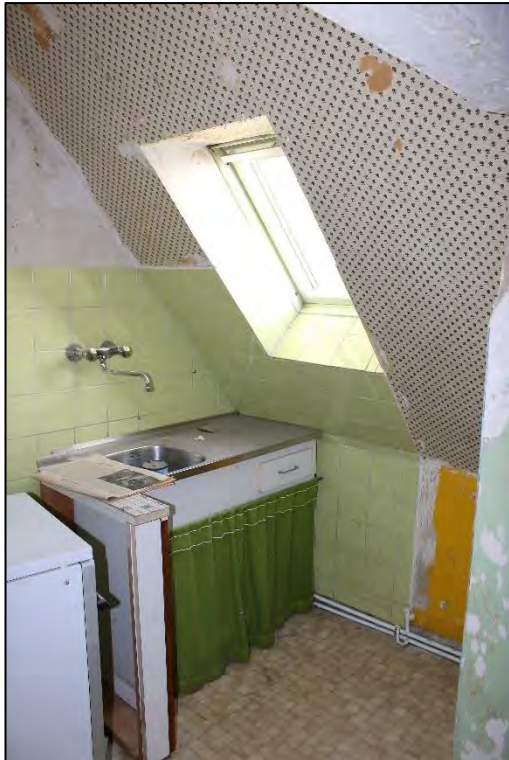
Foto Nr. 67: Dachgeschoss rechts, WE Nr. 6, Kochnische
