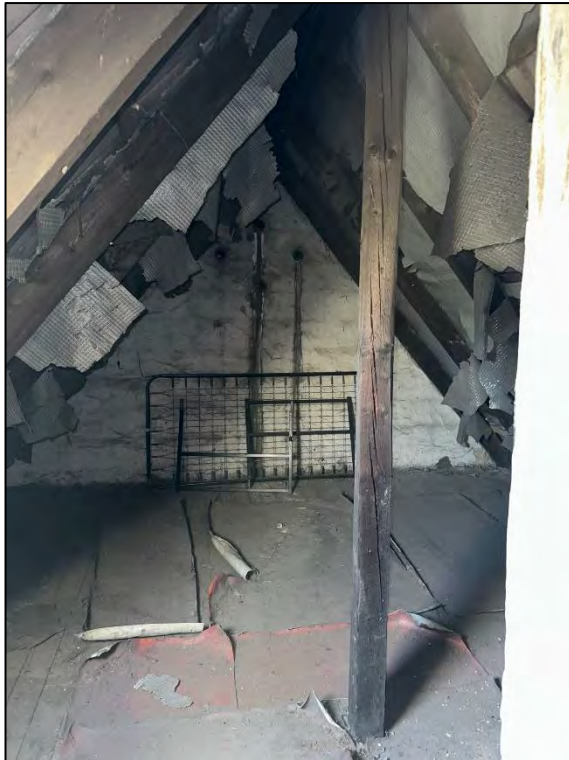
Foto Nr. 73: Dachboden
