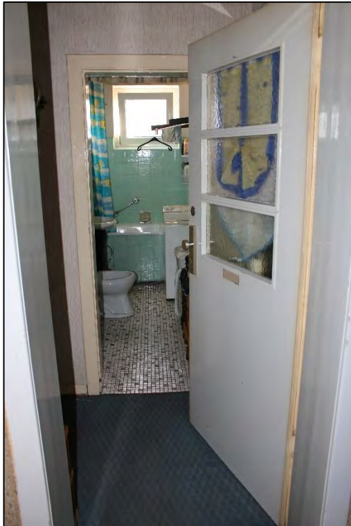
Foto Nr. 47: 1. OG links, WE Nr. 3, Eingang
