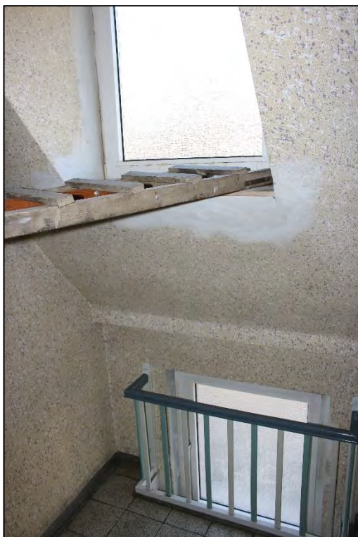
Foto Nr. 54: Gemeinschaftstreppe, Dachgeschoss
