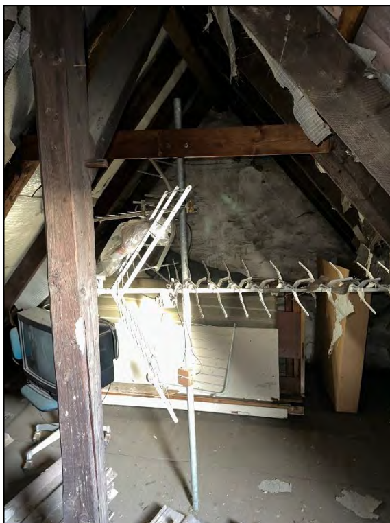
Foto Nr. 70: Dachboden
