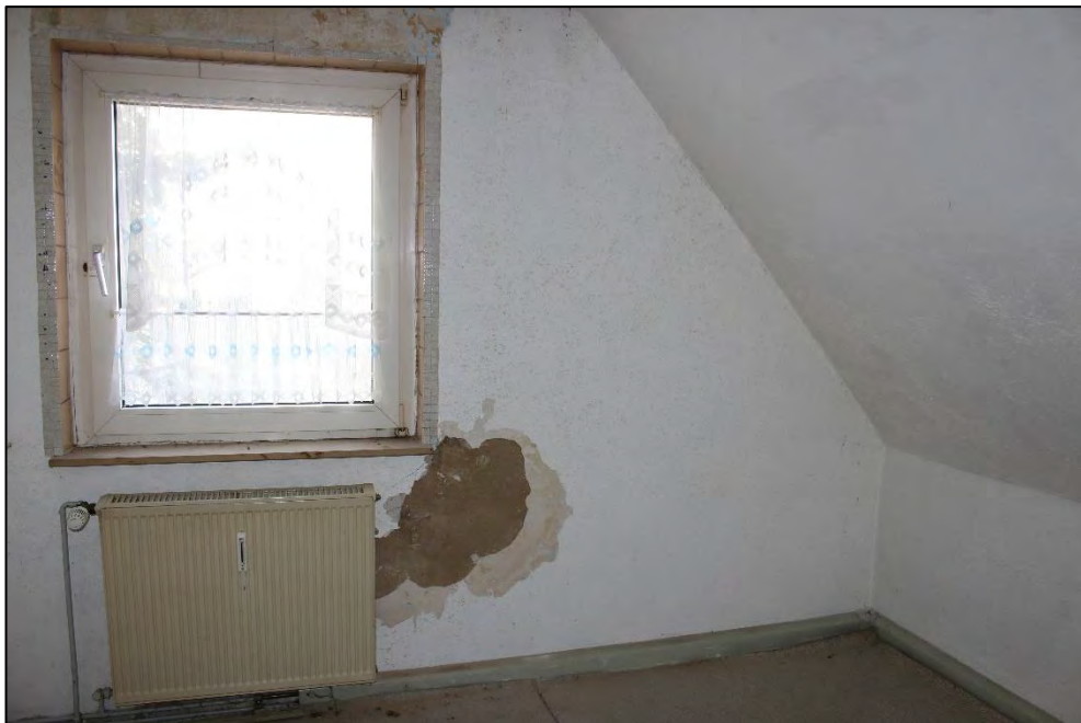
Foto Nr. 68: Dachgeschoss rechts, WE Nr. 6, Schlafzimmer
