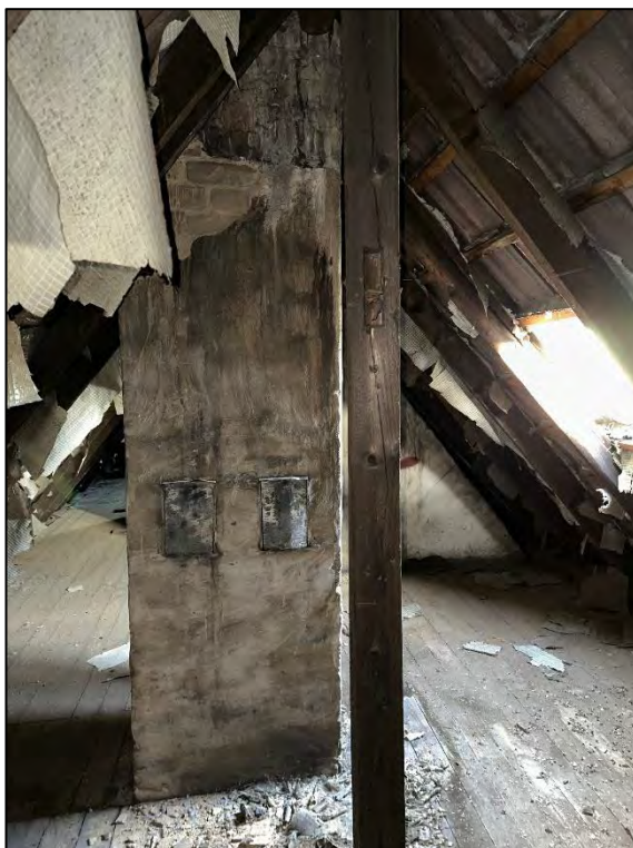
Foto Nr. 74: Dachboden
