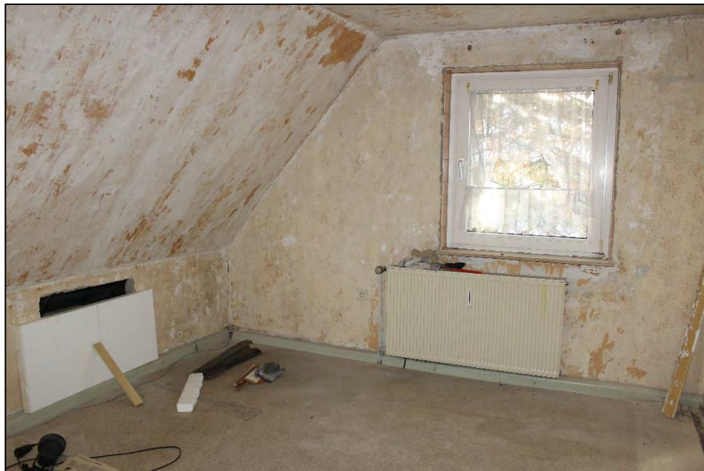
Foto Nr. 65: Dachgeschoss rechts, WE Nr. 6, Wohnzimmer
