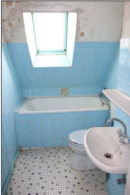
Foto Nr. 63: Dachgeschoss rechts, WE Nr. 6, Bad
