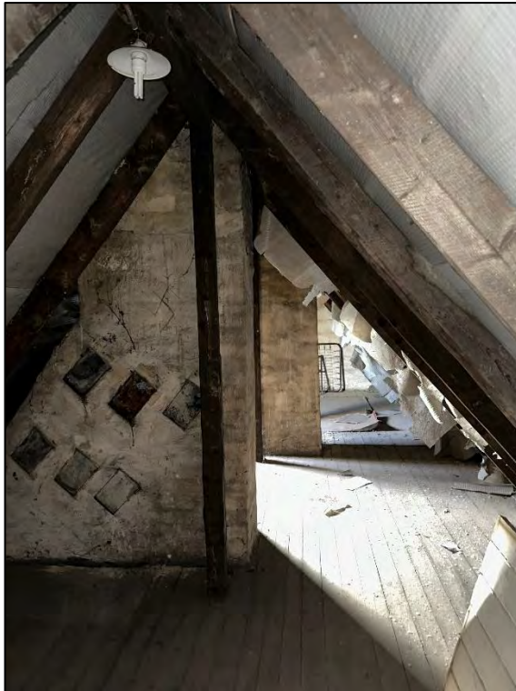
Foto Nr. 71: Dachboden
