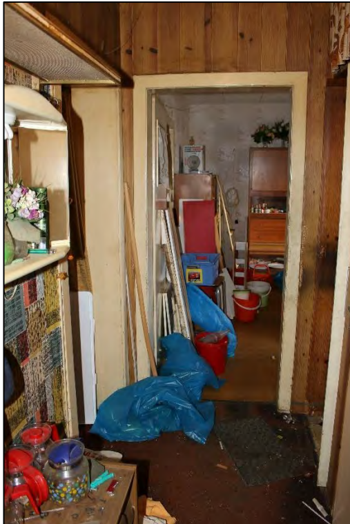
Foto Nr. 37: Erdgeschoss links, WE Nr. 1, Diele
