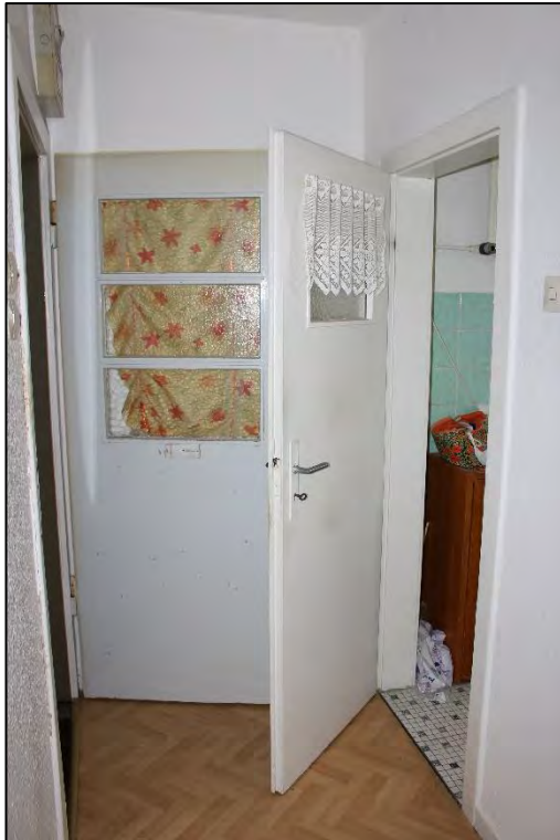
Foto Nr. 39: Erdgeschoss rechts, WE Nr. 2, Diele
