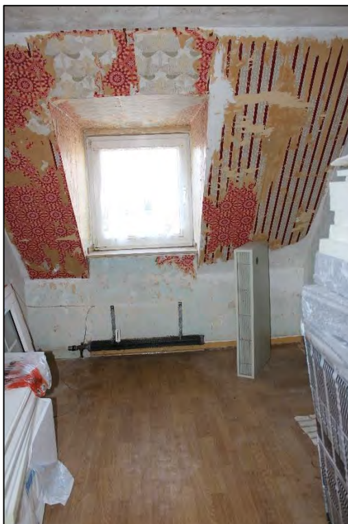
Foto Nr. 64: Dachgeschoss rechts, WE Nr. 6, Kinderzimmer
