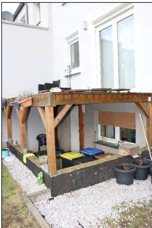
Foto Nr. 4: Gartenfassade / Balkon
