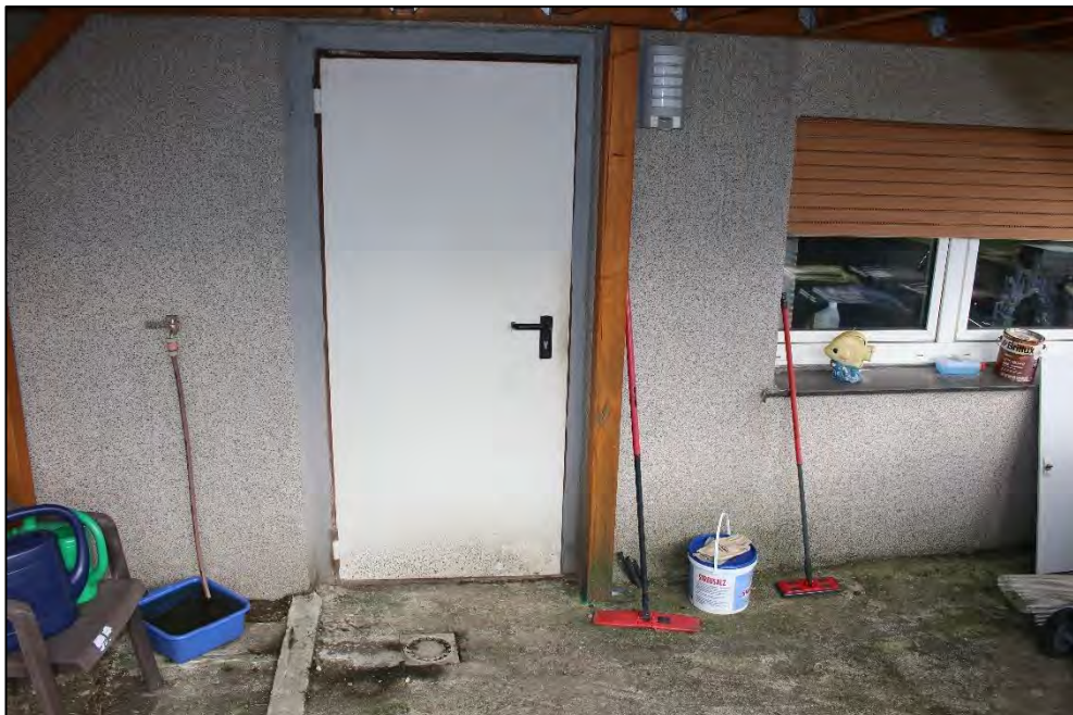
Foto Nr. 6: Kelleraußeneingang
