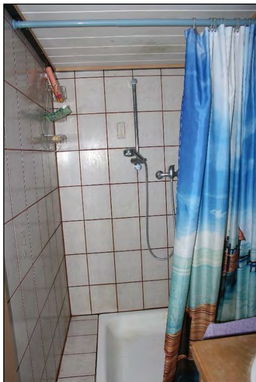
Foto Nr. 26: Kellergeschoss, Duschbad
