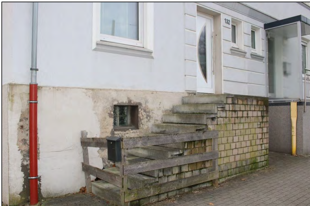
Foto Nr. 2: Hauseingangstreppe
