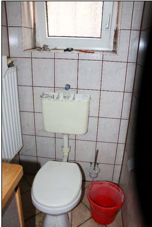
Foto Nr. 27: Kellergeschoss, Duschbad
