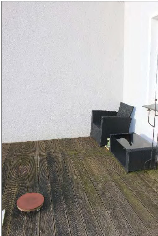
Foto Nr. 33: Erdgeschoss, Balkon
