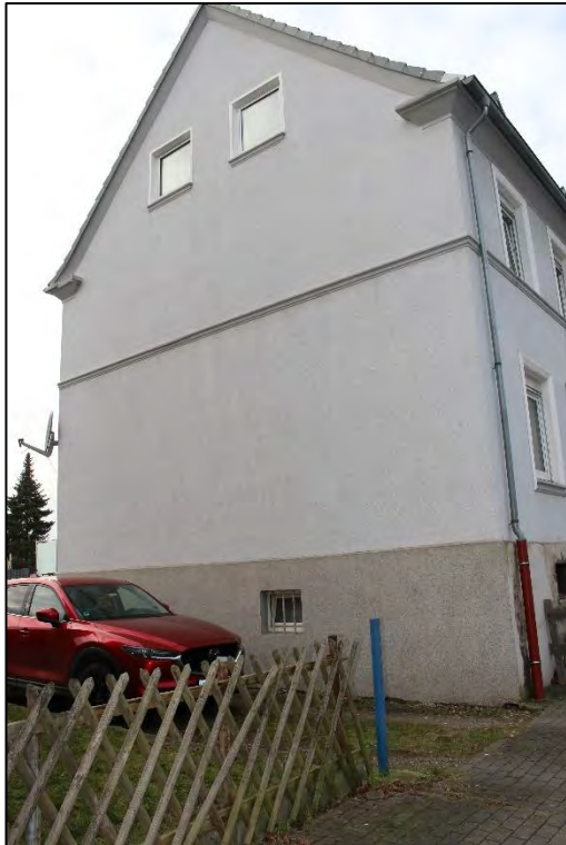
Foto Nr. 3: Seitenfassade
