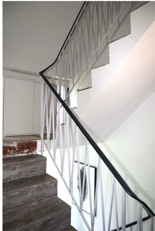
Foto 9: Treppe zum Dachgeschoss
