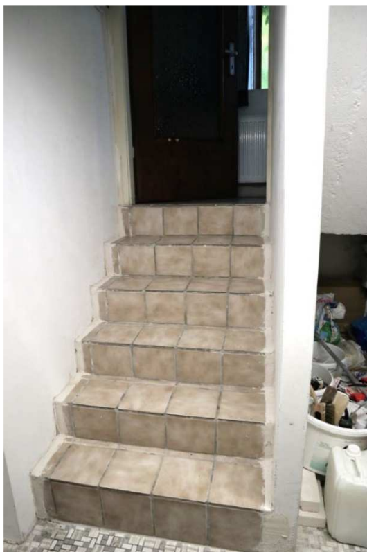
Foto 10: Treppe zum Keller
