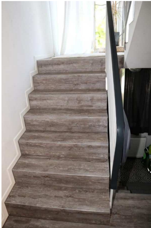
Foto 8: Treppe zum Obergeschoss
