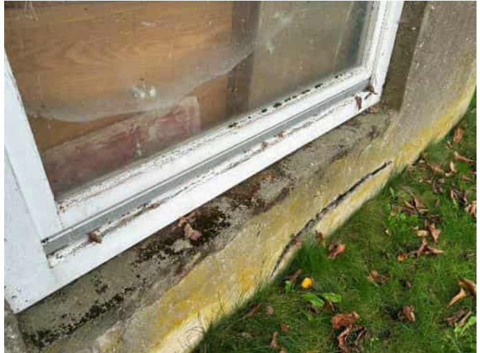
Detail Schäden/Instandhaltungsrückstand
