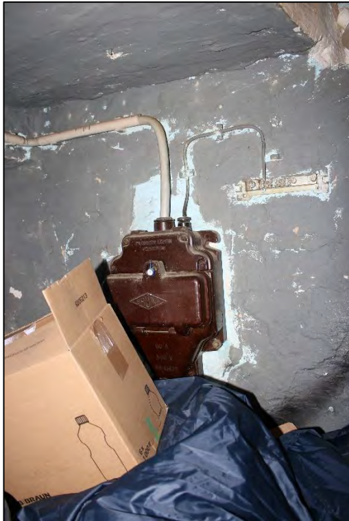
Foto Nr. 37: Kellergeschoss, Stromhausanschluss
