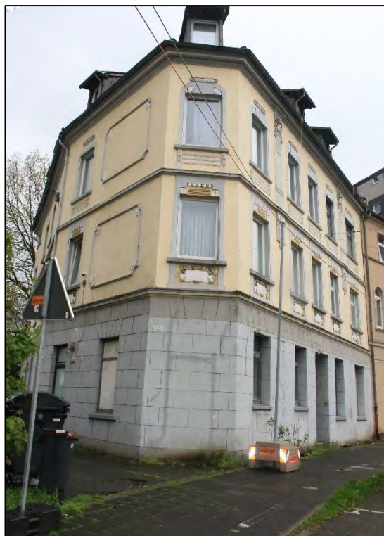
Foto Nr. 4: Straßen- und Seitenfassade
