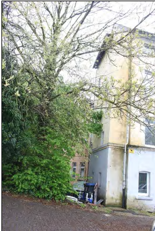
Foto Nr. 9: Hoffassade
