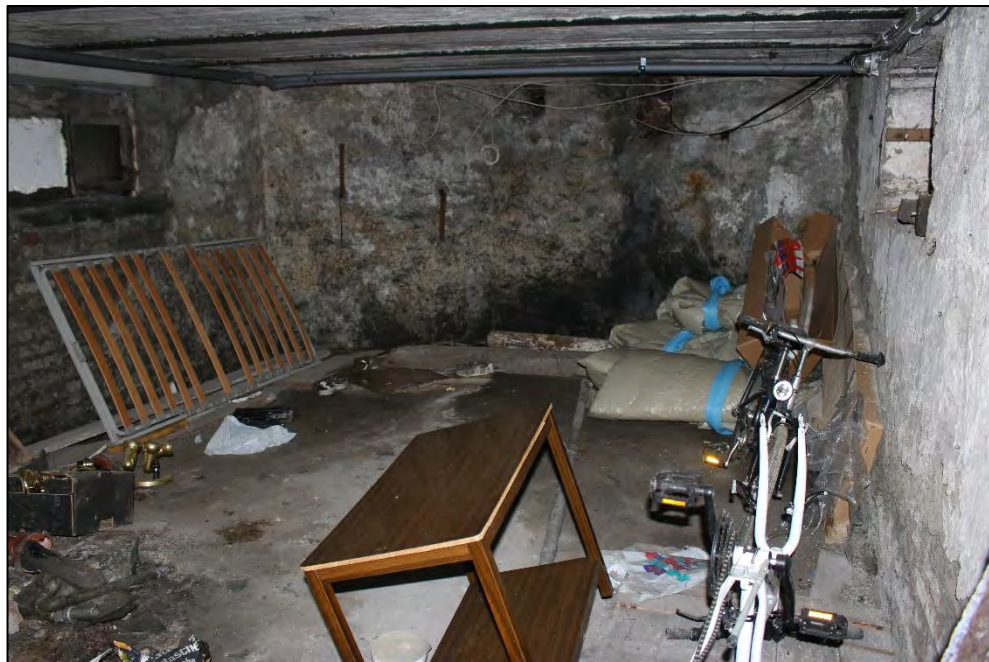
Foto Nr. 21: Kellergeschoss, Kellerraum
