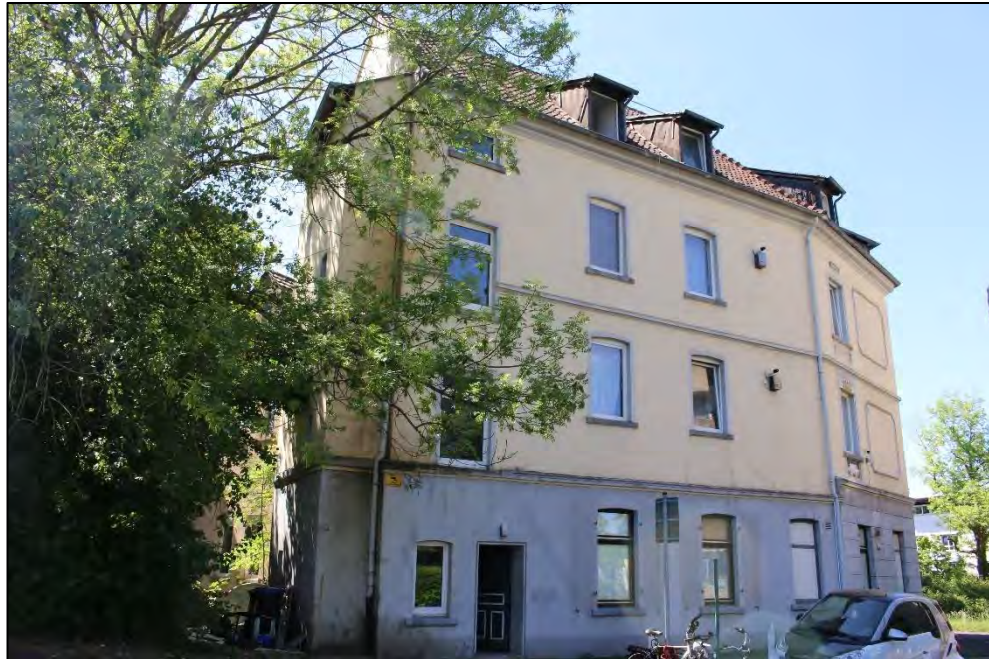
Foto Nr. 3: Seitenfassade
