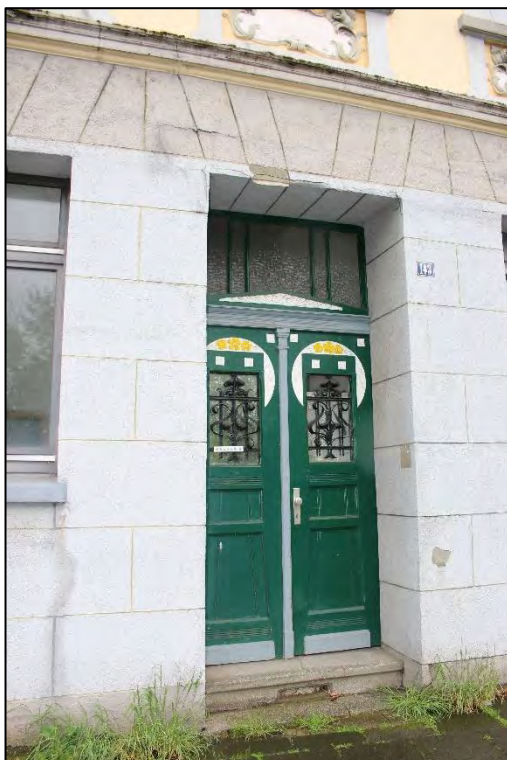
Foto Nr. 6: Straßenfassade, Eingang Einheit Erdgeschoss
