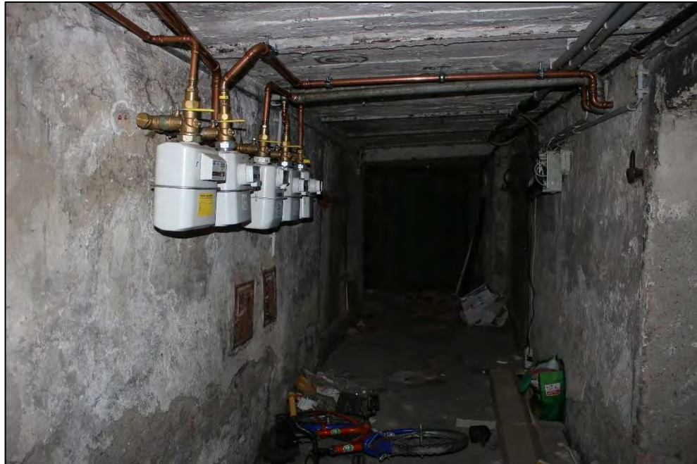
Foto Nr. 15: Kellergeschoss, Flur
