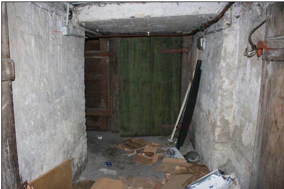
Foto Nr. 14: Kellergeschoss, Flur
