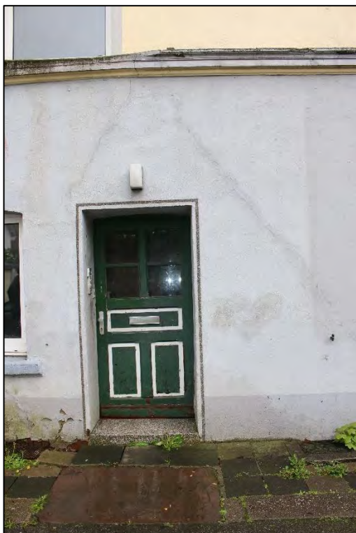
Foto Nr. 10: Seitenfassade, Hauseingang Gemeinschaftstreppehaus
