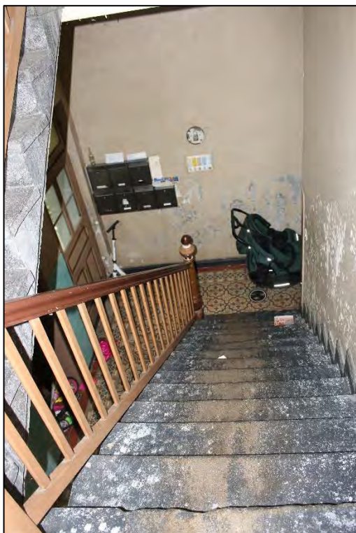
Foto Nr. 26: Gemeinschaftstreppehaus, Treppe zum 1. OG
