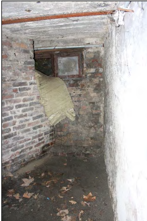
Foto Nr. 19: Kellergeschoss, Kellerraum
