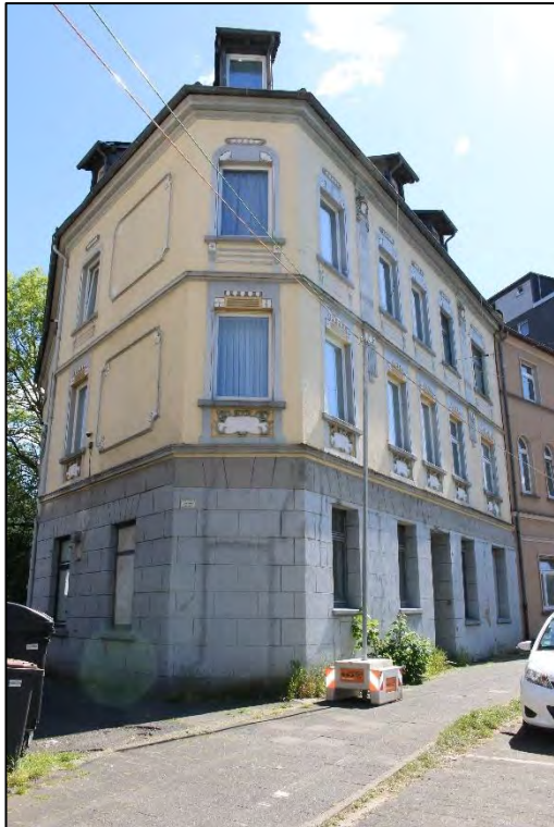
Foto Nr. 1: Straßen- und Seitenfassade
