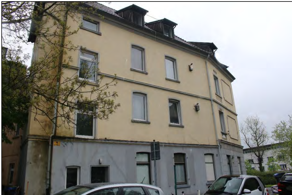
Foto Nr. 8: Seitenfassade
