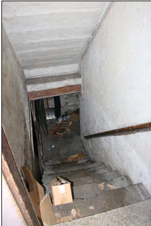
Foto Nr. 13: Treppe zum Kellergeschoss
