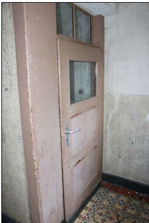
Foto Nr. 12: Gemeinschaftstreppe, Tür zum Kellerabgang
