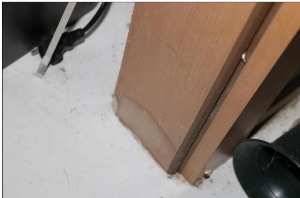
Foto Nr. 20: Kellergeschoss, Feuchteschäden Innentüren
