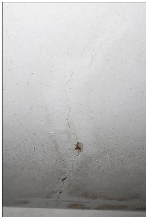
Foto Nr. 6: Garage innen, Feuchteschäden Decke
