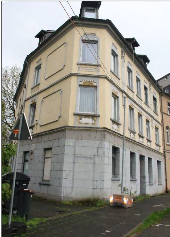
Foto Nr. 1: Straßen- und Seitenfassade
