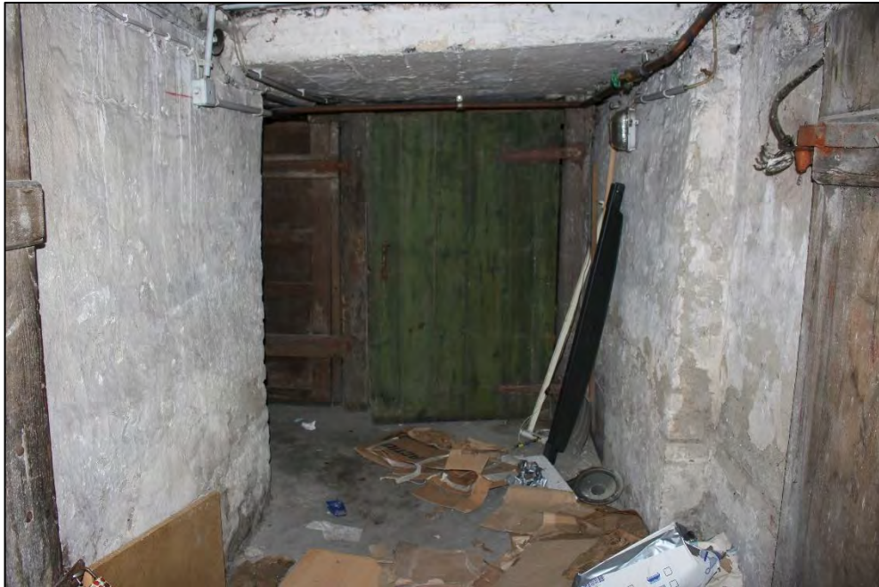
Foto Nr. 11: Kellergeschoss, Flur
