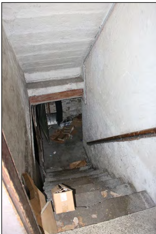
Foto Nr. 10: Treppe zum Kellergeschoss
