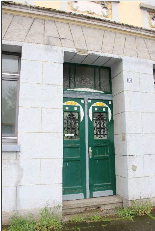
Foto Nr. 3: Straßenfassade, Eingang Einheit Erdgeschoss
