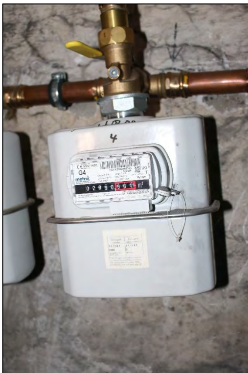
Foto Nr. 12: Kellergeschoss, Flur / Gaszähler ETW Nr. 4
