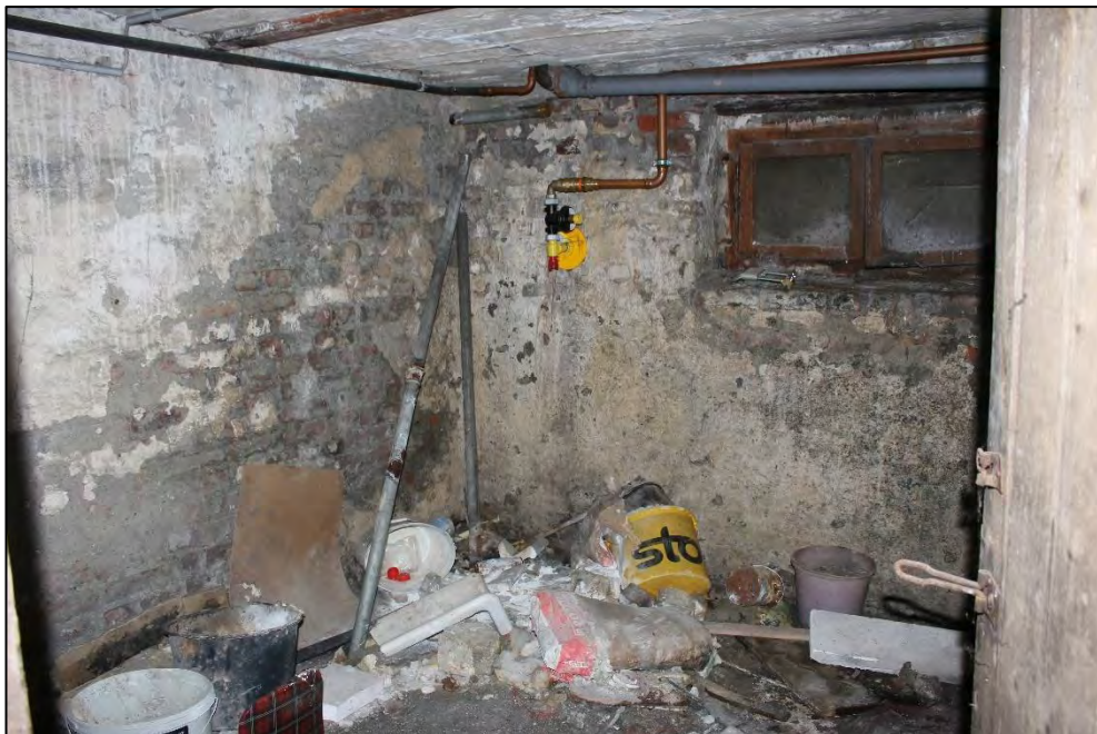
Foto Nr. 16: Kellergeschoss, Kellerraum / Gashausanschluss
