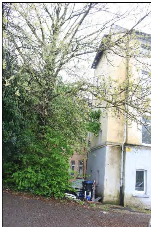
Foto Nr. 6: Hoffassade
