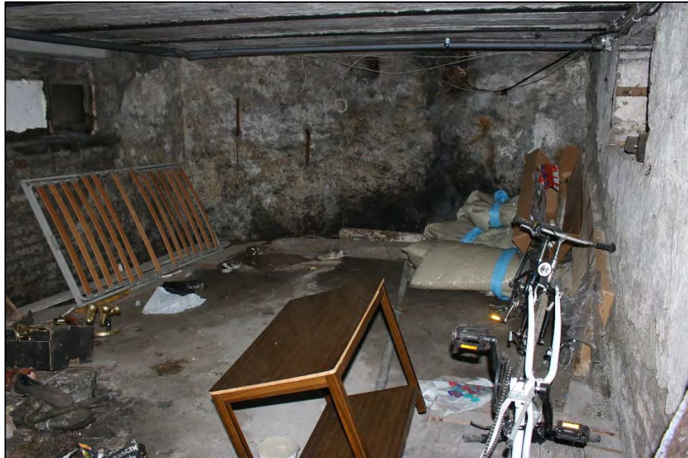
Foto Nr. 19: Kellergeschoss, Kellerraum
