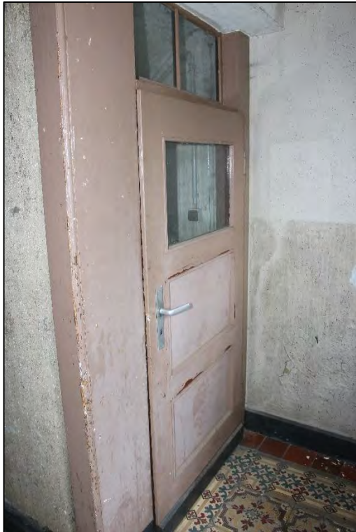
Foto Nr. 9: Gemeinschaftstreppehaus, Tür zum Kellerabgang
