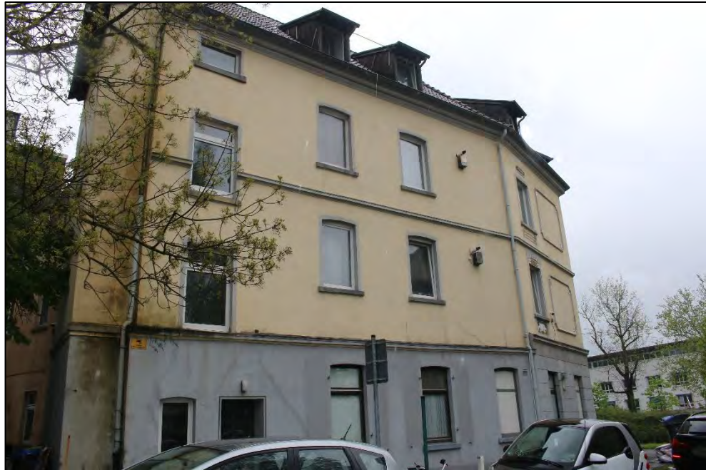
Foto Nr. 5: Seitenfassade
