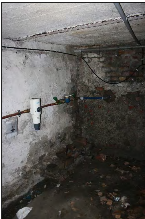
Foto Nr. 18: Kellergeschoss, Kellerraum / Wasserhausanschluss
