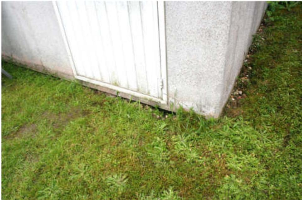
Bild 5: unterspültes Fundament der Einzelgarage
