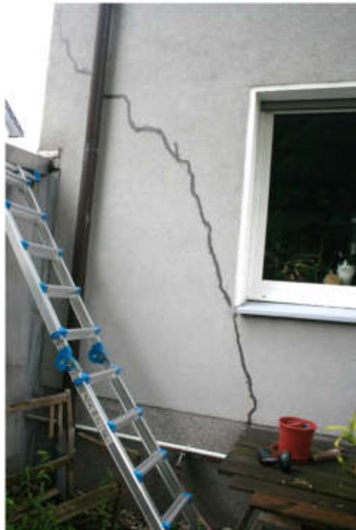
Bild 20: verpresste Rissbildungen MFH Rückansicht
