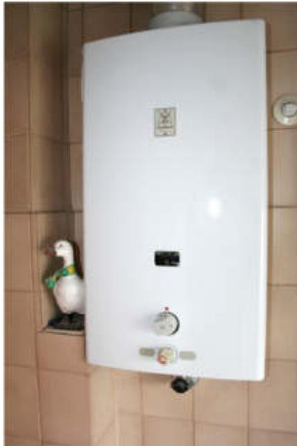
Bild 37: Gasboiler zur Warmwasserversorgung
