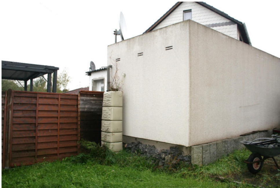
Bild 9: Rück- und Seitansicht der Garage / West- und Südansicht
