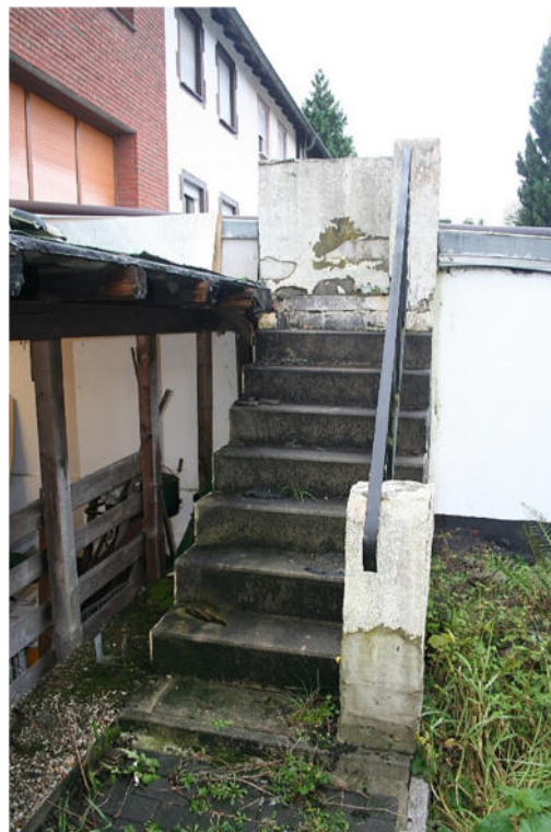
Bild 12: Treppe zur Balkonfläche
