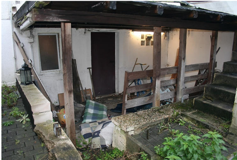
Bild 11: rückseitige Terrassenfläche vor dem Kellerausgang mit darüber liegendem Balkon
