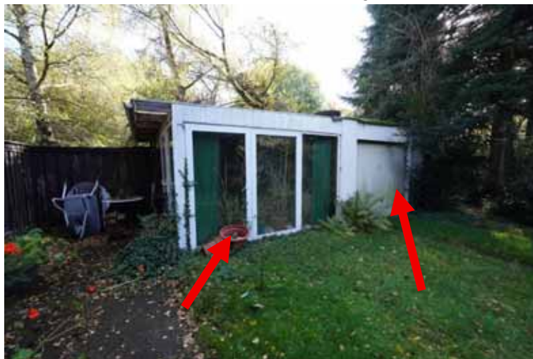
Bauteil 7 und Bauteil 6 (Fertiggarage)
