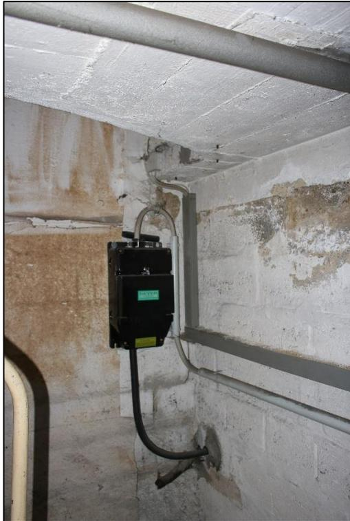
Foto Nr. 29: Kellergeschoss, Stromhausanschluss
