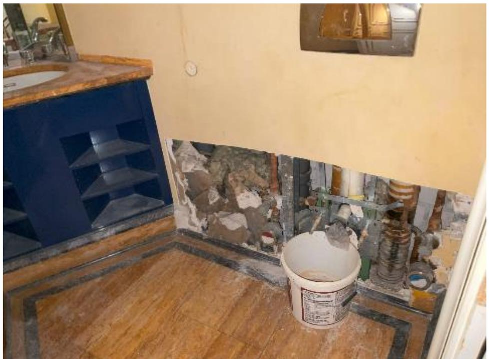
Lichtbild 18: Detail, Teilrückbau der sanitäre Einrichtungen im WC der zu bewertenden Wohnung (Dachgeschoss)
