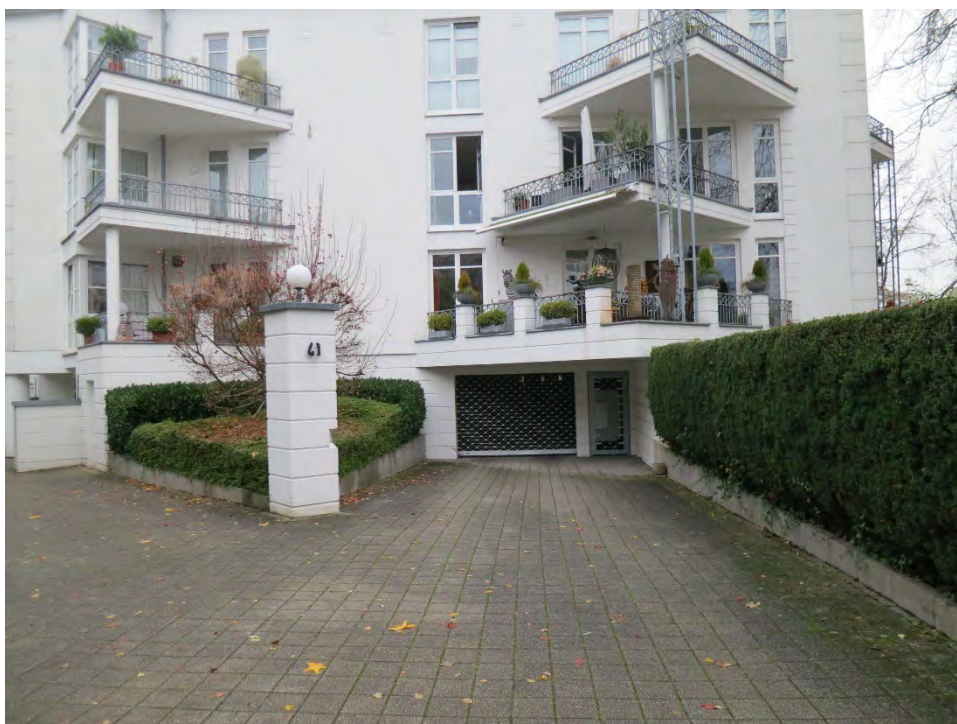
Lichtbild 6: Detail, Tiefgaragenzufahrt
