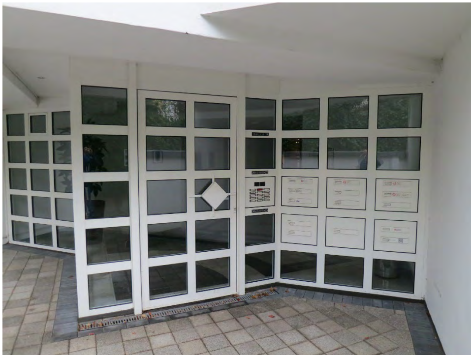
Lichtbild 5: Detail, Hauseingangtüranlage
