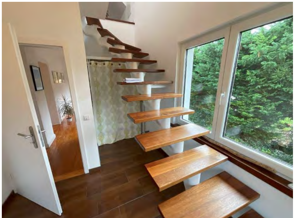
Lichtbild 24: Detail, Geschosstreppe Obergeschoss/Dachgeschoss
