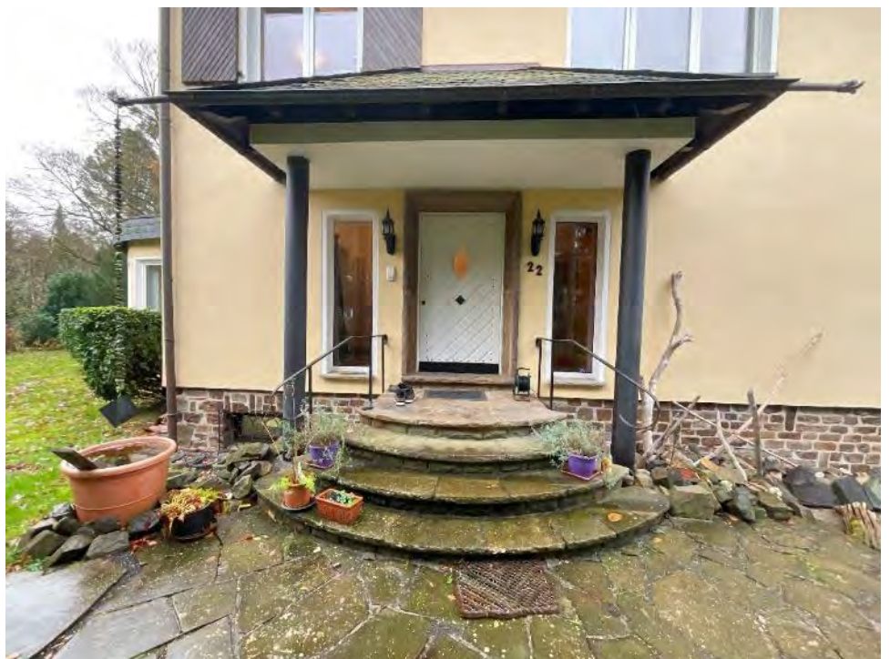
Lichtbild 8: Detail, Hauseingangstüranlage
