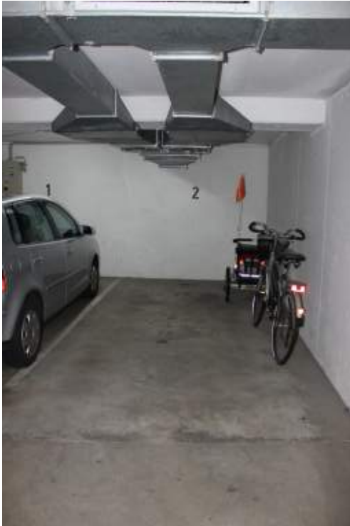
Bild 21: Tiefgarage: Pkw-Einstellplatz Nr. 2
