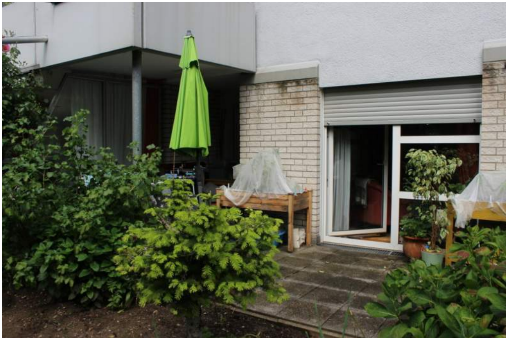
Bild 23: Erdgeschoss: Terrasse der Wohnung Nr. 2
