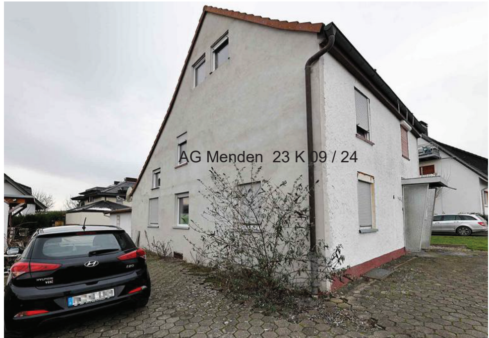
Foto Nr. 1 Giebelansicht
