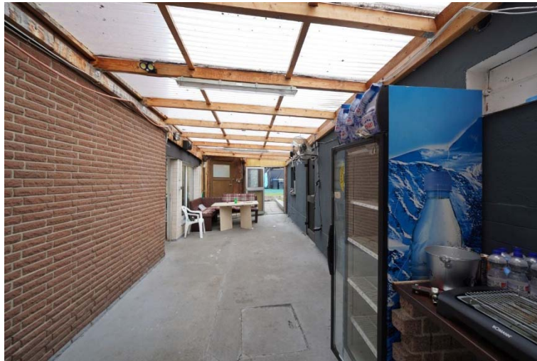
Überdachter Innenhof zwischen Garage und BT 1
