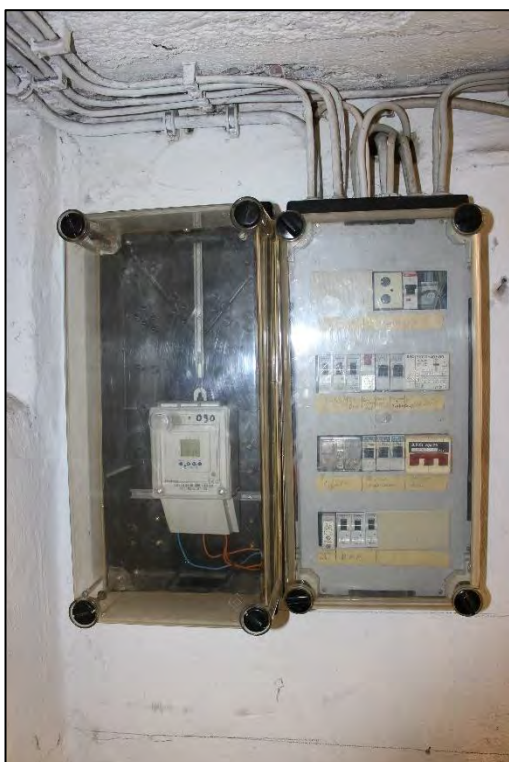
Foto Nr. 22: Kellergeschoss, Elektroverteilung
