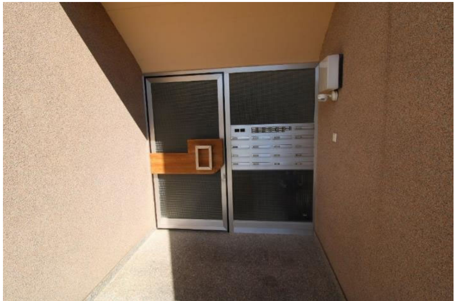
Sicht von der Zuwegung aus auf den Hauseingang an der Südfassade.
