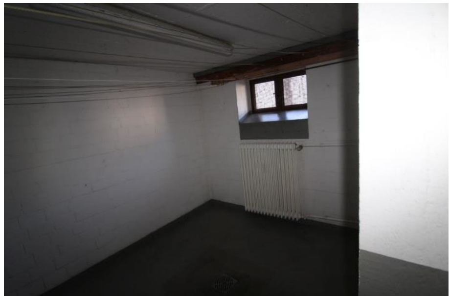
Sicht in den Kellerraum / KG.
