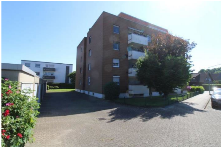
Sicht von der Meraner Straße aus auf die West- und Nordfassade des zum Teil zu bewertenden Objekts.
