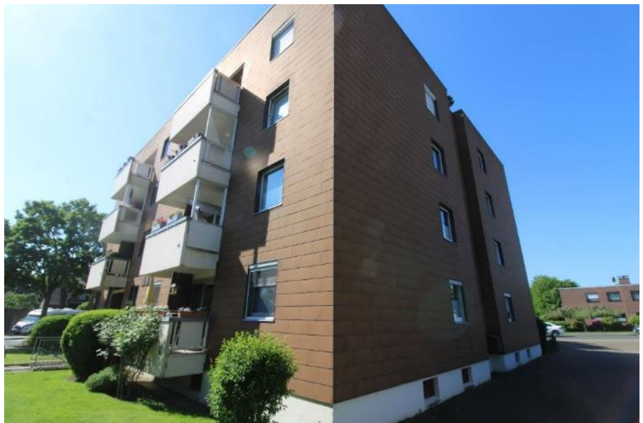
Sicht von der Garagenanlage aus auf die Ostfassade des zum Teil zu bewertenden Objekts.
