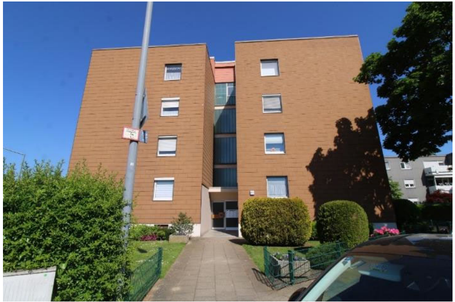
Sicht von der Mühlenstraße aus auf die Südfassade des zum Teil zu bewertenden Objekts.
