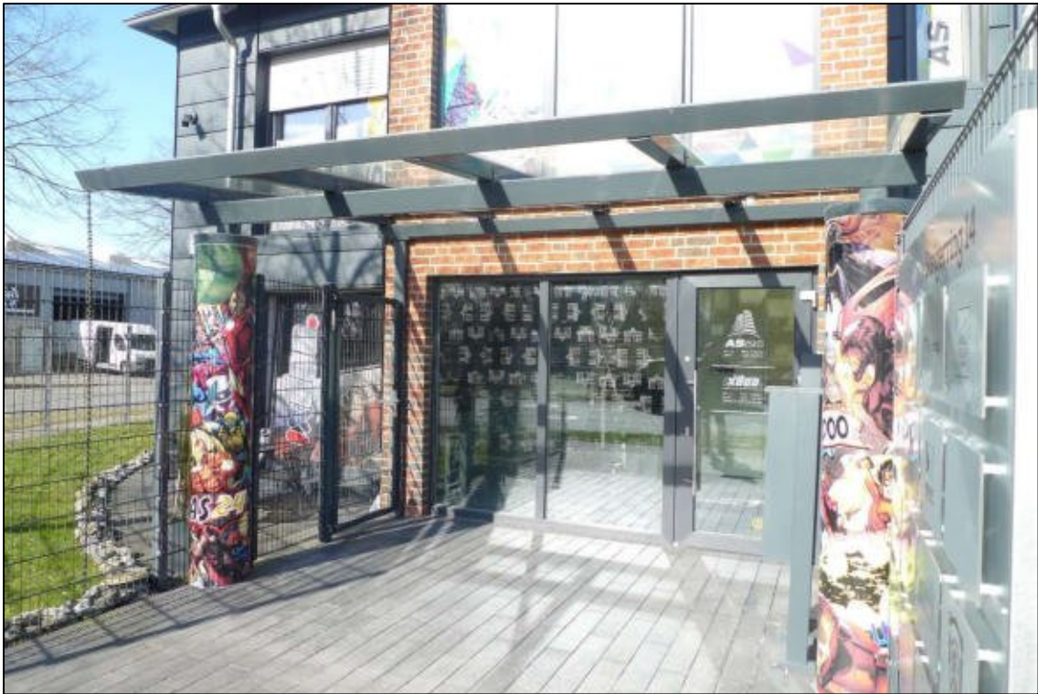
Abbildung 40 Hauseingangsbereich vom Verwaltungsgebäude auf dem zu bewertenden Grundstück fotografiert am 07.03.2025
