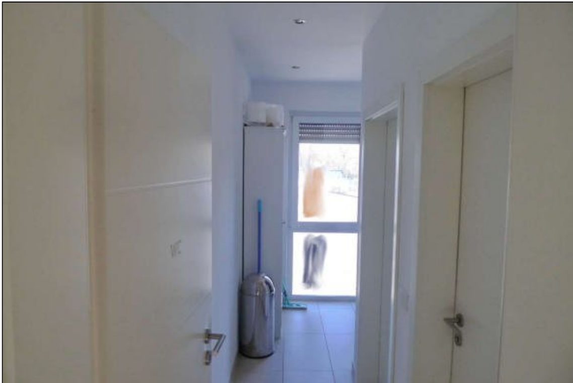
Abbildung 21 Vorraum zu den WCs im 1. Obergeschoss vom Verwaltungsgebäude auf dem zu bewertenden Grundstück fotografiert am 07.03.2025
