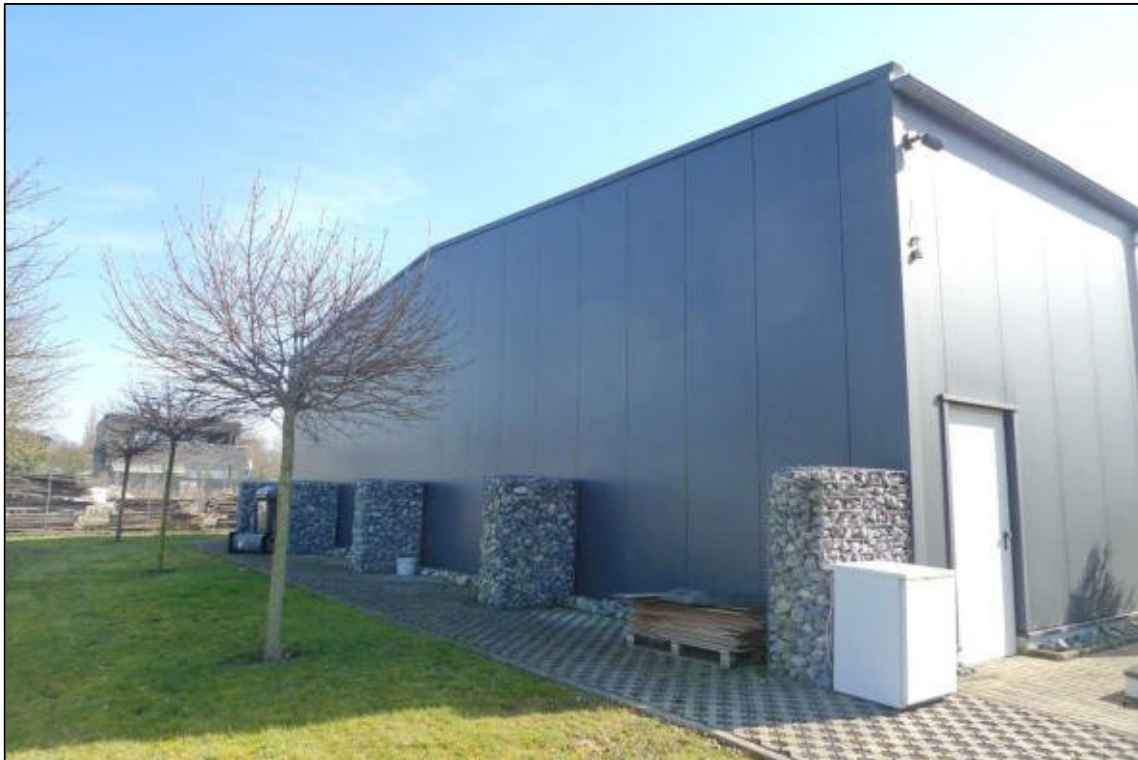
Abbildung 31 Rück- und Seitenansicht der Lagerhalle auf dem zu bewertenden Grundstück fotografiert am 07.03.2025
