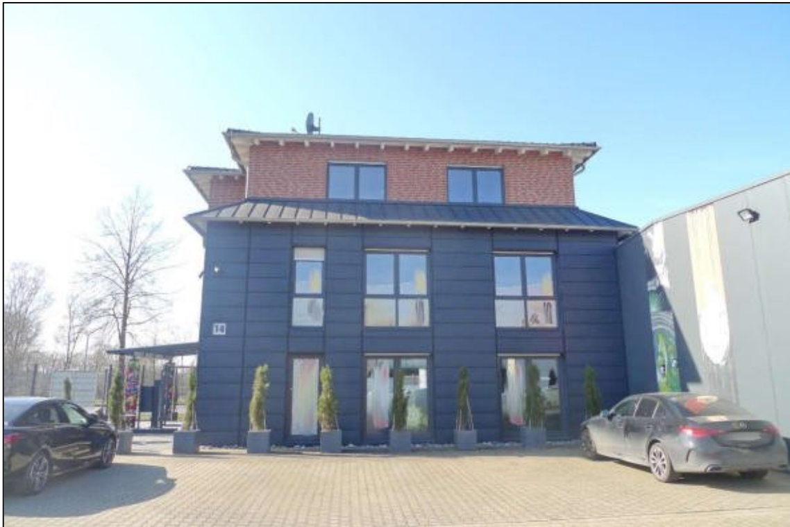
Abbildung 12 Seitenansicht vom Verwaltungsgebäude auf dem zu bewertenden Grundstück fotografiert am 07.03.2025
