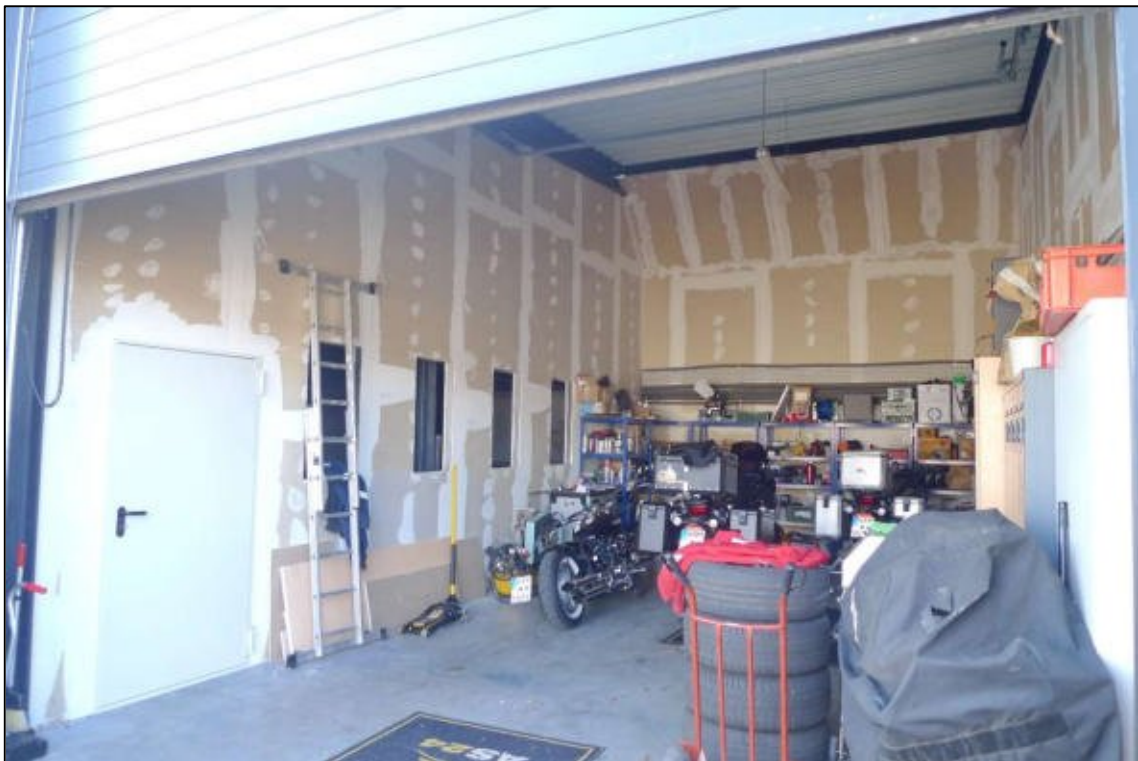
Abbildung 34 Innenansicht der Lagerhalle auf dem zu bewertenden Grundstück fotografiert am 07.03.2025
