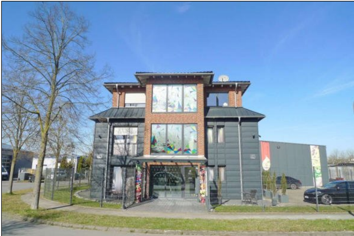
Abbildung 10 Straßenansicht vom Verwaltungsgebäude auf dem zu bewertenden Grundstück fotografiert am 07.03.2025
