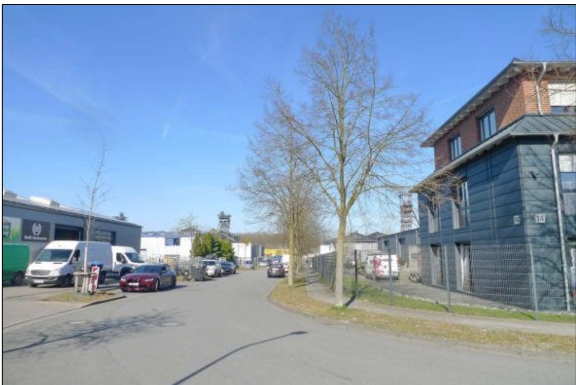
Abbildung 4 Umgebungsbebauung des zu bewertenden Grundstücks fotografiert am 07.03.2025
