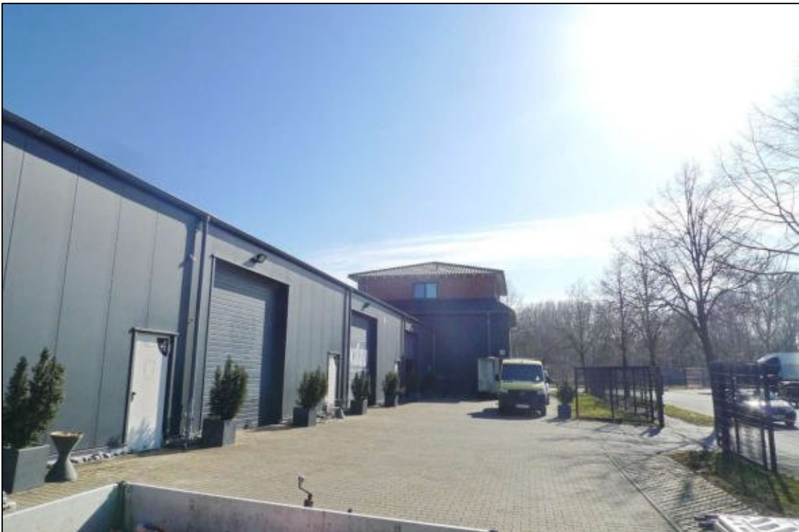
Abbildung 41 Hoffläche vor der Lagerhalle fotografiert am 07.03.2025
