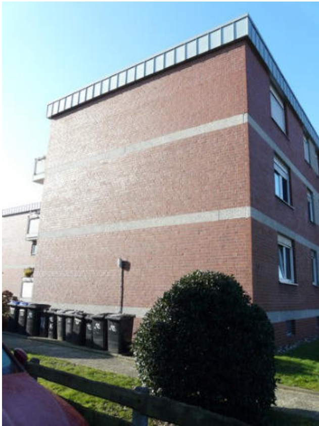
Ansicht von Nordosten (Alsenstr. 13)
