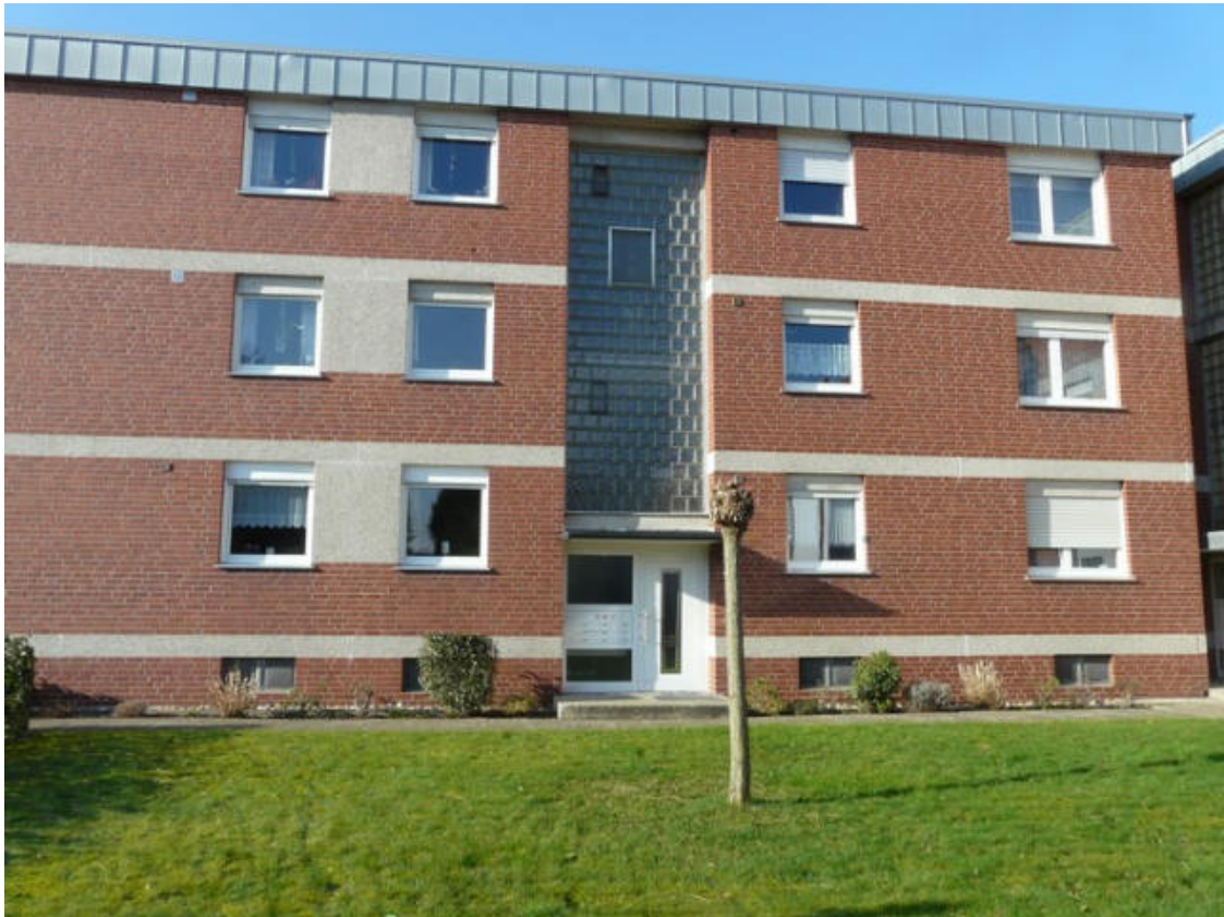
Ansicht von Osten (Wörthstr. 16)
