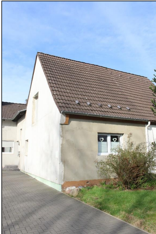
Foto Nr. 1: Straßen- und Seitenfassade
