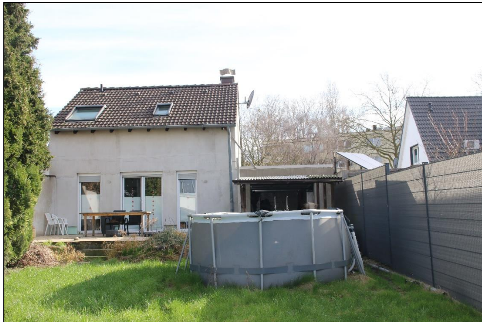
Foto Nr. 7: Gartenfassade / Gartenanlage
