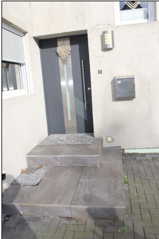
Foto Nr. 3: Hauseingangsbereich
