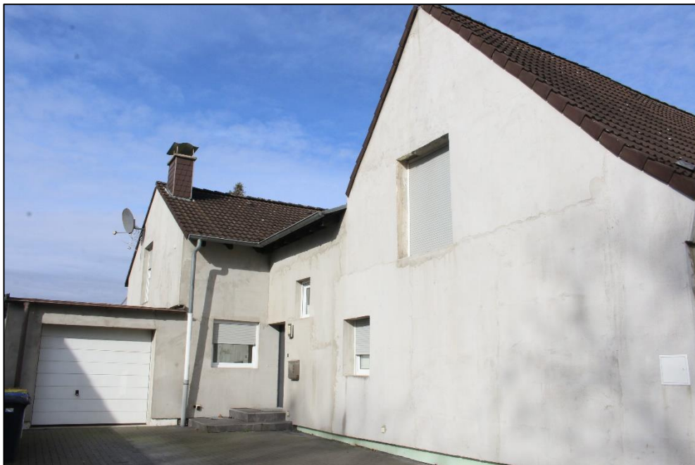
Foto Nr. 2: Giebelfassade und Garage
