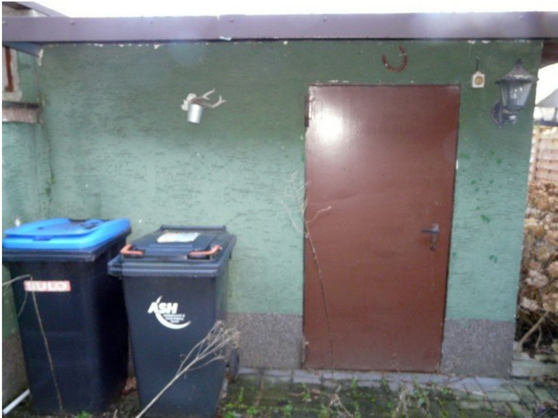
Ansicht von Südwesten (Nebengebäude)
