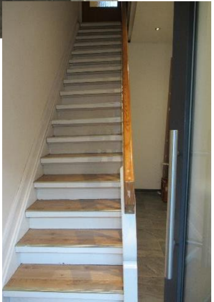
Treppe zur Dachgeschoss- wohnung
