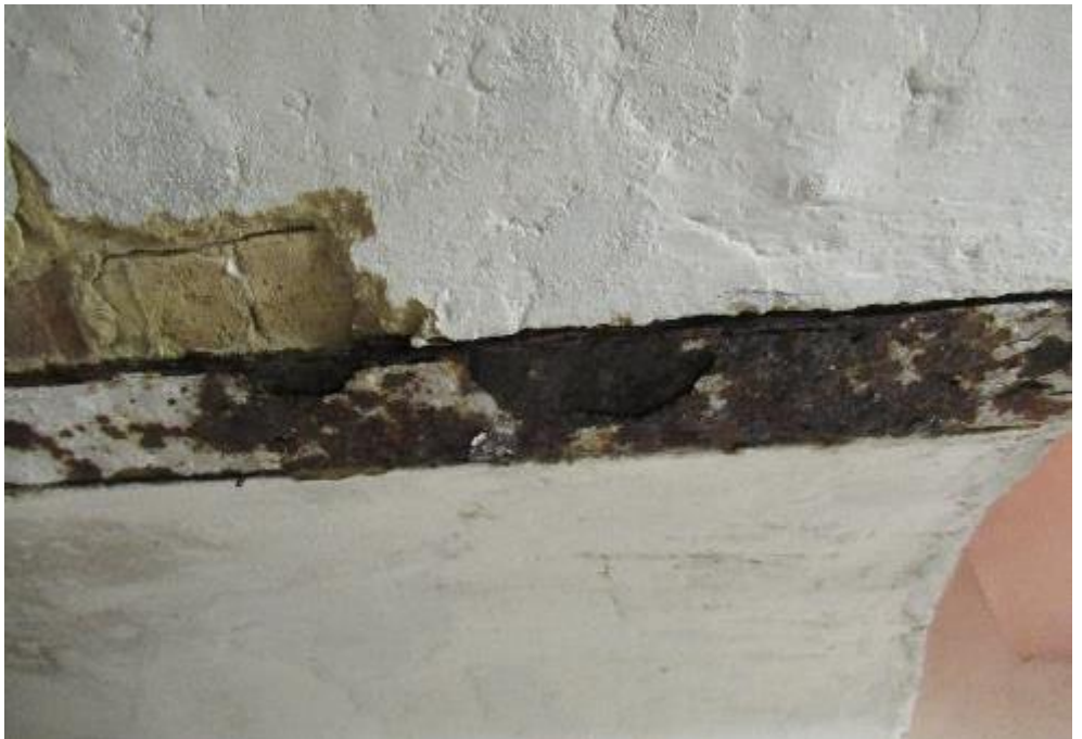
Korrodierte Eisenkappe
