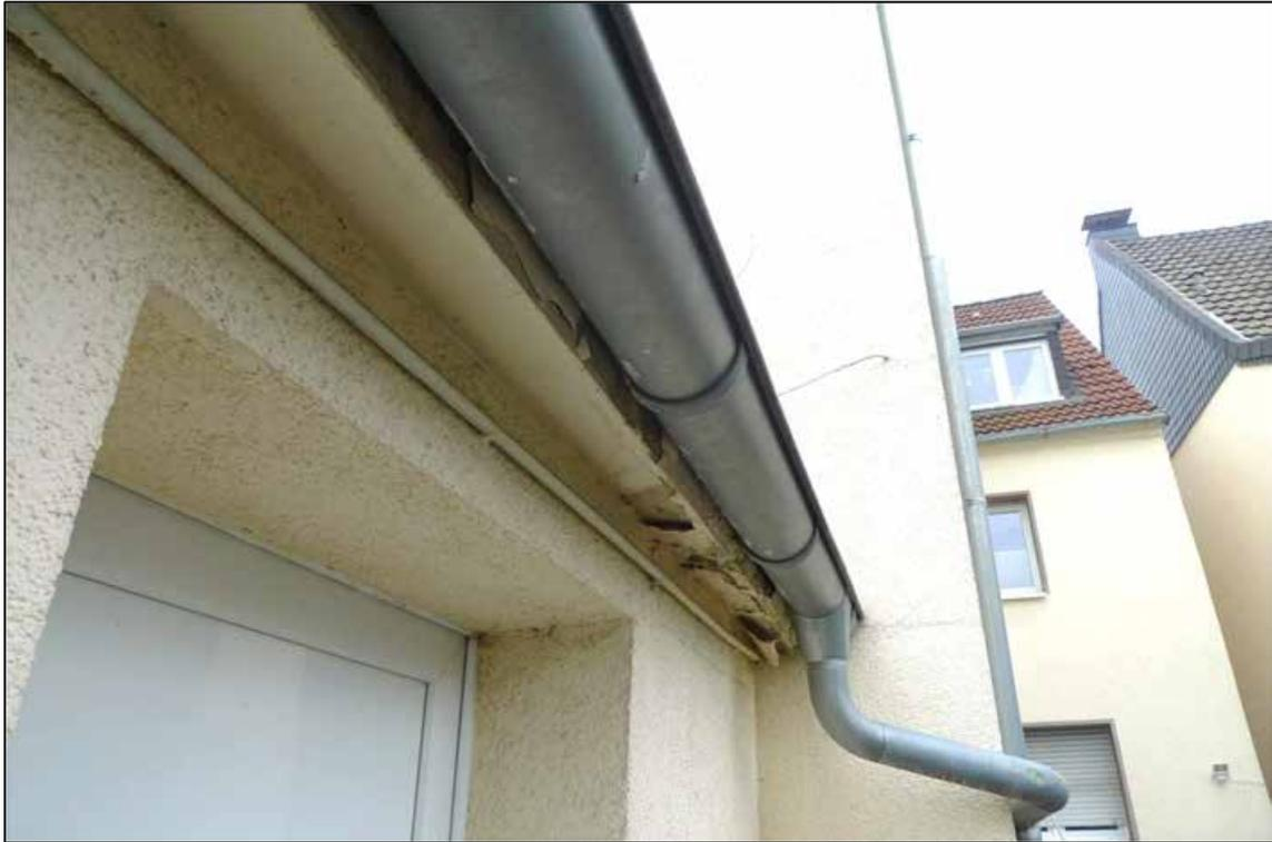
Abbildung 28 Feuchtigkeit im Dachbereich und Putzabplatzung am Lagerraum mit Garage auf dem zu bewertenden Grundstück fotografiert am 22.03.2024
