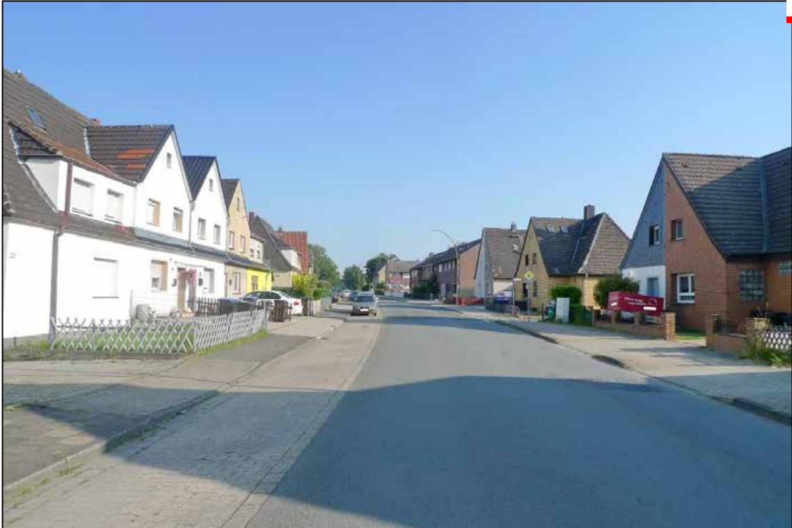
Abbildung 3 Umgebungsbebauung des zu bewertenden Grundstücks fotografiert am 13.08.2024
