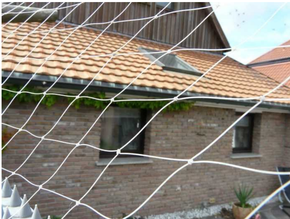
Teilansicht von Nordosten (Wohnhausanbau)
