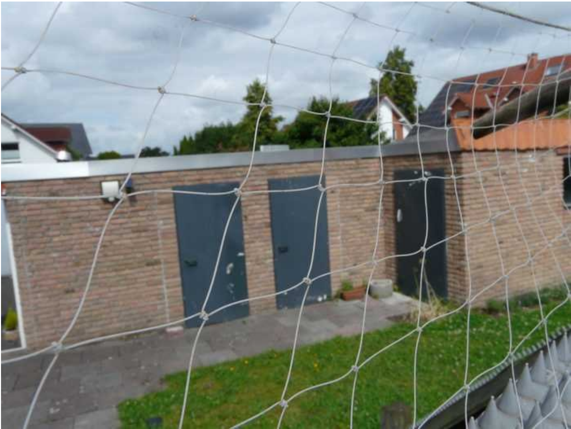
Ansicht von Osten (Nebengebäude Garten)
