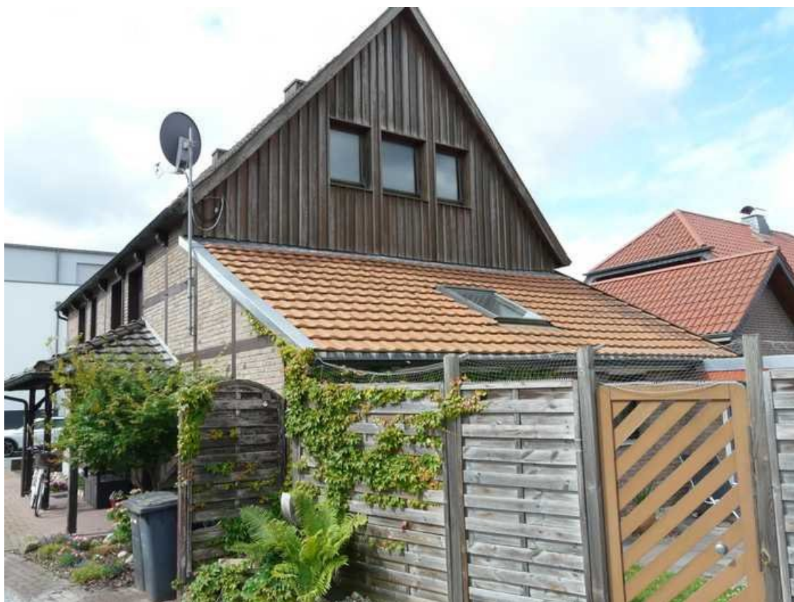
Ansicht von Nordosten (Wohnhaus mit Anbau)
