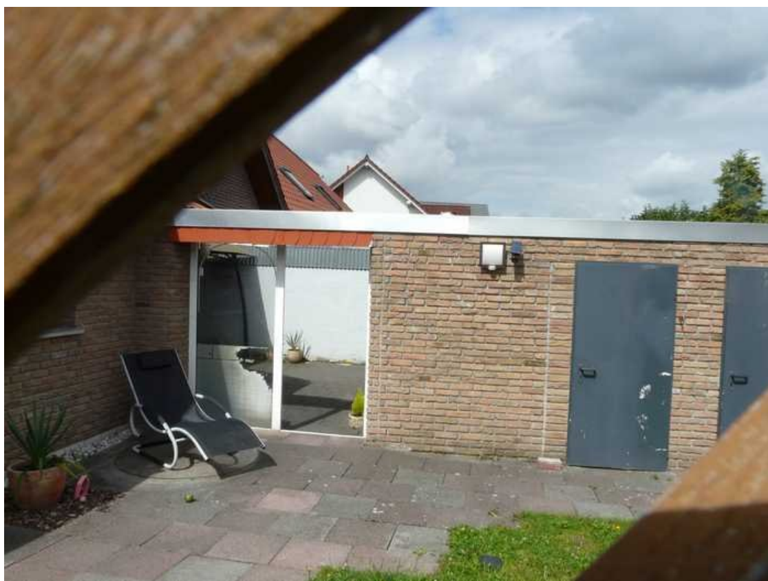
Blick in Richtung Westen (Außenanlagen Whg. 2)
