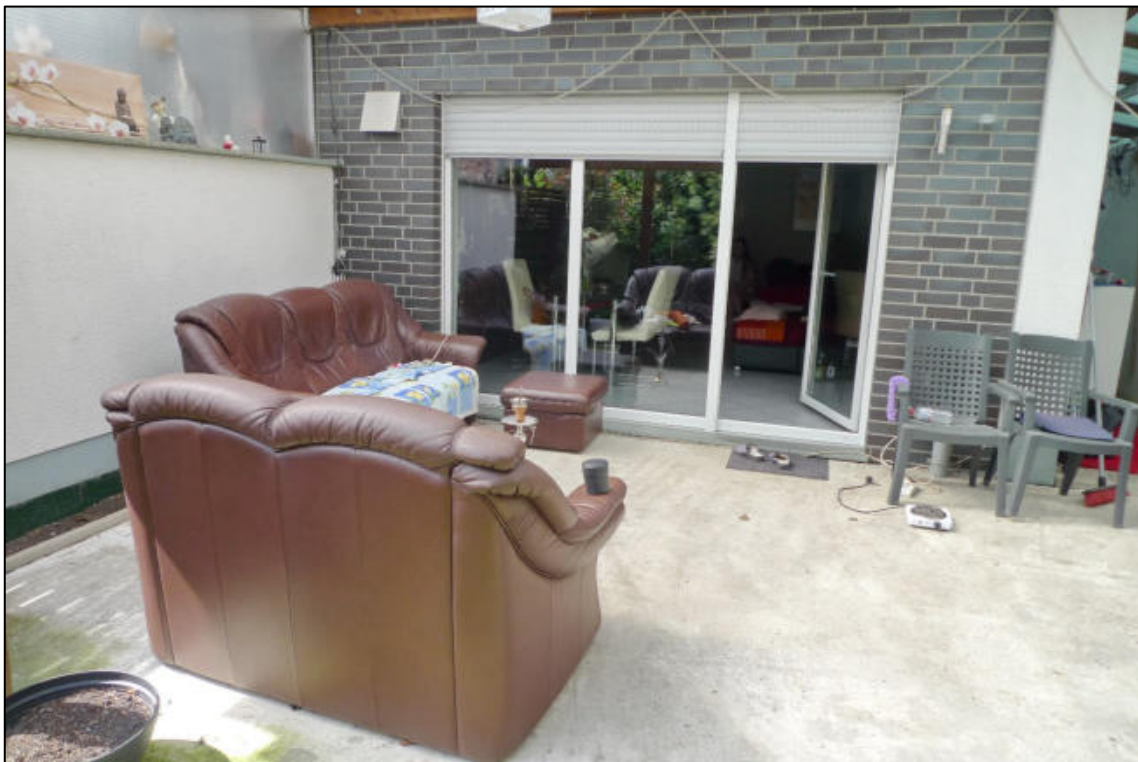
Abbildung 24 fehlender Oberbodenbelag auf der Terrasse der Einfamilien-doppelhaushälfte auf dem zu bewertenden Grundstück fotografiert am 04.05.2023
