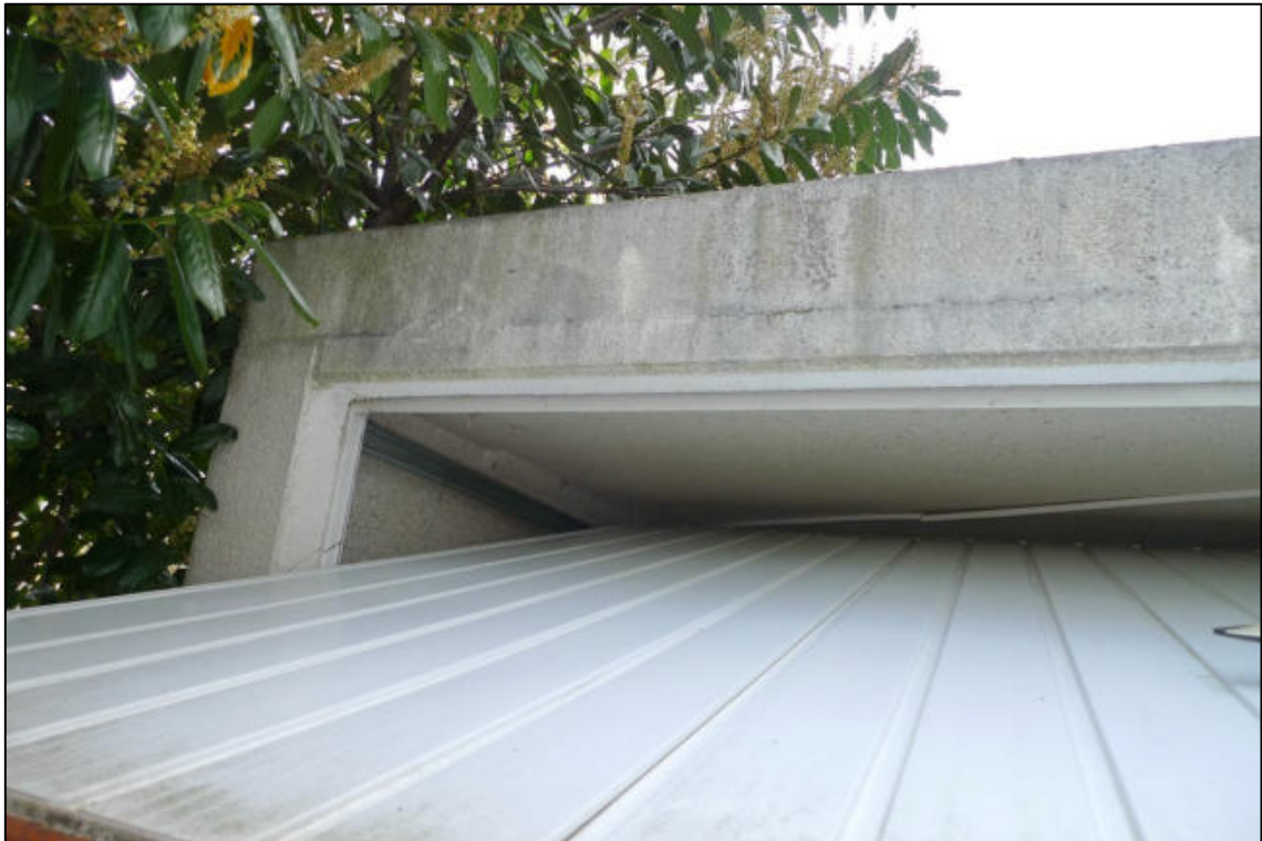
Abbildung 32 Rissbildung am Sturz über dem Garagentor der Garage auf dem zu bewertenden Grundstück, fotografiert am 04.05.2023
