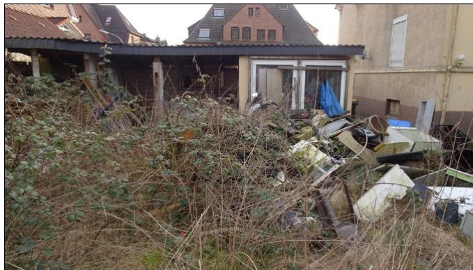
5) Rückansicht Garage/ Nebengebäude, vermüllter Garten
