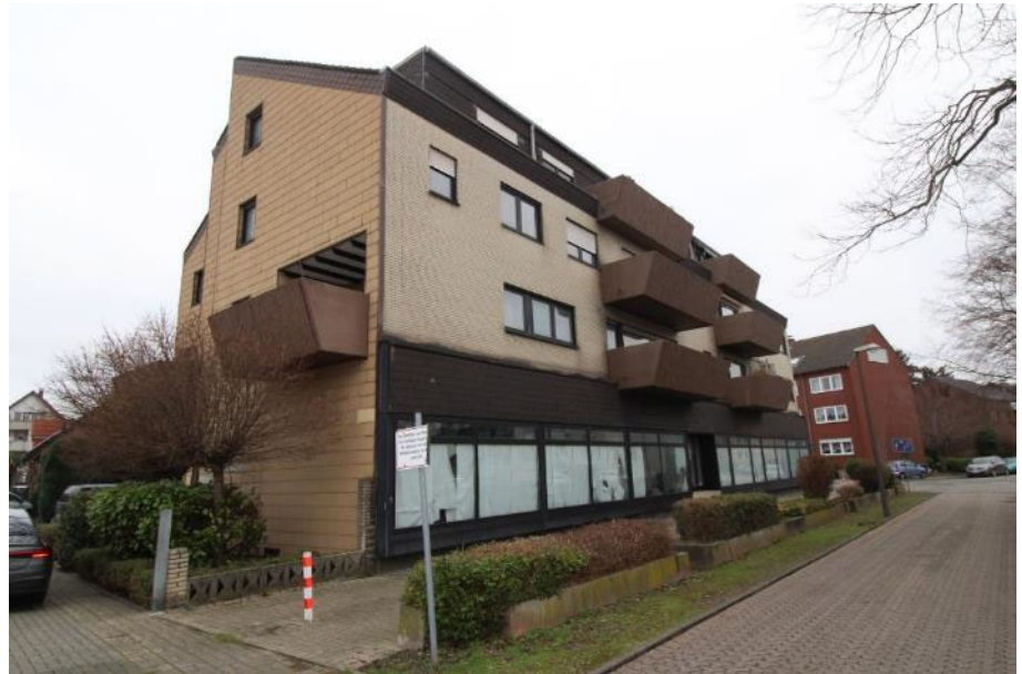
Sicht von der Küferstraße aus auf die Vorder- und linke Giebelansicht des zum Teil zu bewertenden Objekts
