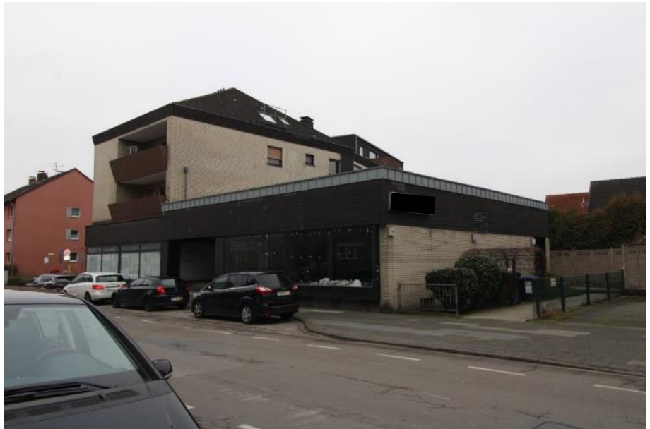
Sicht von der Sachsenstraße aus auf die Rück- und Vorderansicht des zum Teil zu bewertenden Objekts
