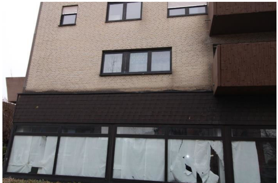
Sicht auf die Schaufensteranlage und zu erneuernde Abdeckung an der Küferstraße
