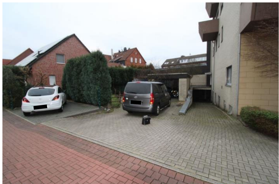
Sicht auf den Außen- bereich der baulich nicht errichteten Gara- gen
