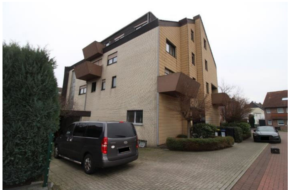
Sicht auf die Rück- und linke Giebela- nsicht des zum Teil zu bewertenden Objekts
