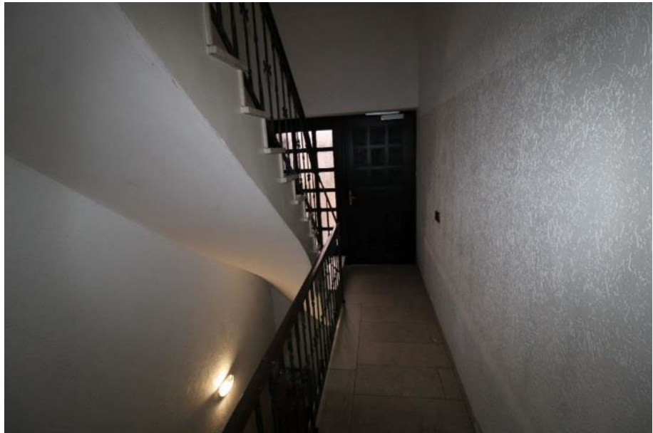
Sicht in das Treppenhaus / EG
