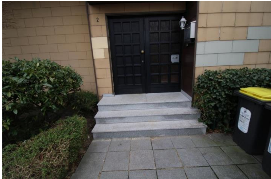
Sicht auf den Haus- eingang an der linken Giebelfassade Küfer- straße 2
