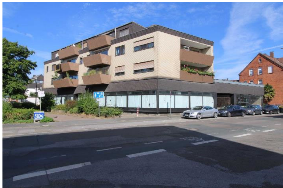
Sicht von der Sachsenstraße aus auf die Vorderansicht des, zum Teil, zu bewertenden Objekts
