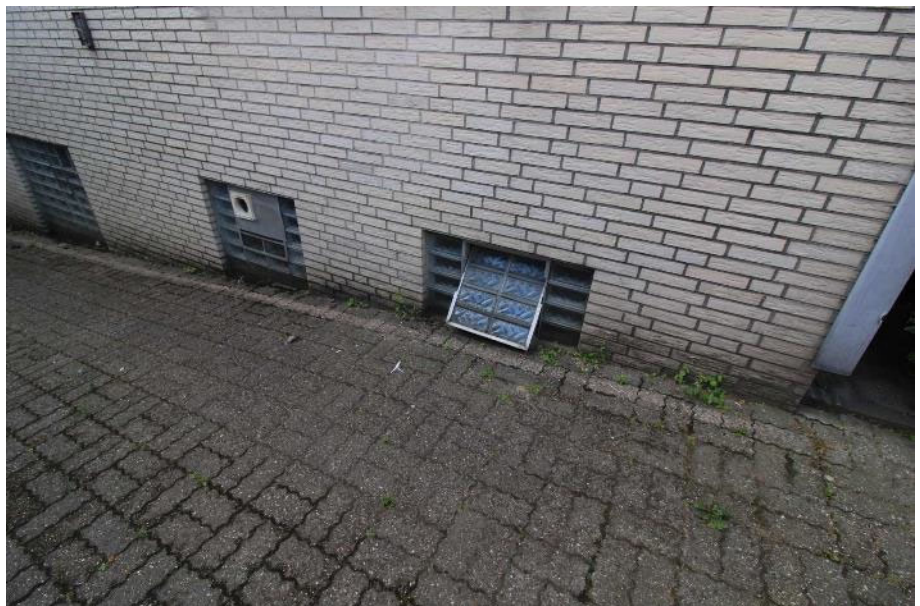
Sicht auf die Glasbausteinfenster der zu bewertenden Einheit Nr. 16 an der Rückseite (Küferstraße 2)
