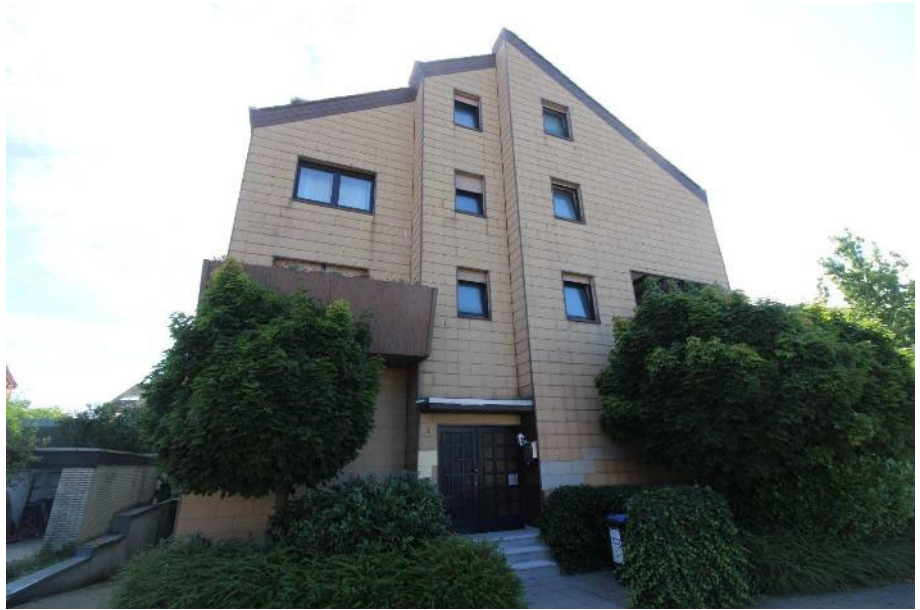
Sicht auf die linke Giebelansicht (Küferstraße 2) des, zum Teil, zu bewertenden Objekts
