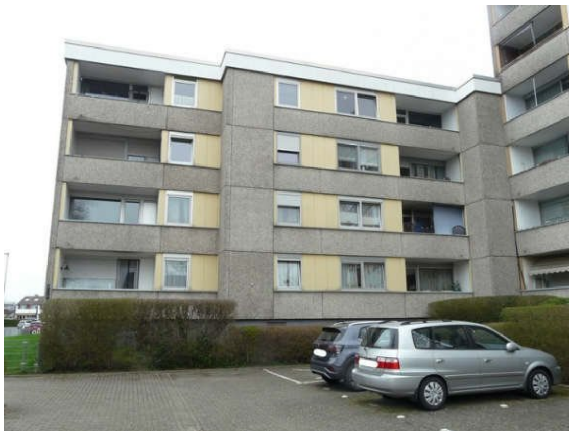
Ansicht von Süden (Haus-Nr. 49)
