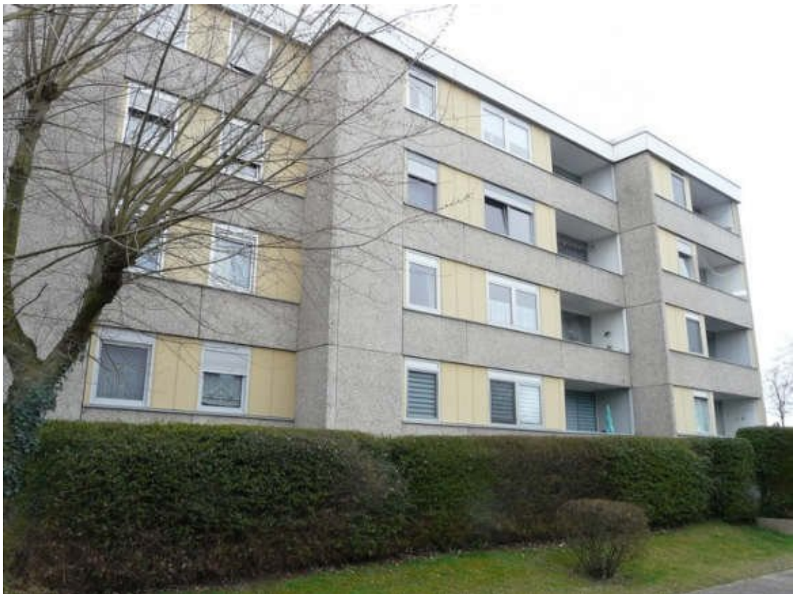
Ansicht von Südosten (Haus-Nr. 45)
