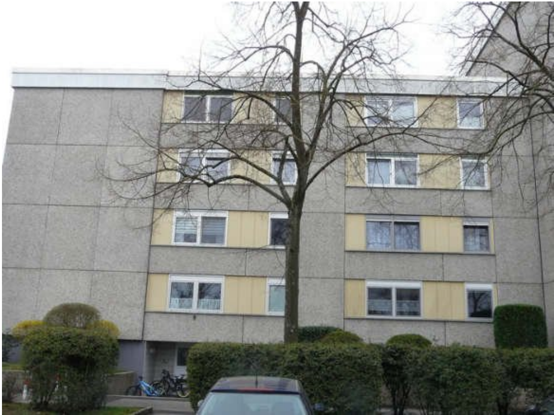
Ansicht von Norden (Haus-Nr. 45)
