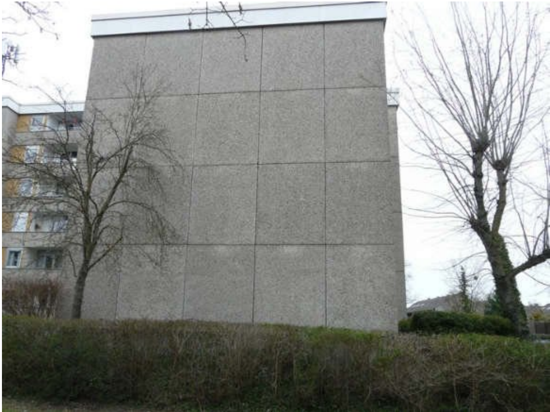
Ansicht von Süden (Haus-Nr. 45)
