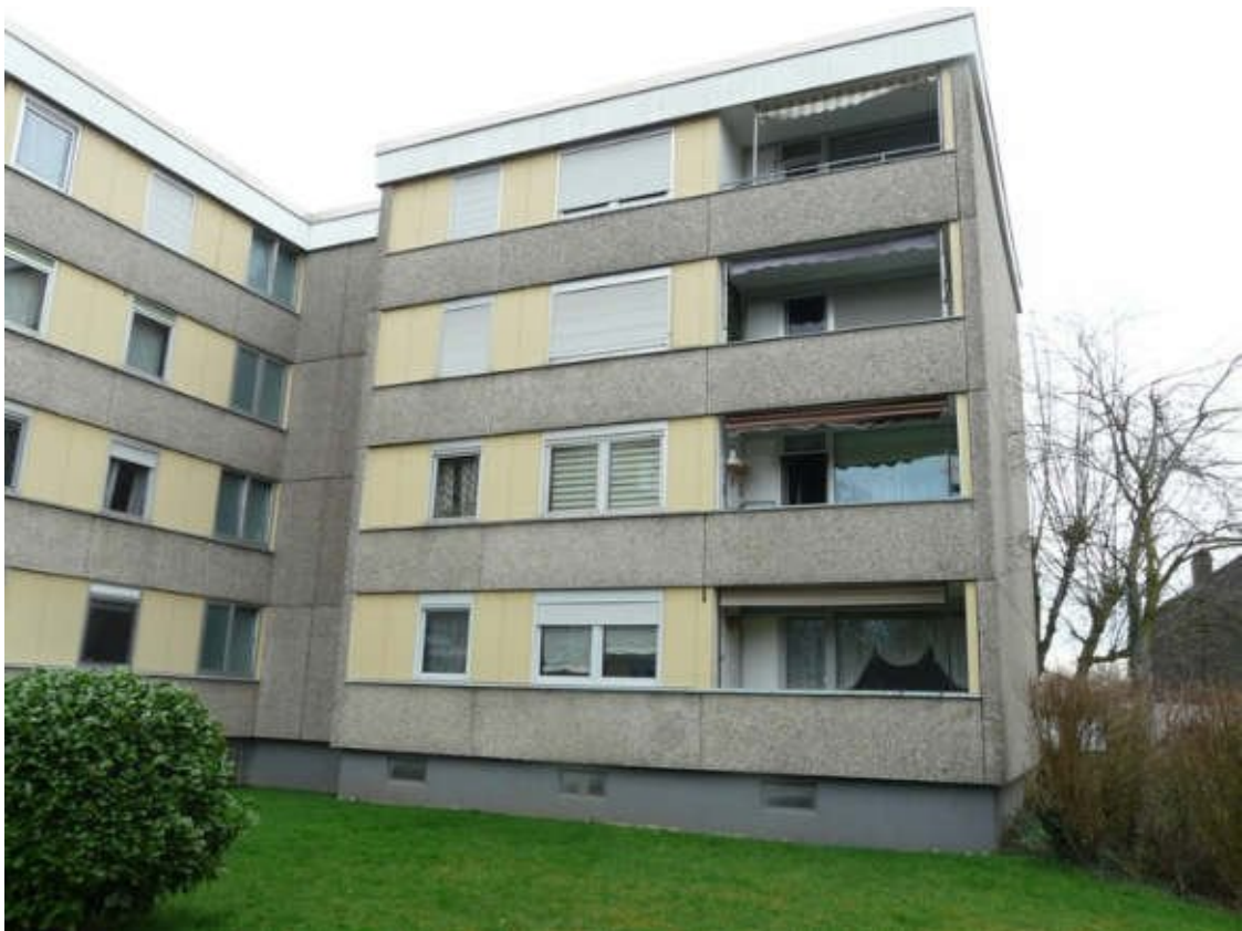
Ansicht von Westen (Haus-Nr. 45)
