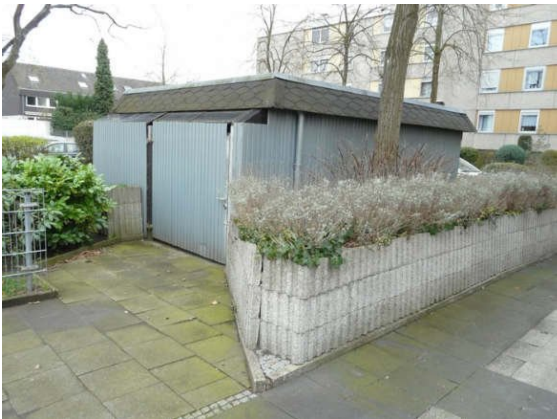
Ansicht von Nordwesten (Müllbehälterhaus)
