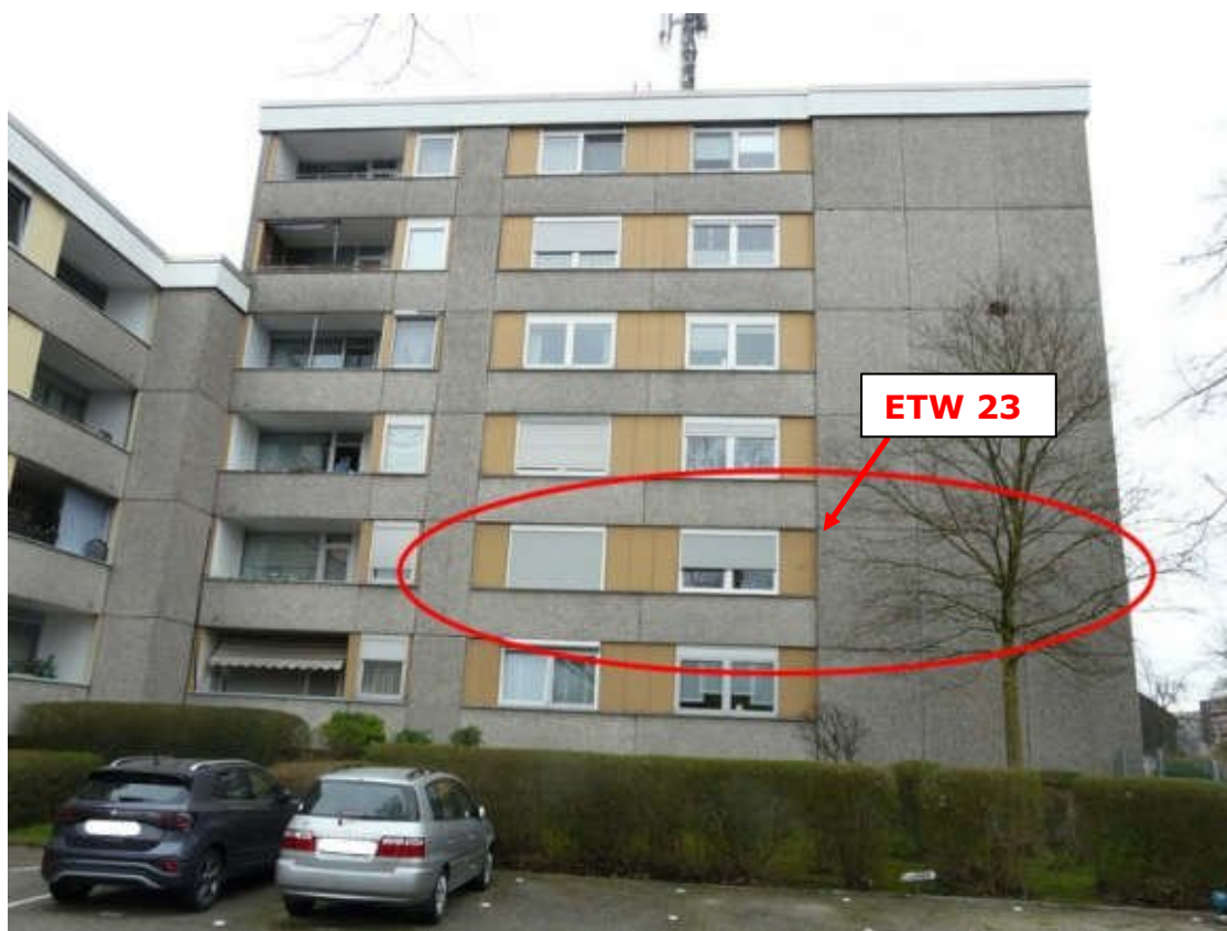
Ansicht von Westen (Haus-Nr. 47)
