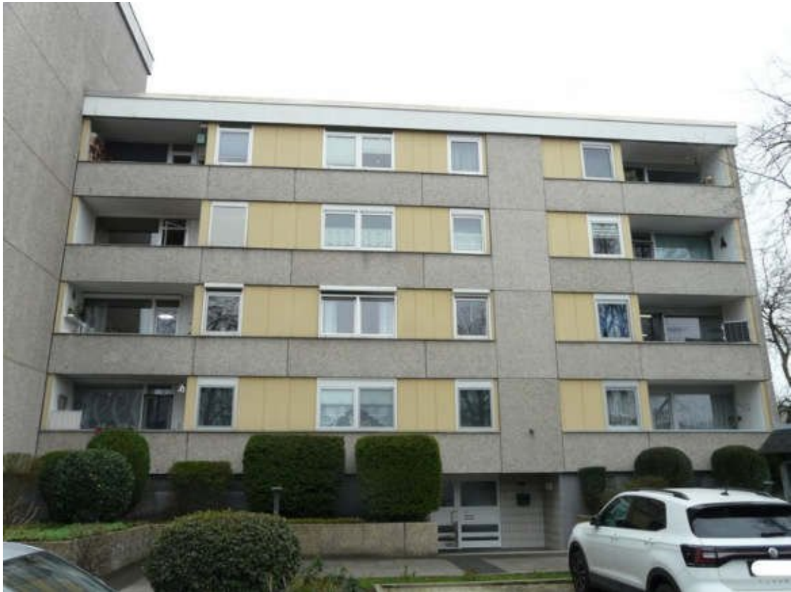
Ansicht von Osten (Haus-Nr. 49)
