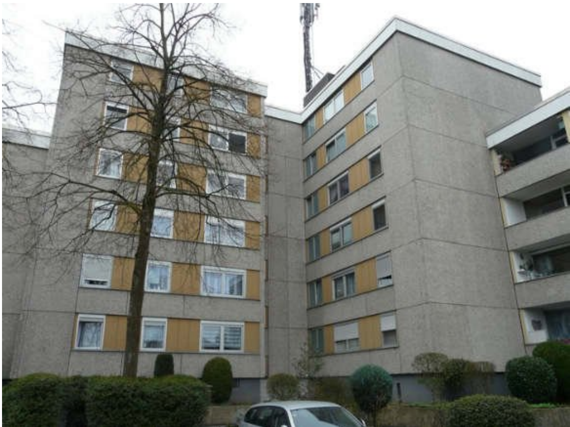
Ansicht von Norden (Haus-Nr. 47)
