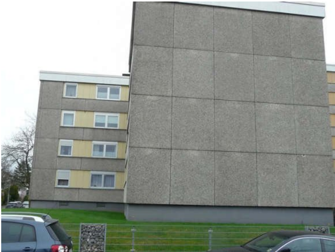
Ansicht von Westen (Haus-Nr. 49)
