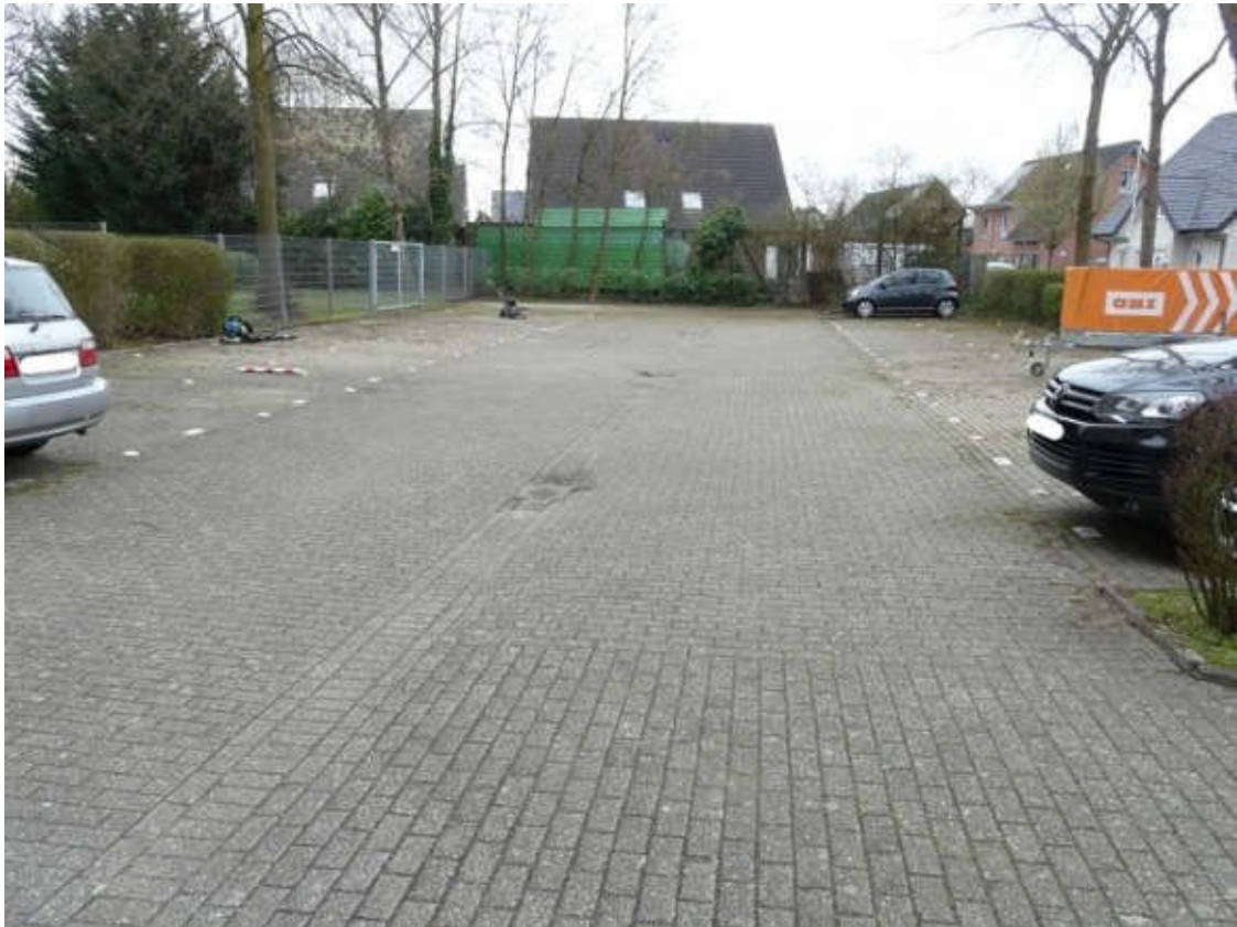
Blick in Richtung Süden (westl. Stellplatzanlage)
