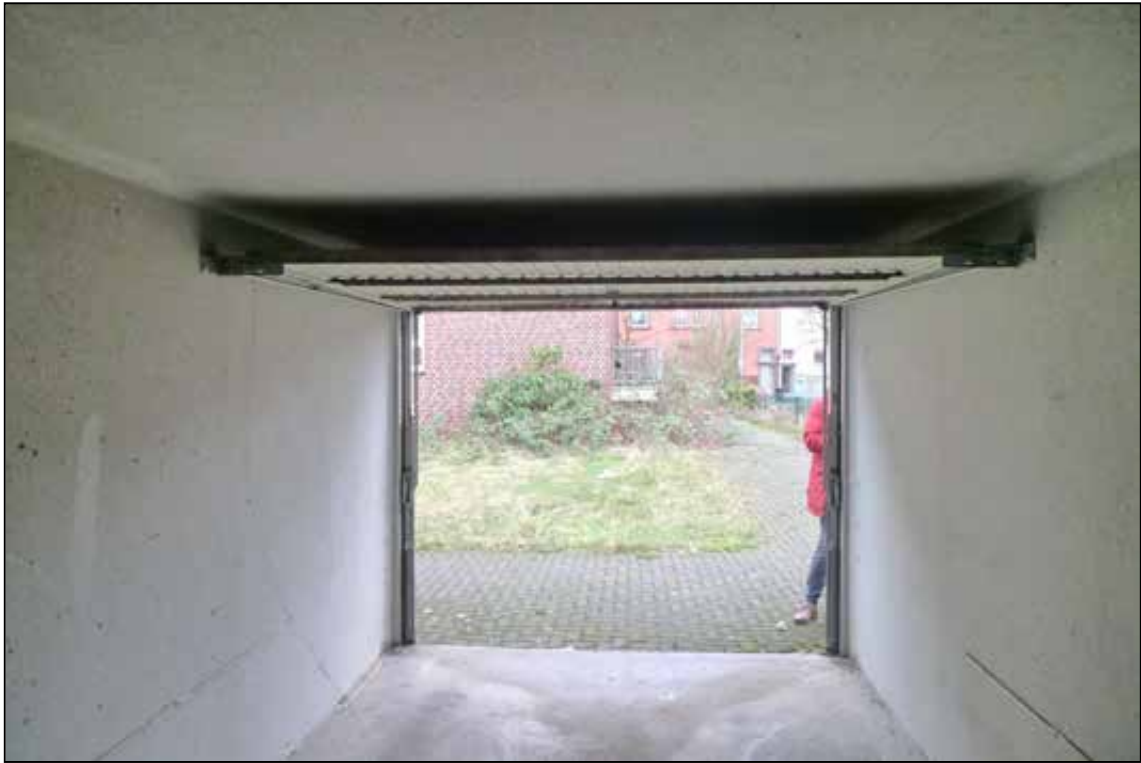
Abbildung 57 Innenansicht der Garage Nr. 11 Es handelt sich hier nicht um das Wertermittlungsobjekt, sondern um die einzige zugängliche Garage des Garagengebäudes. fotografiert am 24.01.2025
