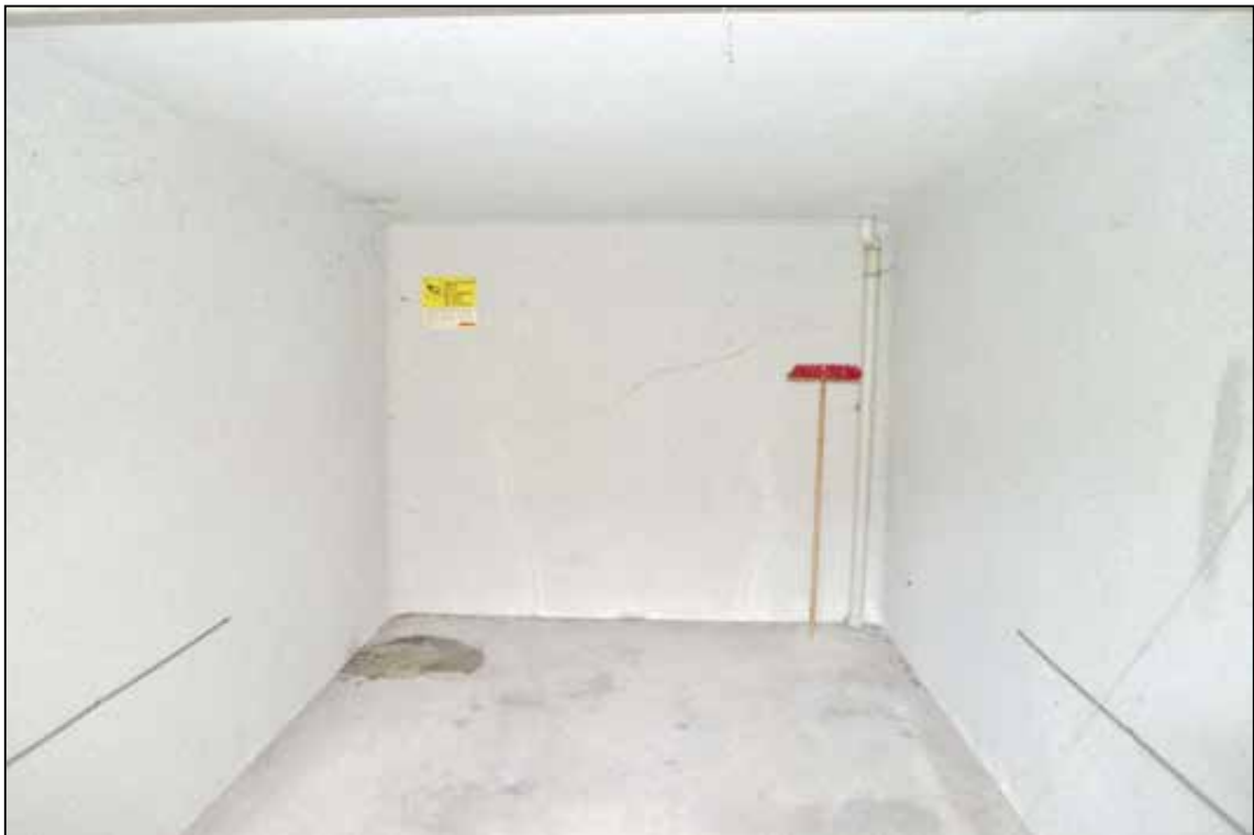
Abbildung 56 Innenansicht der Garage Nr. 11 Es handelt sich hier nicht um das Wertermittlungsobjekt, sondern um die einzige zugängliche Garage des Garagengebäudes. fotografiert am 24.01.2025
