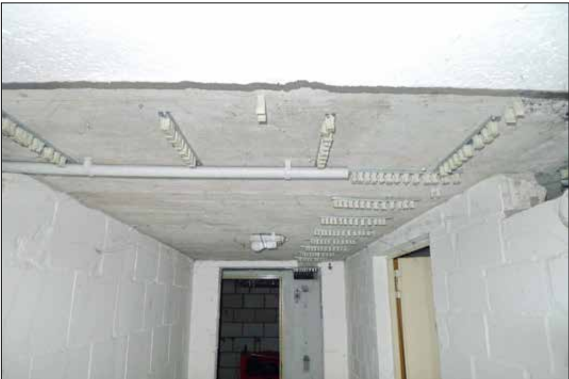
Abbildung 35 demontierte Leitungssysteme im gesamten Haus fotografiert am 24.01.2025
