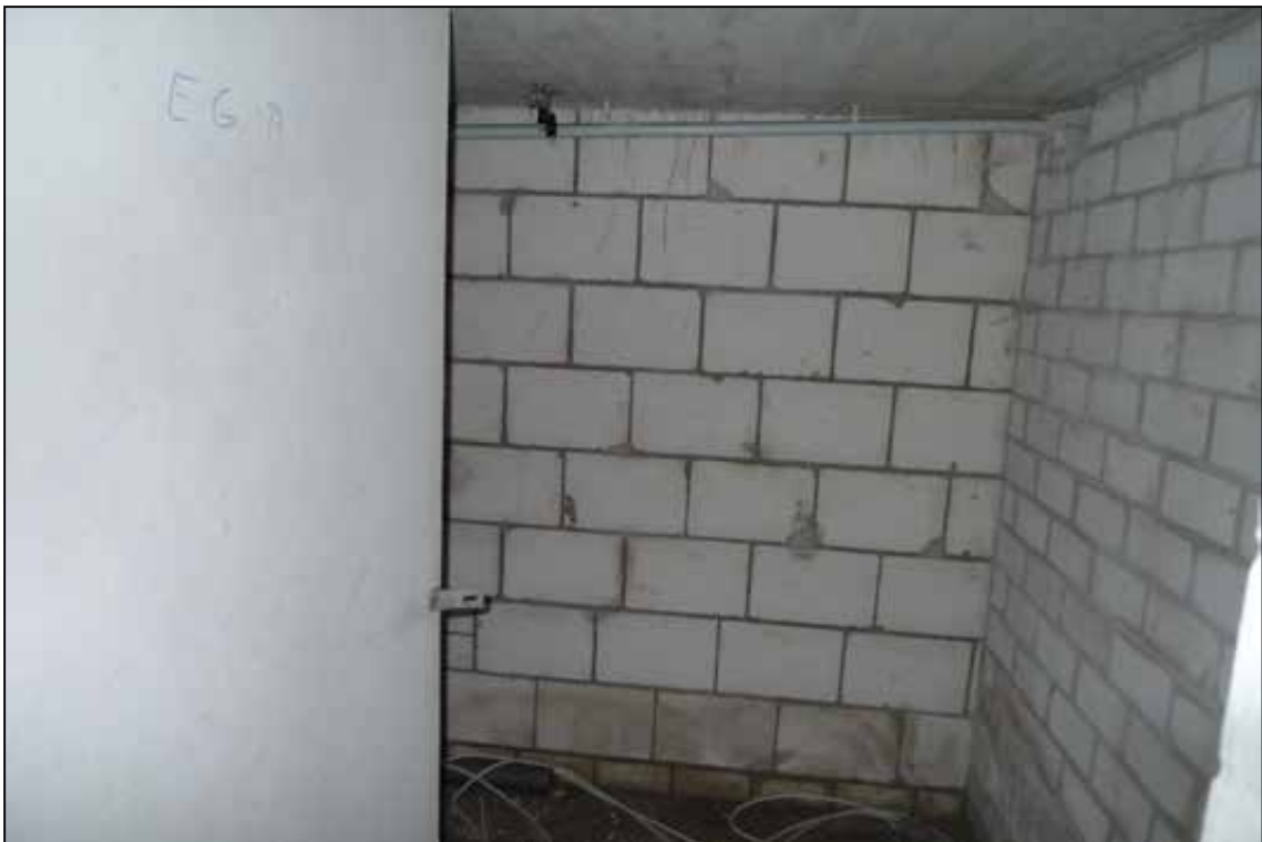
Abbildung 63 Kellerabteil des Wertermittlungsobjektes fotografiert am 24.01.2025
