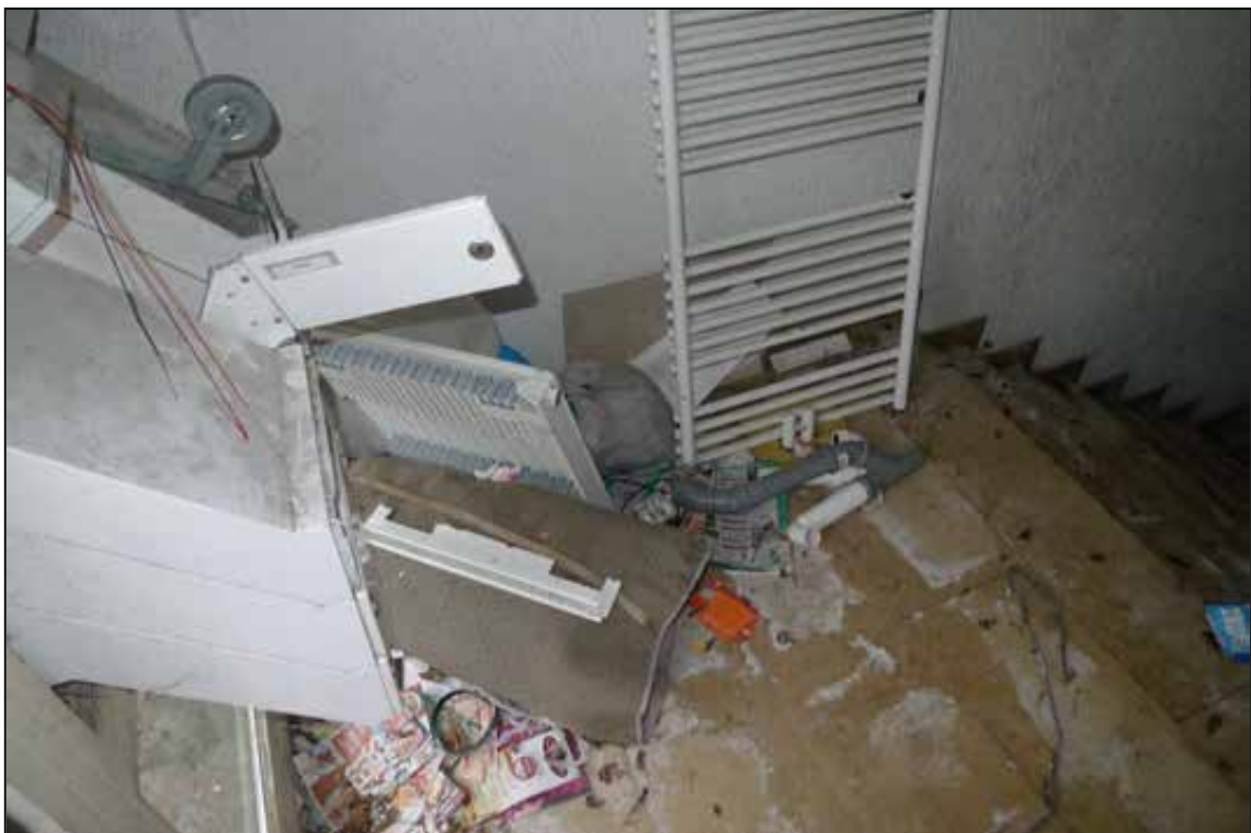
Abbildung 33 demolierte Briefkastenanlage, Feuchtigkeitserscheinungen am Fußbodenoberbelag fotografiert am 24.01.2025
