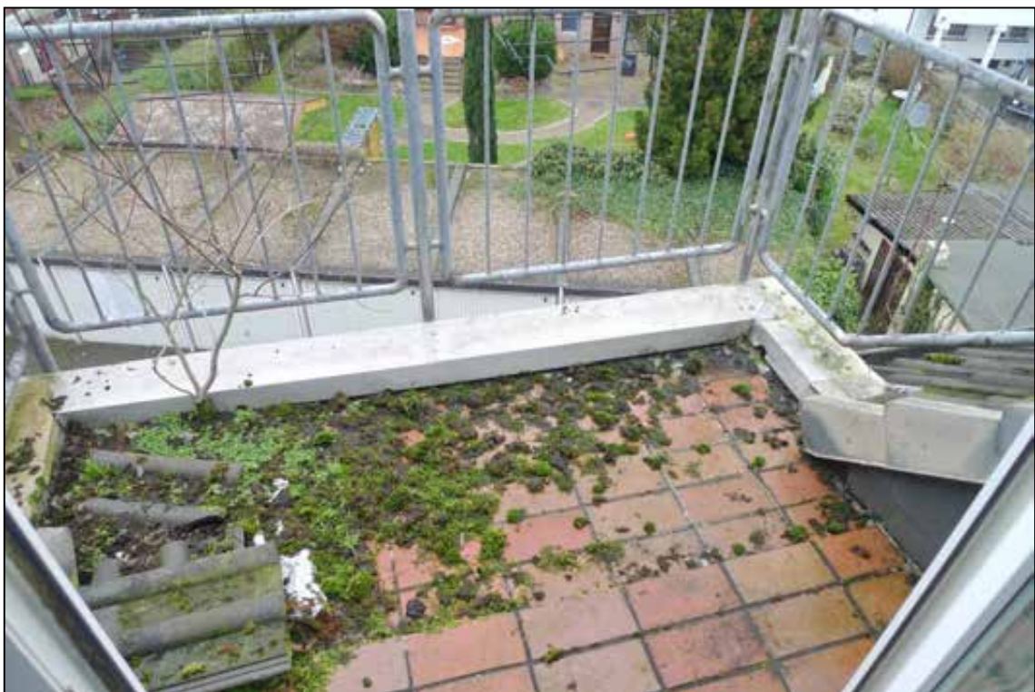
Abbildung 59 Balkon des Wertermittlungsobjektes fotografiert am 24.01.2025
