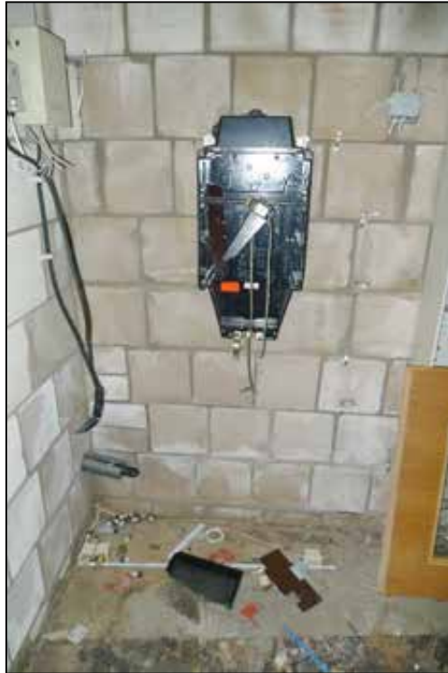
Abbildung 38 demontierte Hausanschlussleitungen fotografiert am 24.01.2025
