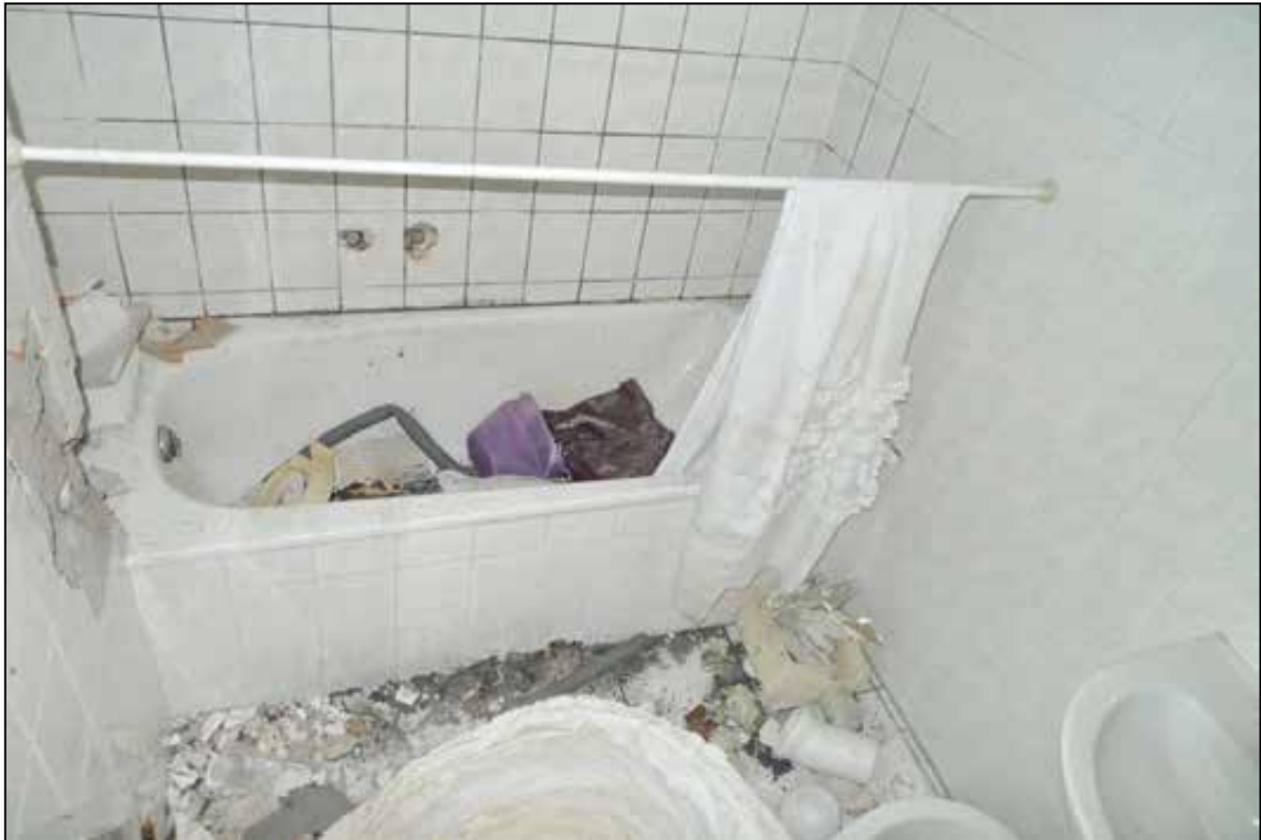
Abbildung 66 demoliertes Bad fotografiert am 24.01.2025
