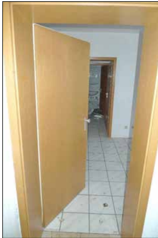
Abbildung 56 Wohnungseingangstür und Eingangsbereich des Wertermittlungsobjektes fotografiert am 24.01.2025
