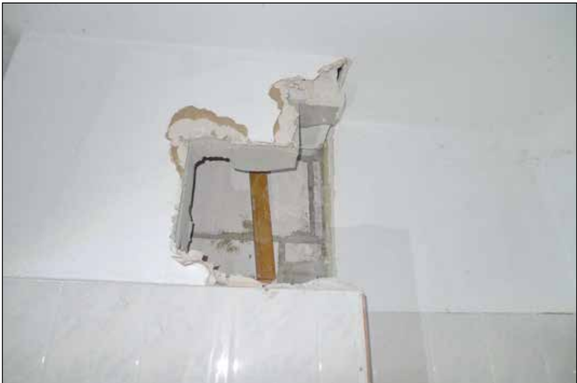
Abbildung 67 aufgerissene Wand und entfernte Leitungen im Bad fotografiert am 24.01.2025
