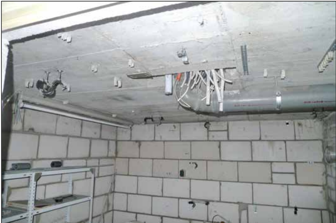
Abbildung 36 demontierte Leitungssysteme im gesamten Haus fotografiert am 24.01.2025
