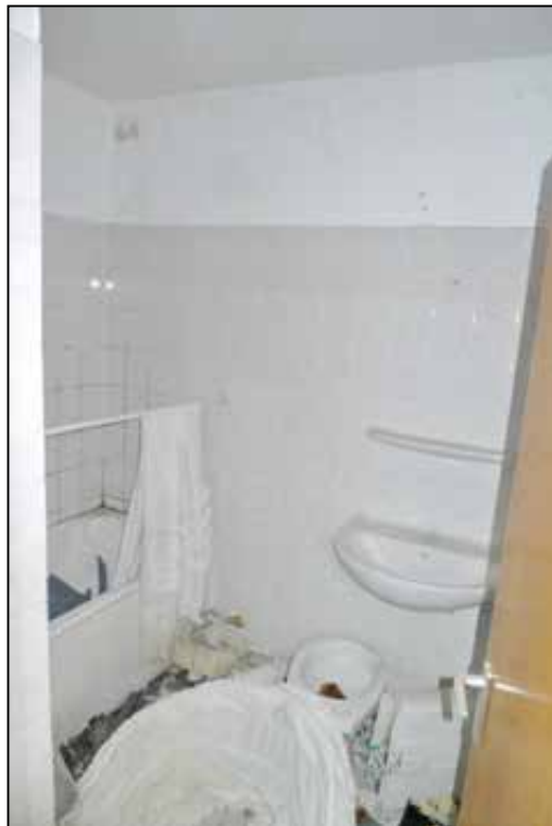
Abbildung 61 Bad des Wertermittlungsobjektes fotografiert am 24.01.2025
