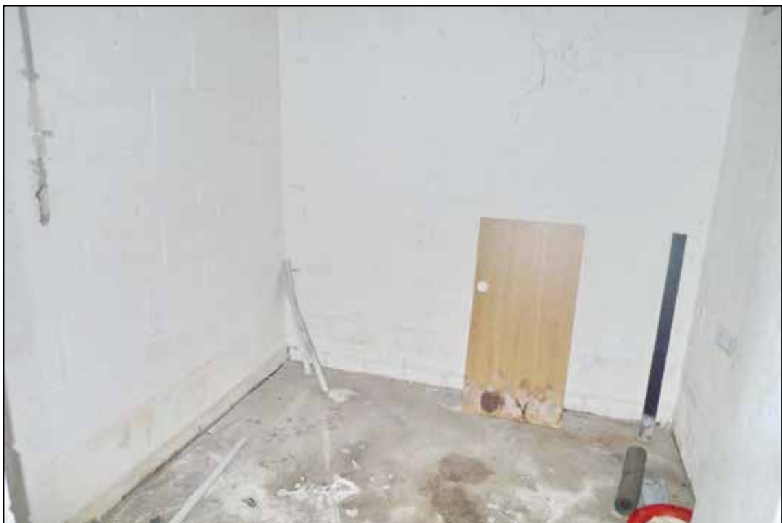
Abbildung 64 Kellerabteil des Wertermittlungsobjektes fotografiert am 24.01.2025
