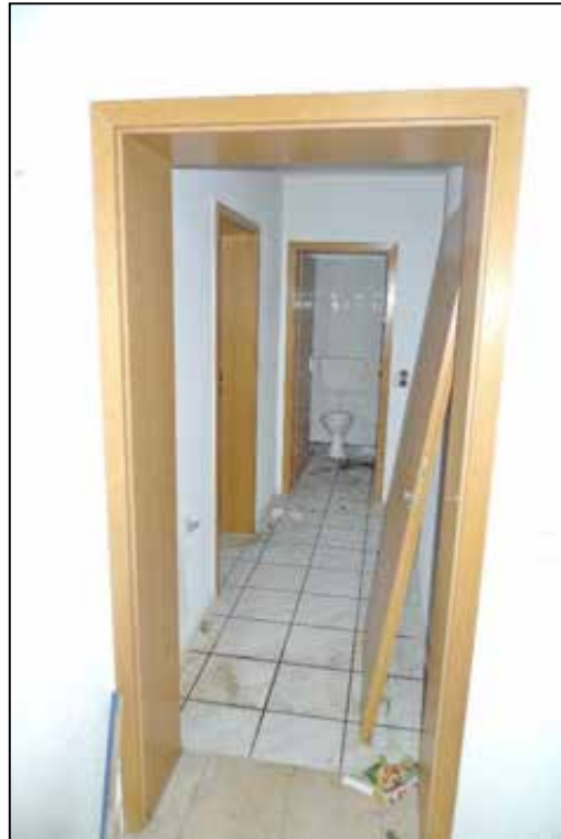
Abbildung 55 Wohnungseingangstür und Flur des Wertermittlungsobjektes fotografiert am 24.01.2025
