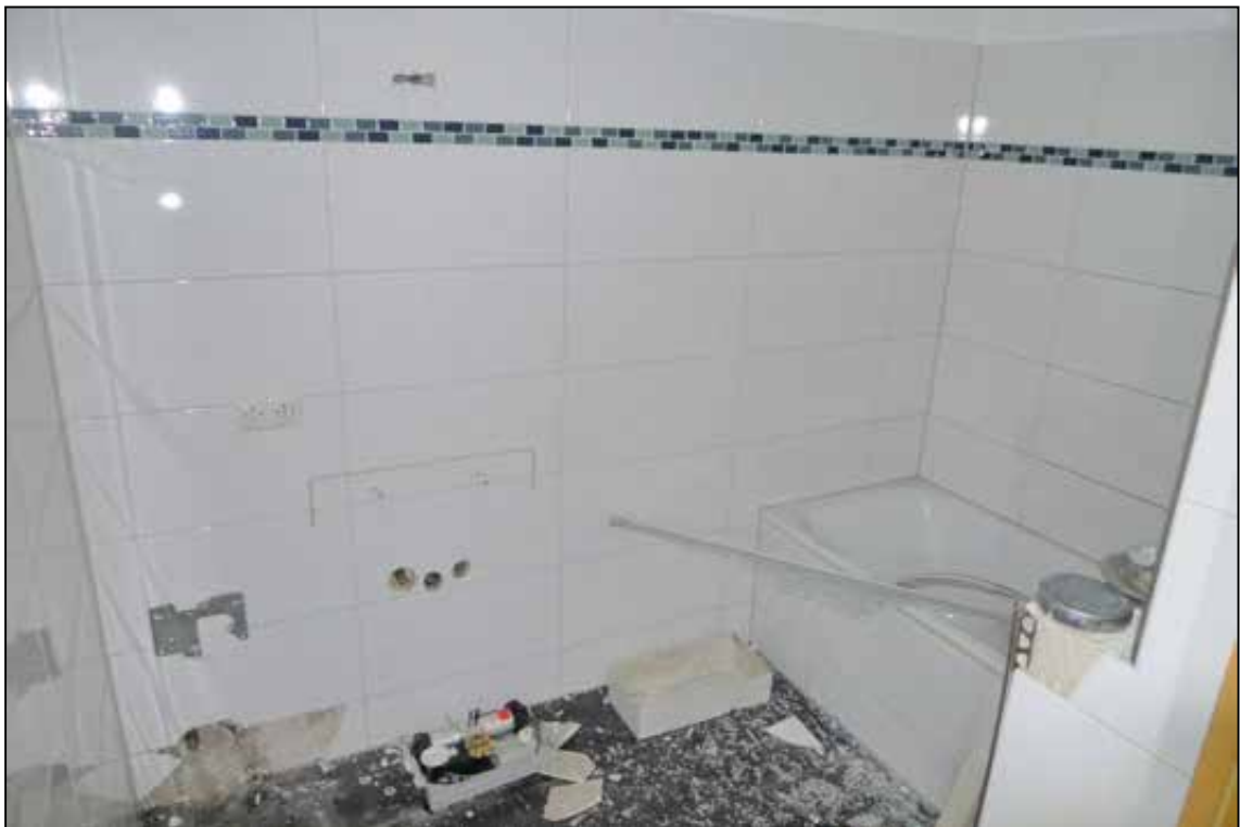
Abbildung 62 Bad des Wertermittlungsobjektes fotografiert am 24.01.2025
