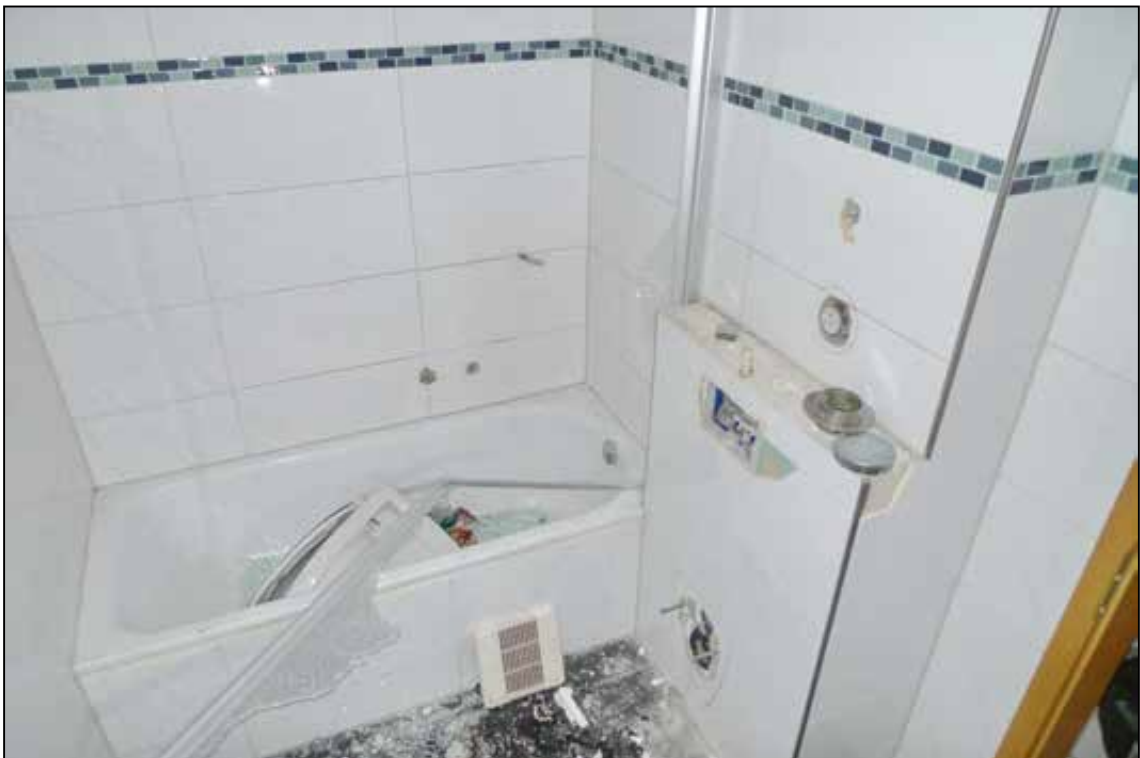
Abbildung 67 demoliertes Bad fotografiert am 24.01.2025
