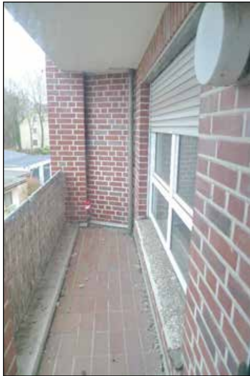
Abbildung 61 Balkon des Wertermittlungsobjektes fotografiert am 24.01.2025
