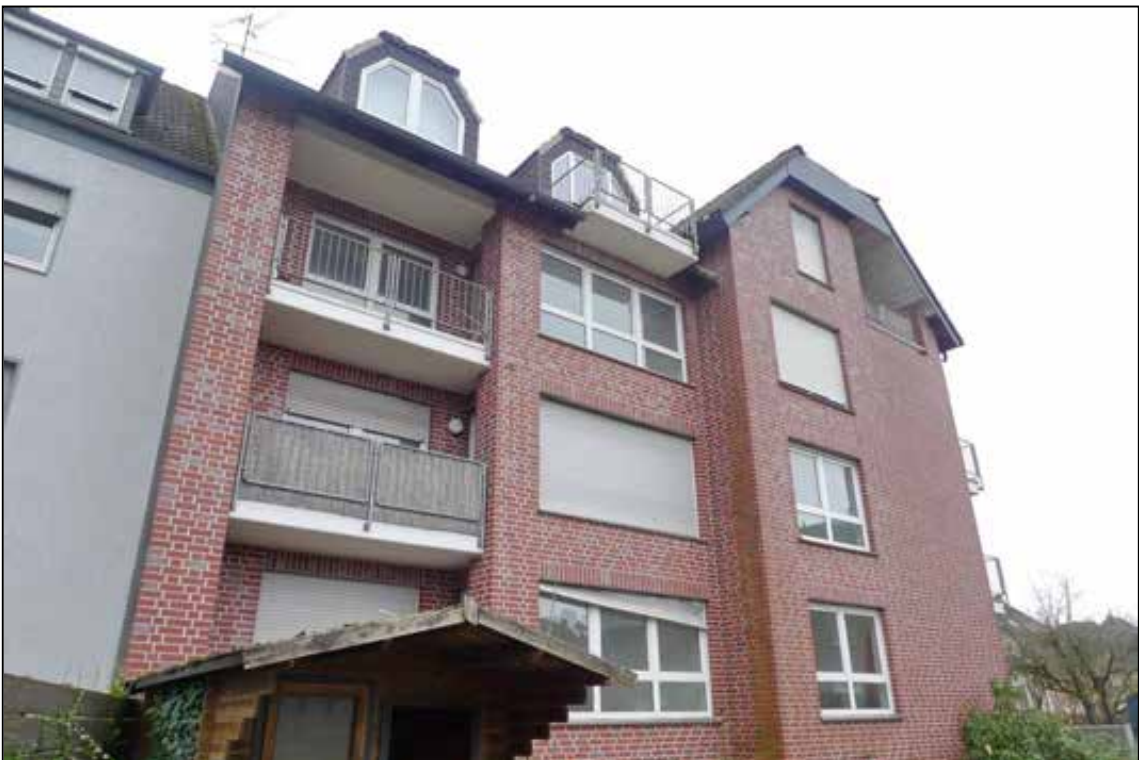
Abbildung 12 Rückansicht der baulichen Anlage Mehrfamiliendoppelhaushälfte fotografiert am 24.01.2025
