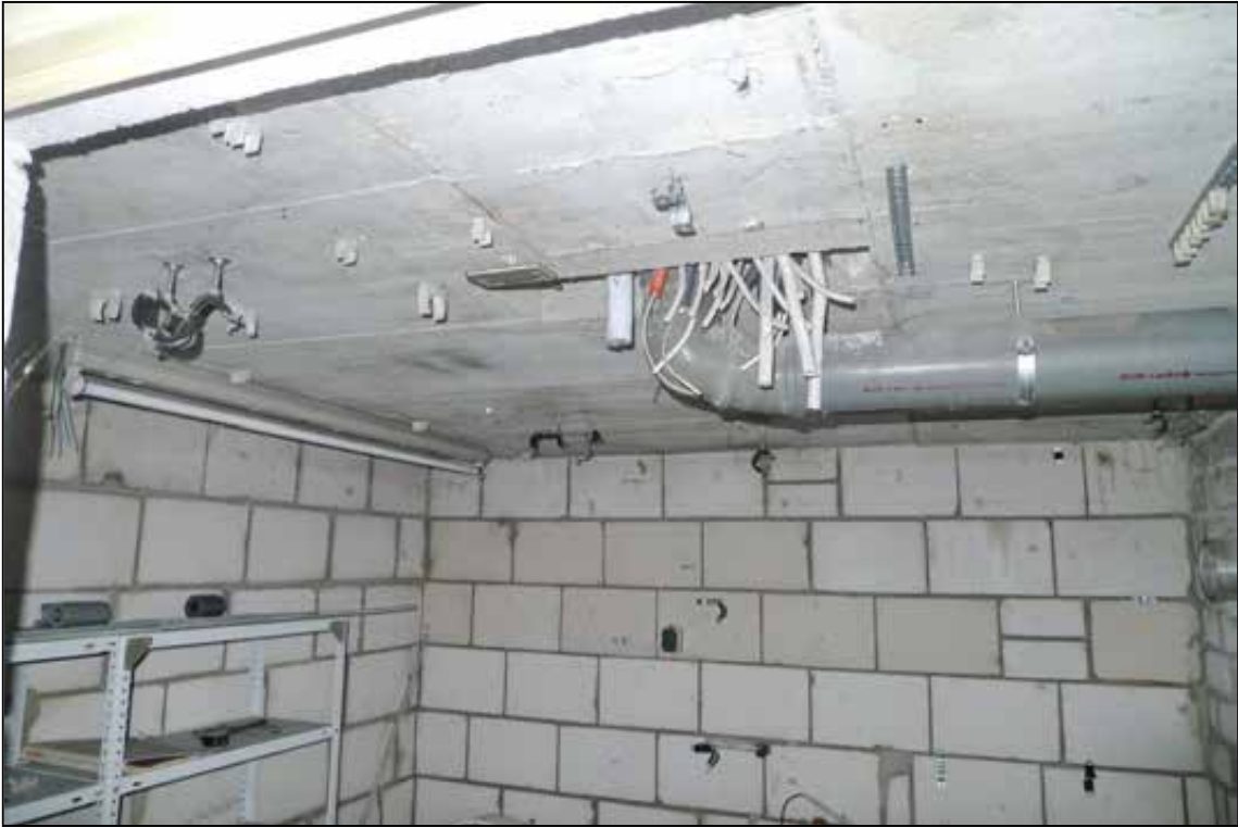
Abbildung 36 demontierte Leitungssysteme im gesamten Haus fotografiert am 24.01.2025
