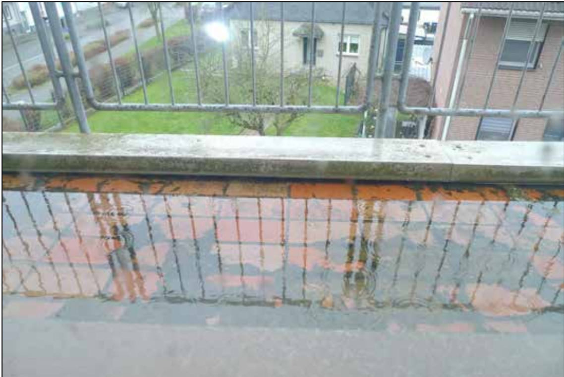
Abbildung 69 stehendes Wasser auf dem Balkon fotografiert am 24.01.2025
