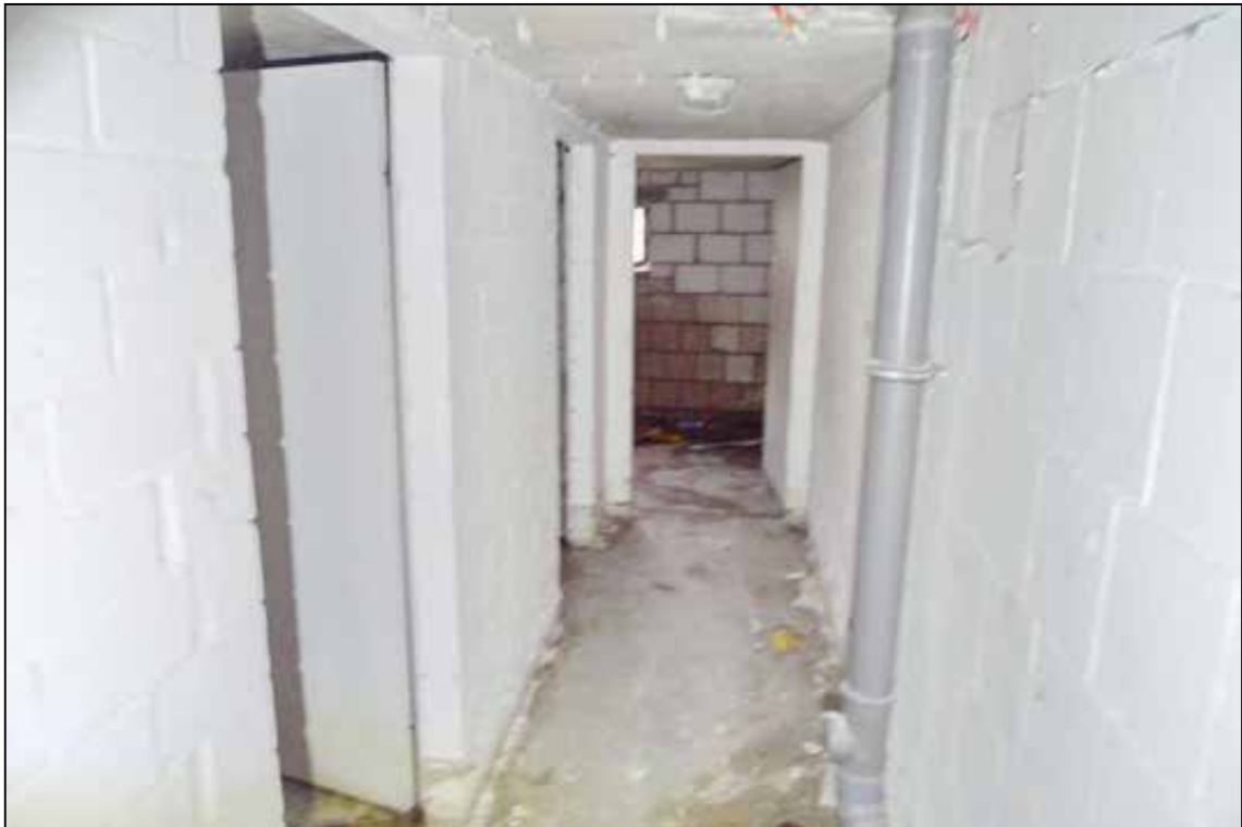
Abbildung 14 Flur im Kellergeschoss fotografiert am 24.01.2025
