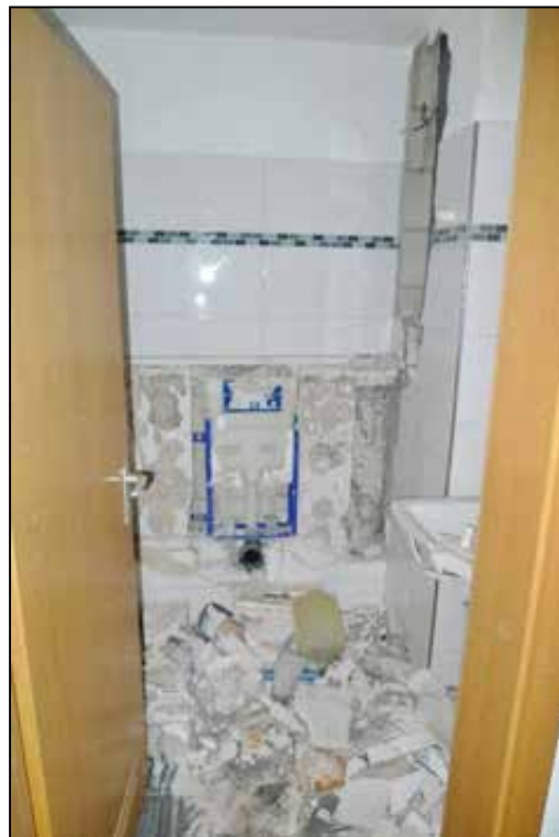
Abbildung 62 Bad des Wertermittlungsobjektes fotografiert am 24.01.2025
