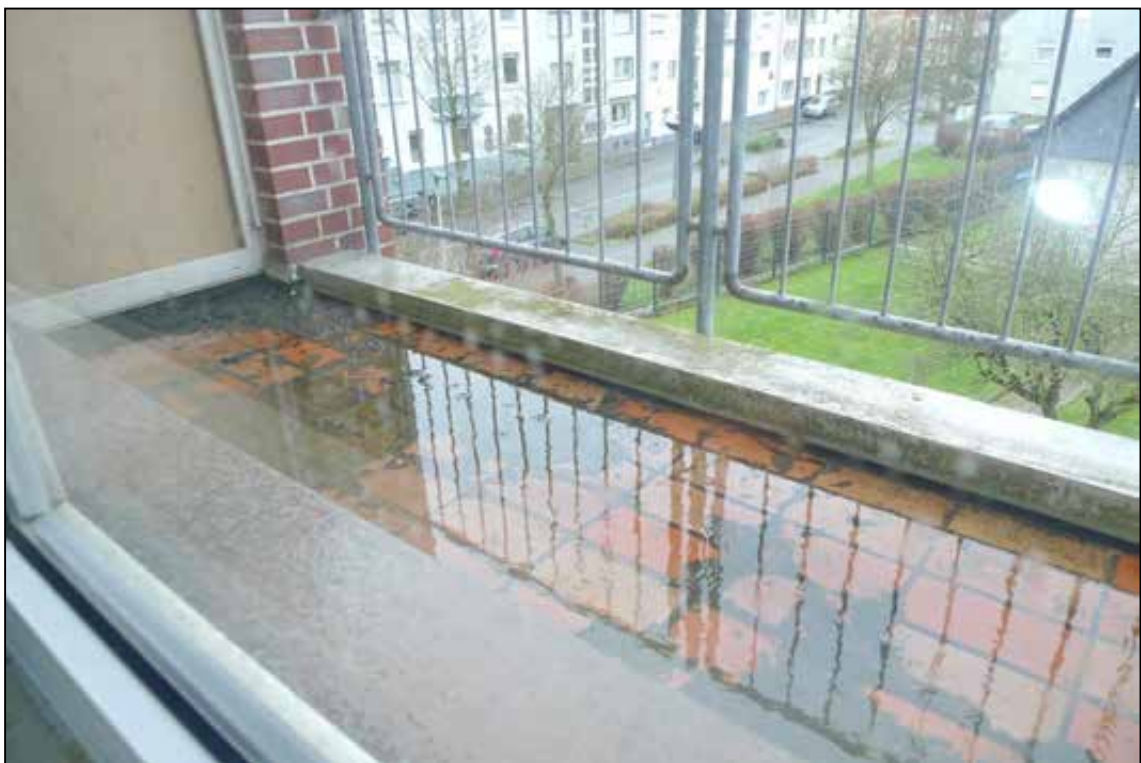
Abbildung 60 Balkon des Wertermittlungsobjektes fotografiert am 24.01.2025
