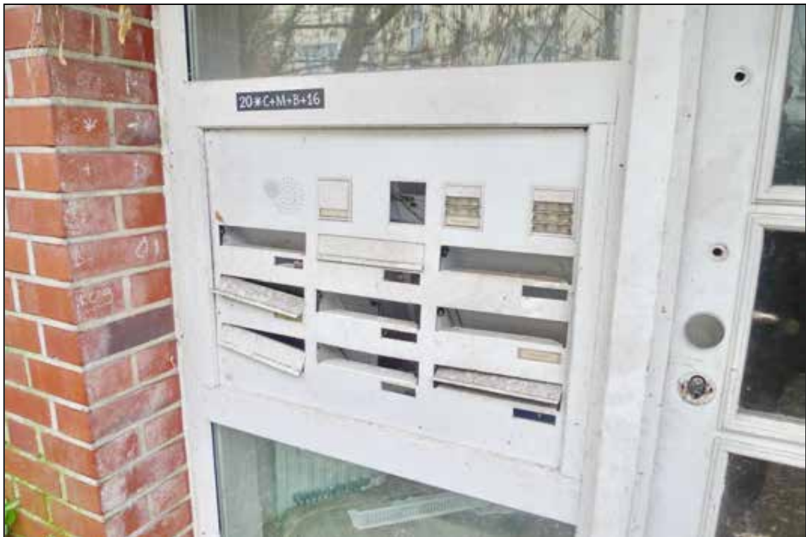
Abbildung 27 demolierte und defekte Briefkastenanlage fotografiert am 24.01.2025
