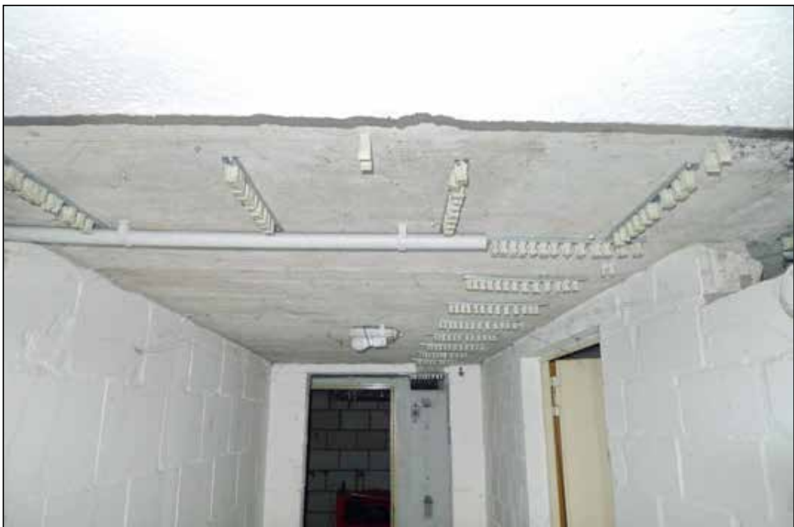
Abbildung 35 demontierte Leitungssysteme im gesamten Haus fotografiert am 24.01.2025
