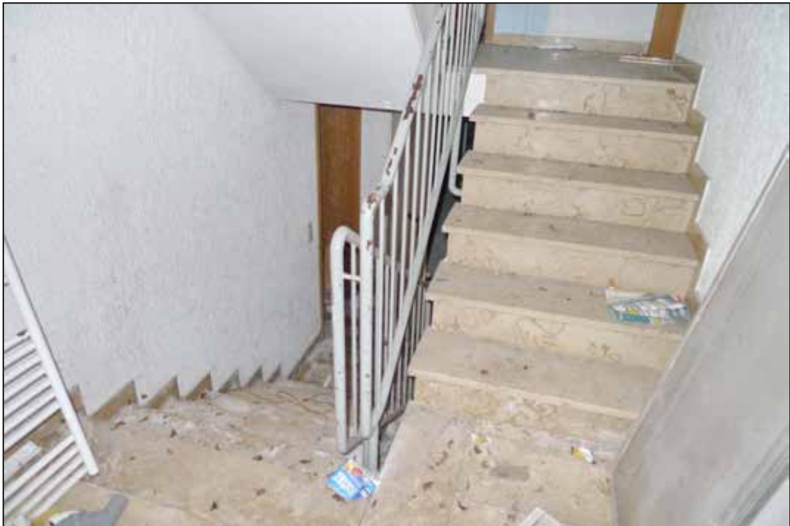
Abbildung 13 Eingangsbereich mit Treppe zum Kellergeschoss und zum Erdgeschoss fotografiert am 24.01.2025
