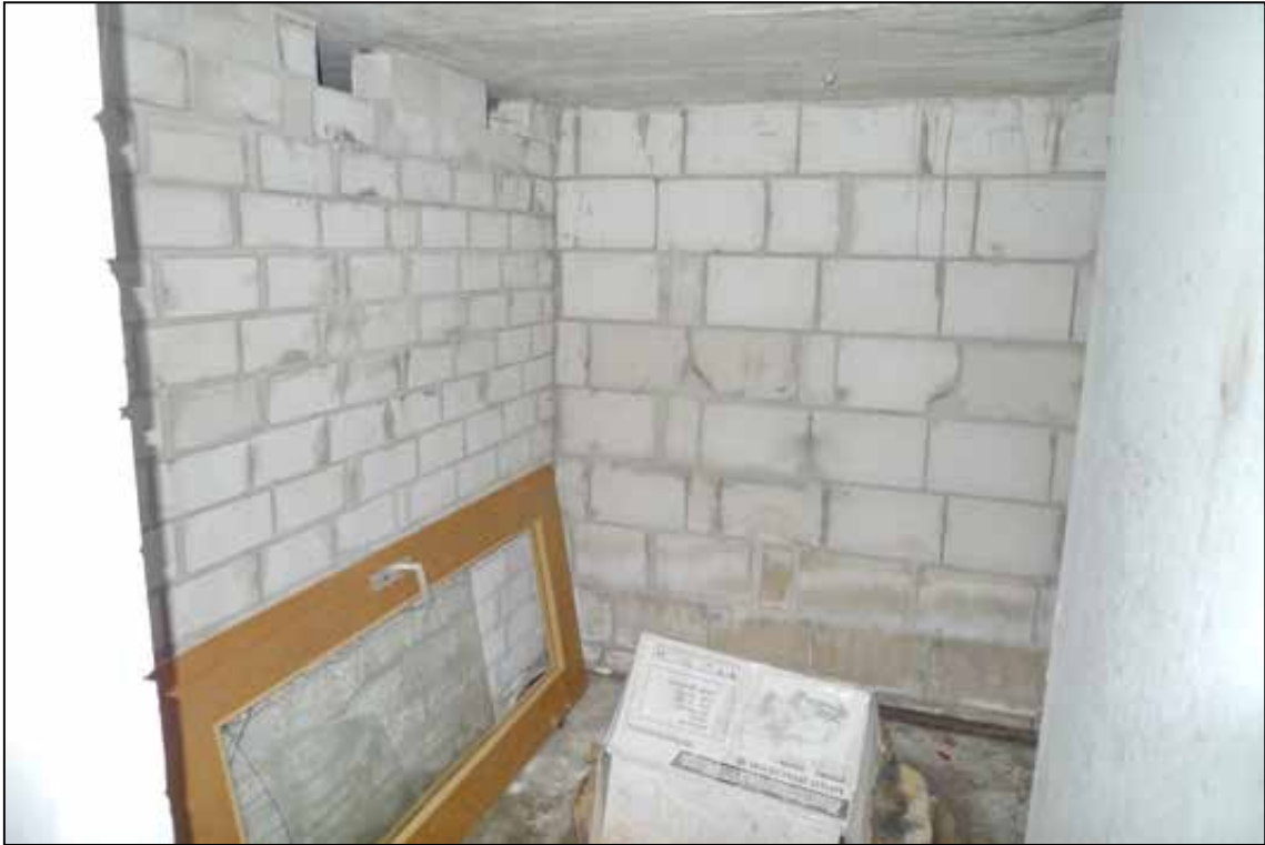
Abbildung 65 Kellerabteil des Wertermittlungsobjektes fotografiert am 24.01.2025
