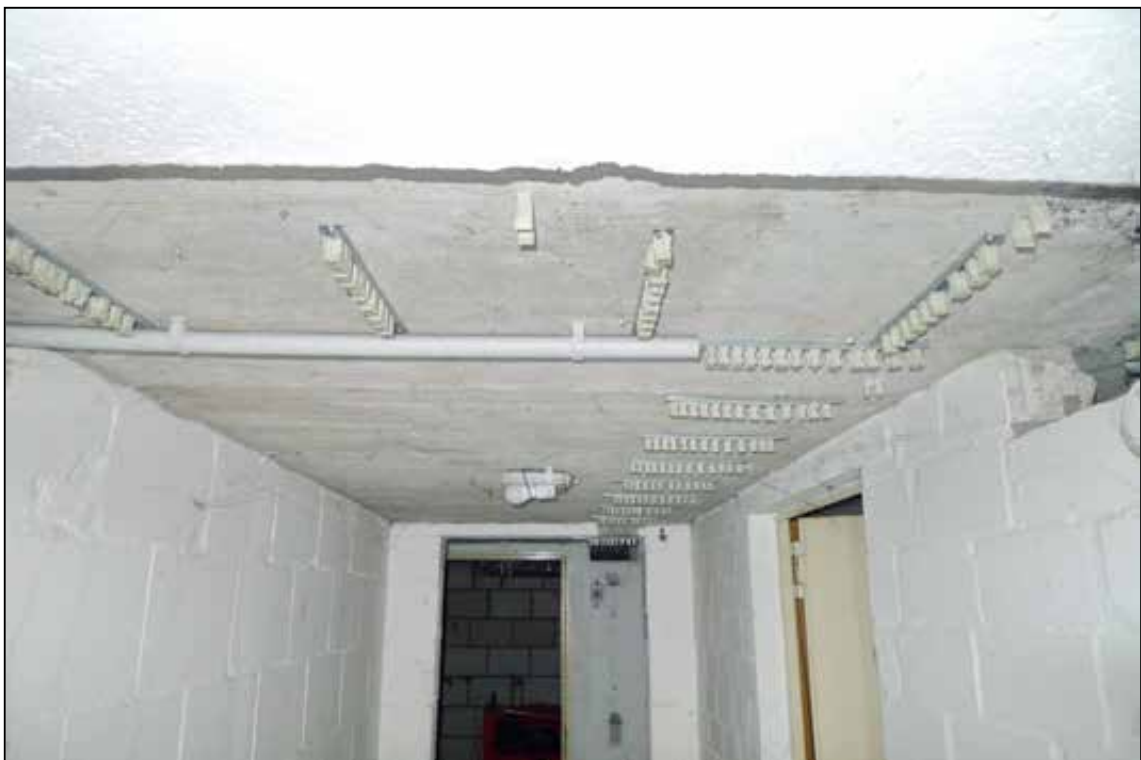
Abbildung 35 demontierte Leitungssysteme im gesamten Haus fotografiert am 24.01.2025
