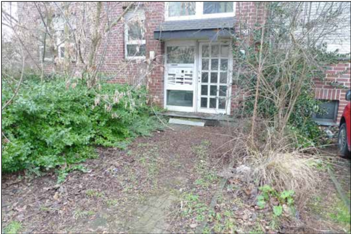
Abbildung 48 Hauszugang zur Mehrfamiliendoppelhaushälfte fotografiert am 24.01.2025
