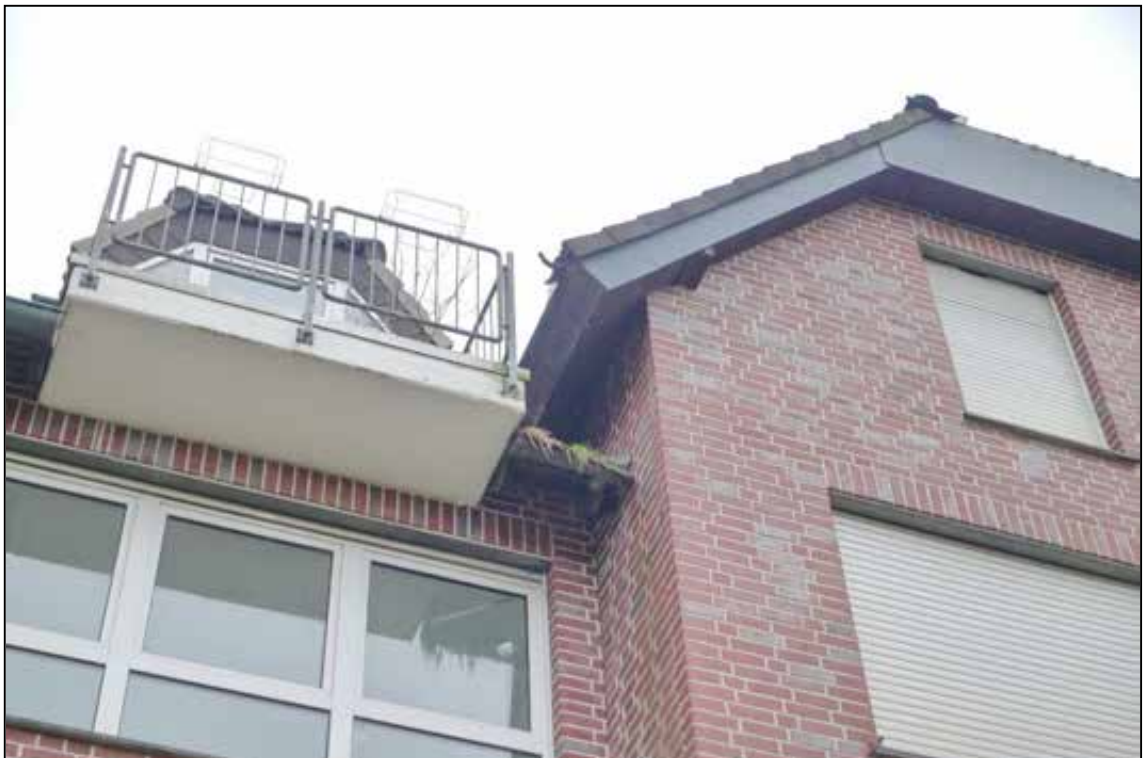
Abbildung 31 demontierte Regenfallrohre fotografiert am 24.01.2025
