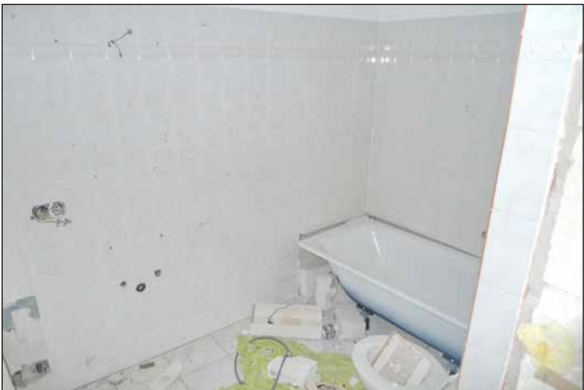
Abbildung 62 Bad des Wertermittlungsobjektes fotografiert am 24.01.2025
