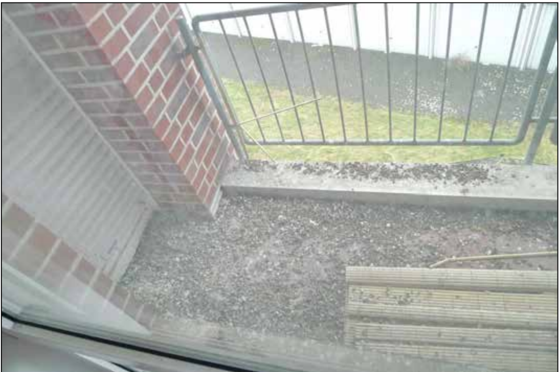
Abbildung 60 Balkon des Wertermittlungsobjektes fotografiert am 24.01.2025
