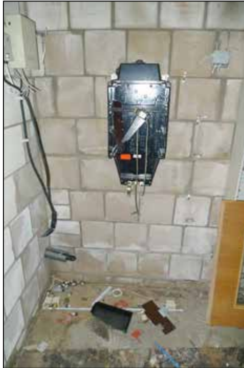
Abbildung 38 demontierte Hausanschlussleitungen fotografiert am 24.01.2025
