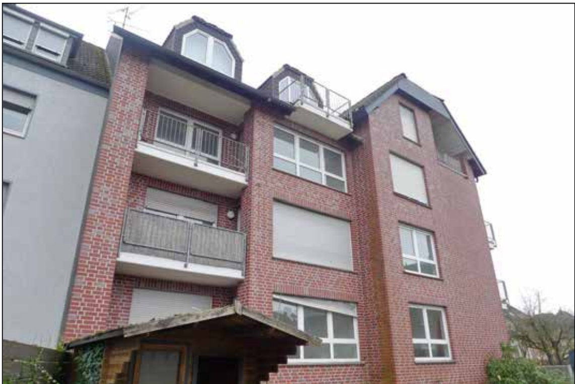
Abbildung 12 Rückansicht der baulichen Anlage Mehrfamiliendoppelhaushälfte fotografiert am 24.01.2025
