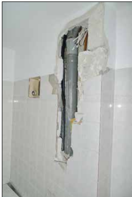
Abbildung 67 demoliertes Bad fotografiert am 24.01.2025
