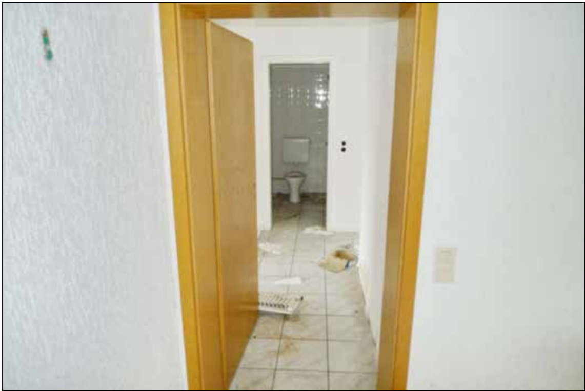
Abbildung 55 Wohnungseingangstür und Eingangsbereich des Wertermittlungsobjektes fotografiert am 24.01.2025
