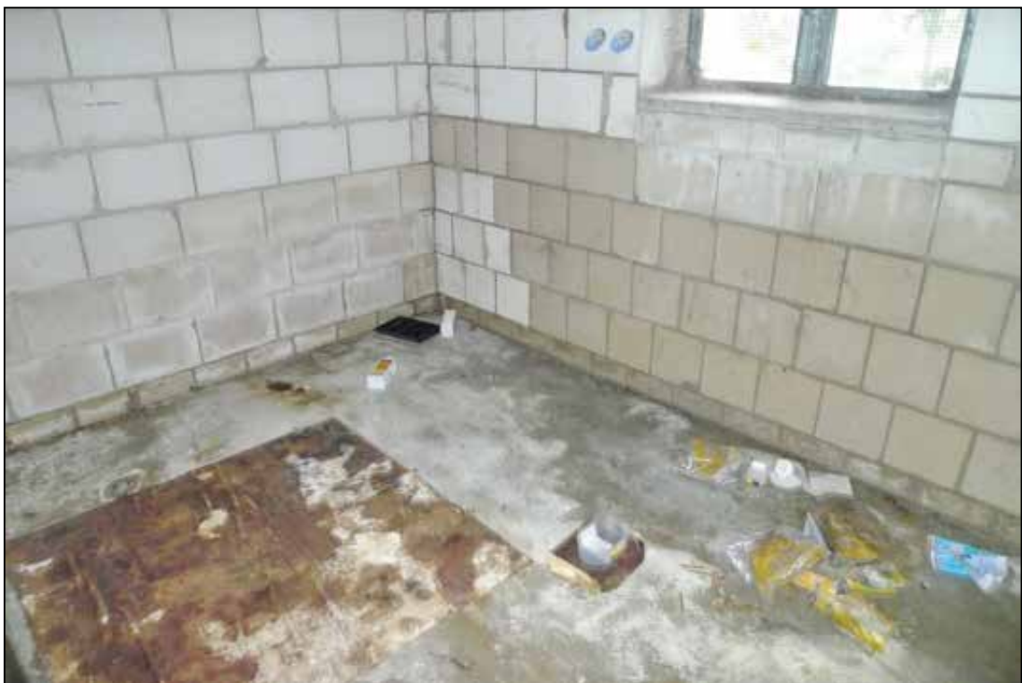
Abbildung 64 Kellerabteil des Wertermittlungsobjektes fotografiert am 24.01.2025
