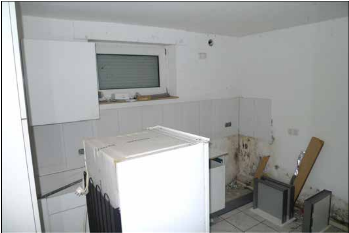
Abbildung 60 Küche des Wertermittlungsobjektes fotografiert am 24.01.2025
