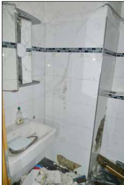
Abbildung 57 Bad des Wertermittlungsobjektes fotografiert am 24.01.2025
