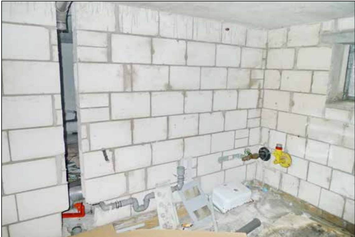
Abbildung 62 Kellerraum des Wertermittlungsobjektes fotografiert am 24.01.2025
