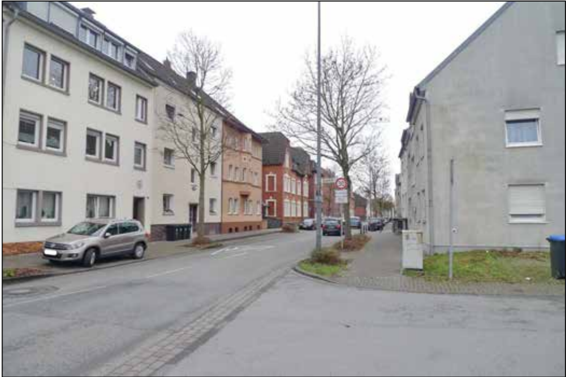
Abbildung 3 Umgebungsbebauung des Wertermittlungsobjektes fotografiert am 24.01.2025
