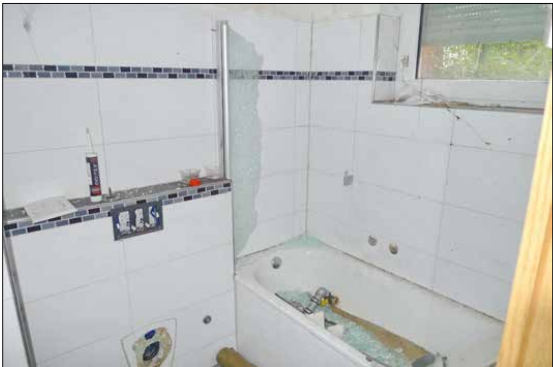
Abbildung 69 demoliertes Badezimmer fotografiert am 24.01.2025
