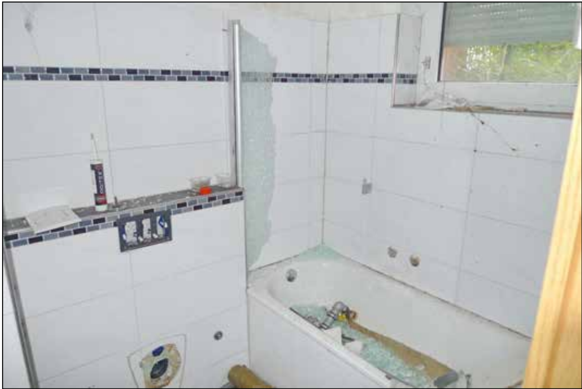
Abbildung 56 Bad des Wertermittlungsobjektes fotografiert am 24.01.2025
