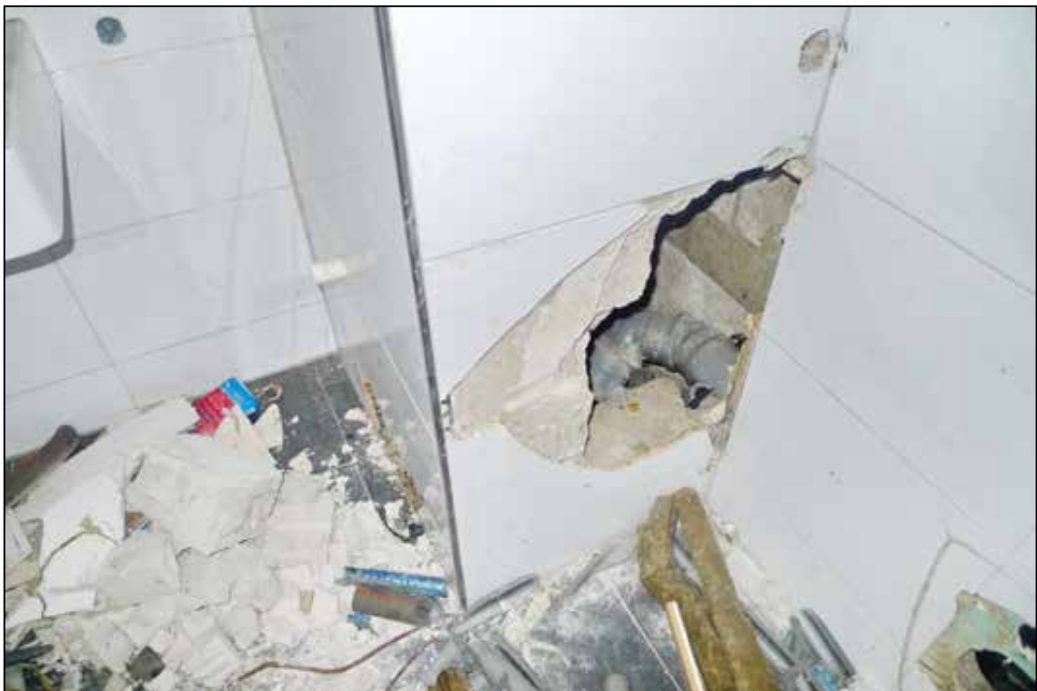
Abbildung 65 aufgebroschene Wände mit entfernten Leitungen fotografiert am 24.01.2025
